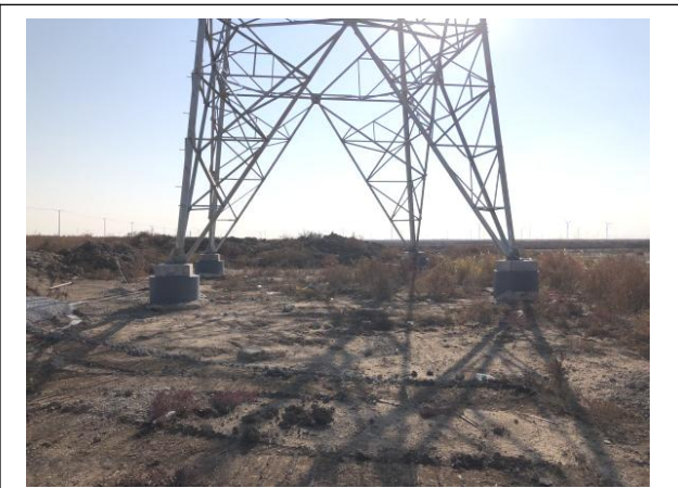
15 号塔 撒播草籽 (2021.12)
