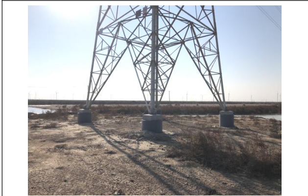
16 号塔 撒播草籽 (2021.12)
