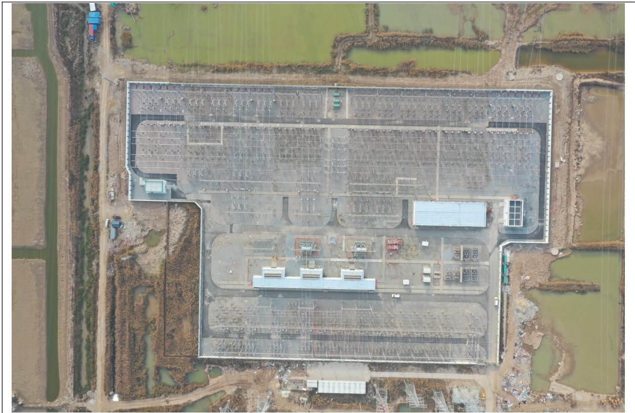
扩建间隔区 硬化 (2021.12)
