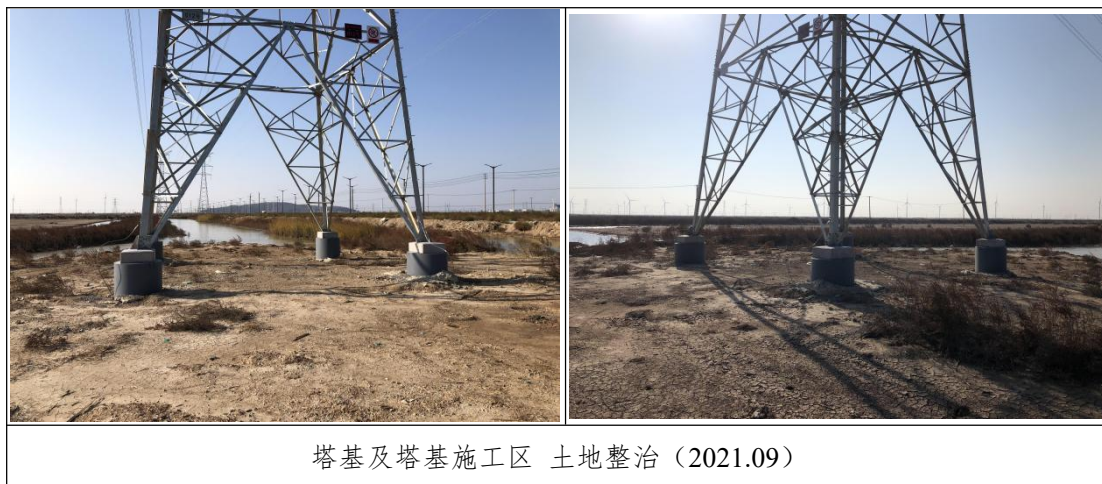
图 4-1 工程措施实施情况
