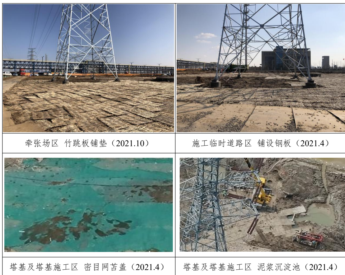
图 4-3 临时措施实施情况
