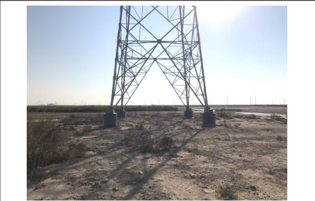
17 号塔 撒播草籽 (2021.12)
