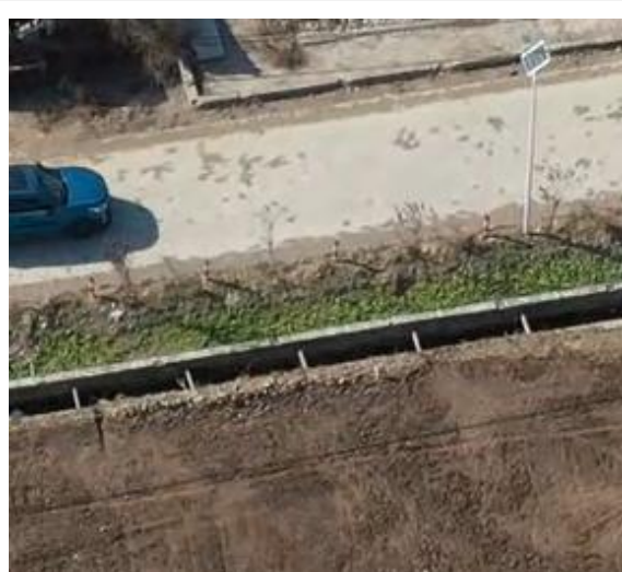
电缆施工区现状（2021年12月）
