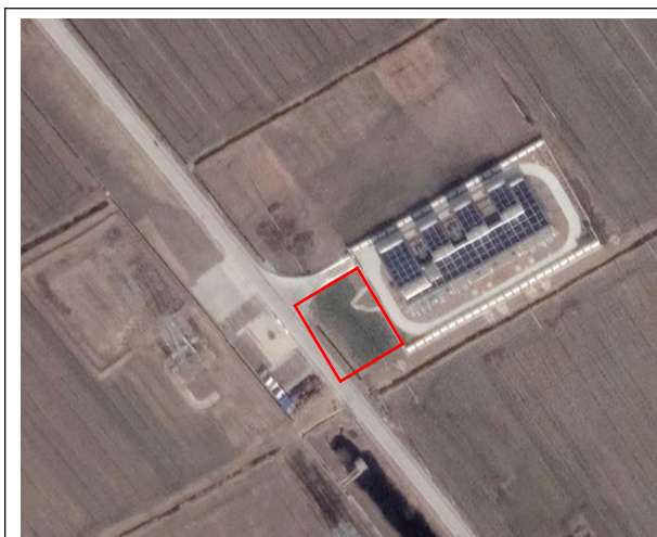
电缆施工区施工前影像（2020年12月）
