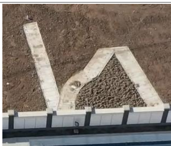
电缆施工区现状（2021年12月）
