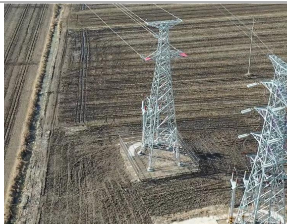
T1塔现状（2021年12月）
