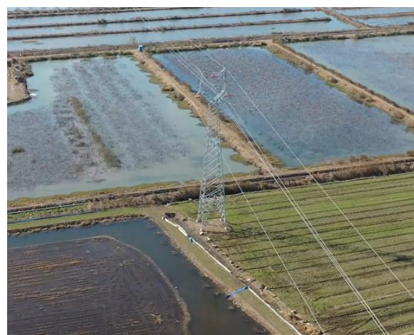
T19塔现状（2021年12月）
