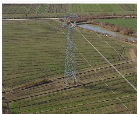
T2塔现状（2021年12月）
