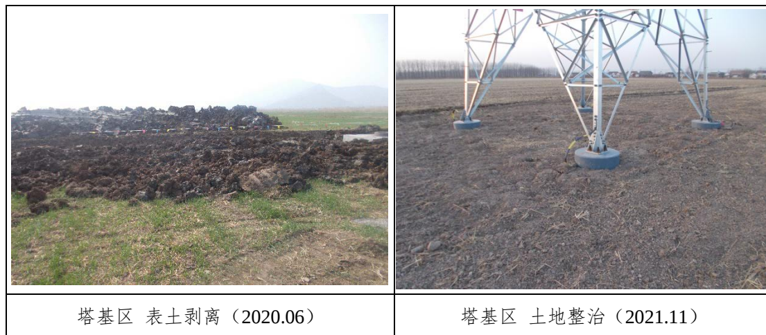
图 4-1 工程措施实施情况
