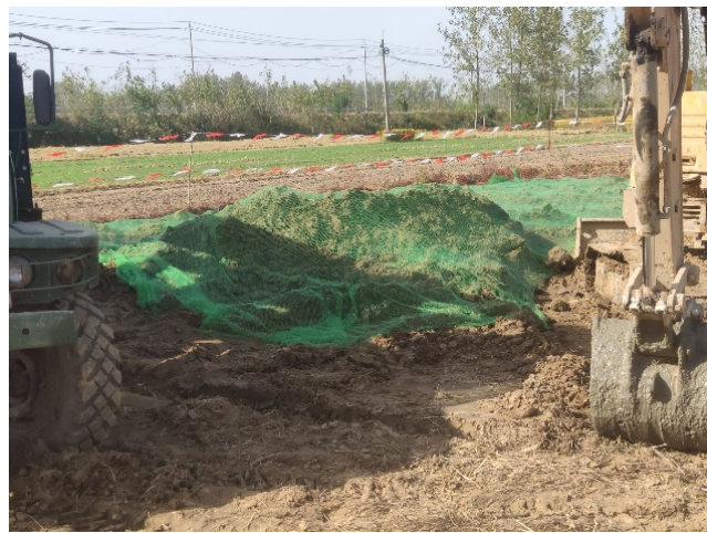
塔基区 密目网苫盖 (2020 年 6 月)
