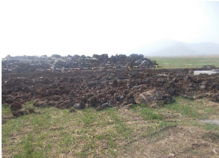
#6 塔 表土剥离 (2020 年 5 月)
