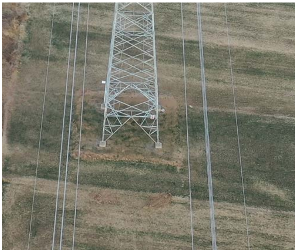
塔基区植被正在恢复，现场情况良好
