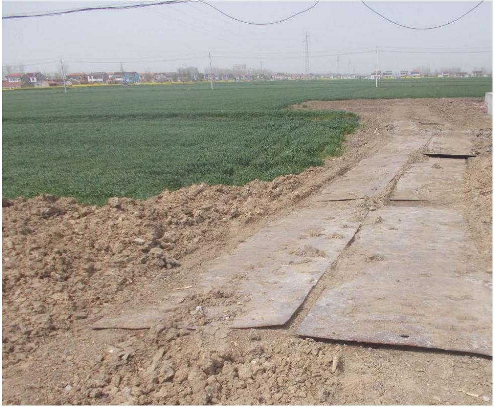
施工临时道路区已采取钢板铺设措施，现场情况良好
