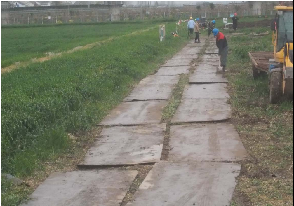
施工临时道路区已采取钢板铺设措施
