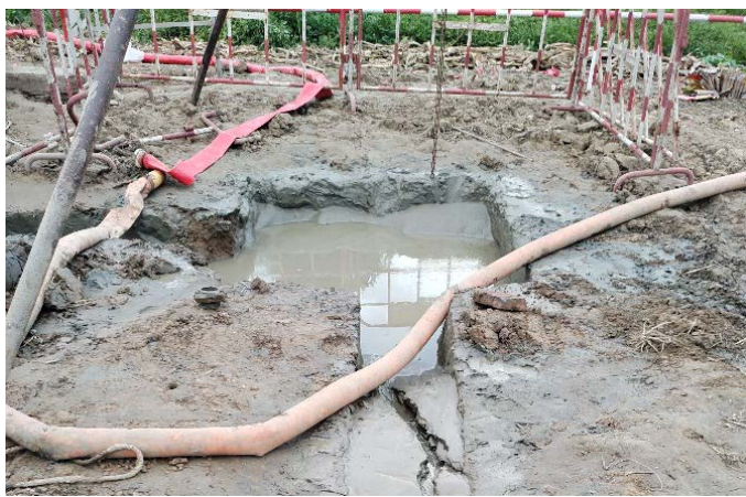
#6 塔 泥浆沉淀池 (2020 年 6 月)
