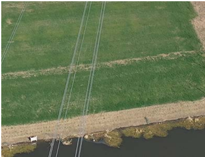
跨越场地施工区 撒播草籽 (2021 年 12 月)
