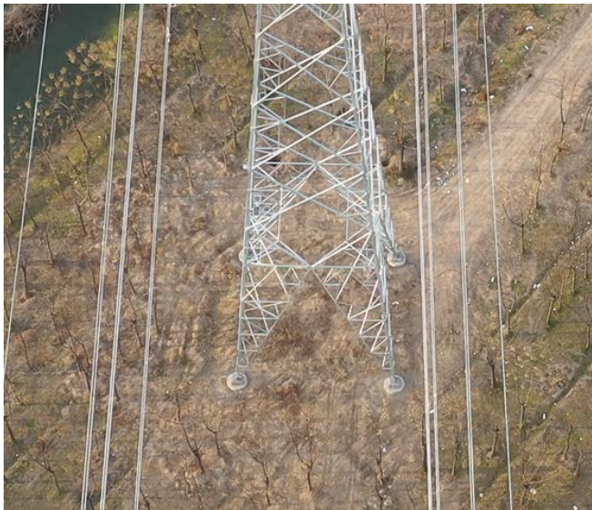
#3 塔，撒播草籽（2021 年 12 月）
