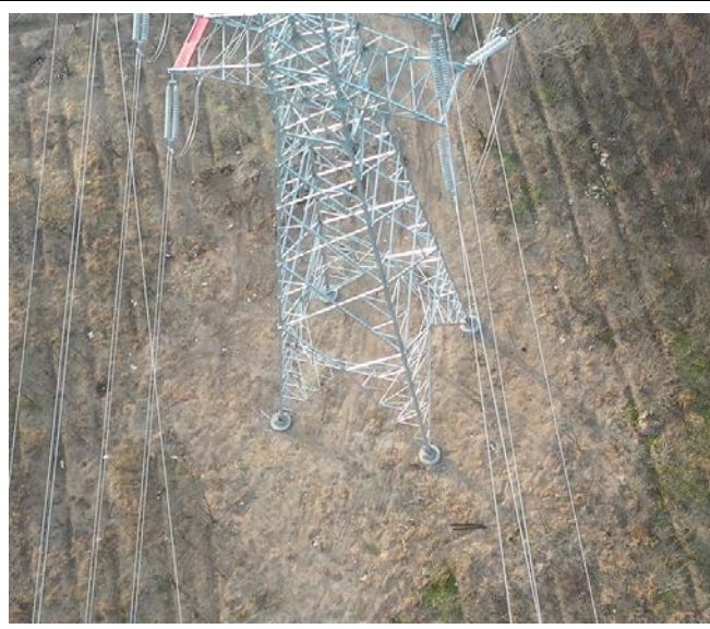
#2 塔 撒播草籽 (2021 年 11 月)
