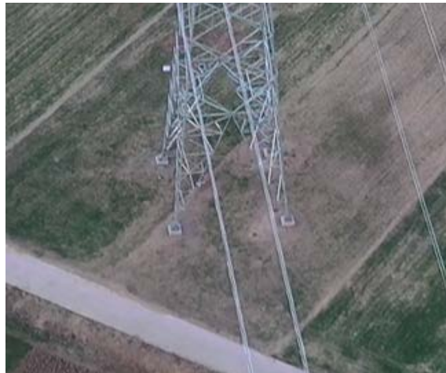
#17 塔 撒播草籽 (2021 年 12 月)
