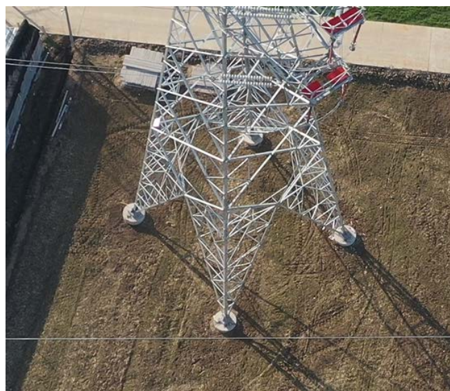
#61 塔 撒播草籽 (2021 年 12 月)
