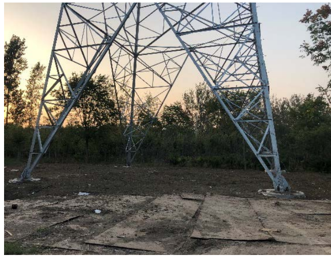
施工临时道路区 铺设钢板 (2021.10)
