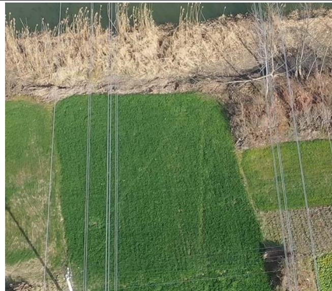
跨越场地施工区 撒播草籽 (2021 年 12 月)
