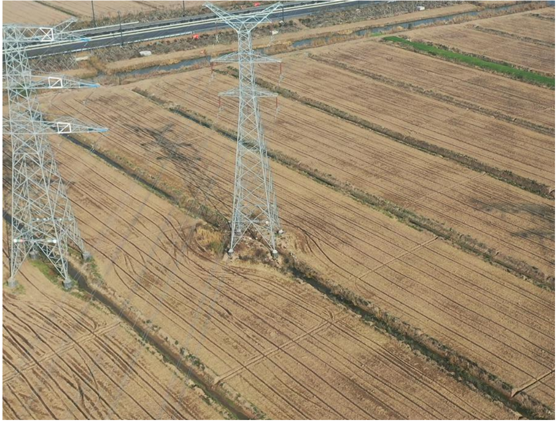
2021年12月15日 T29塔基施工区复耕
