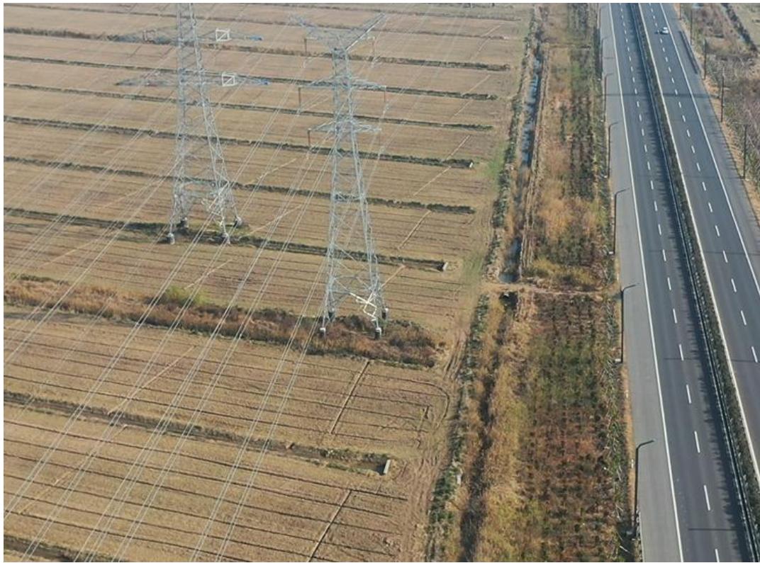
2021年12月15日 T36塔基施工区复耕
