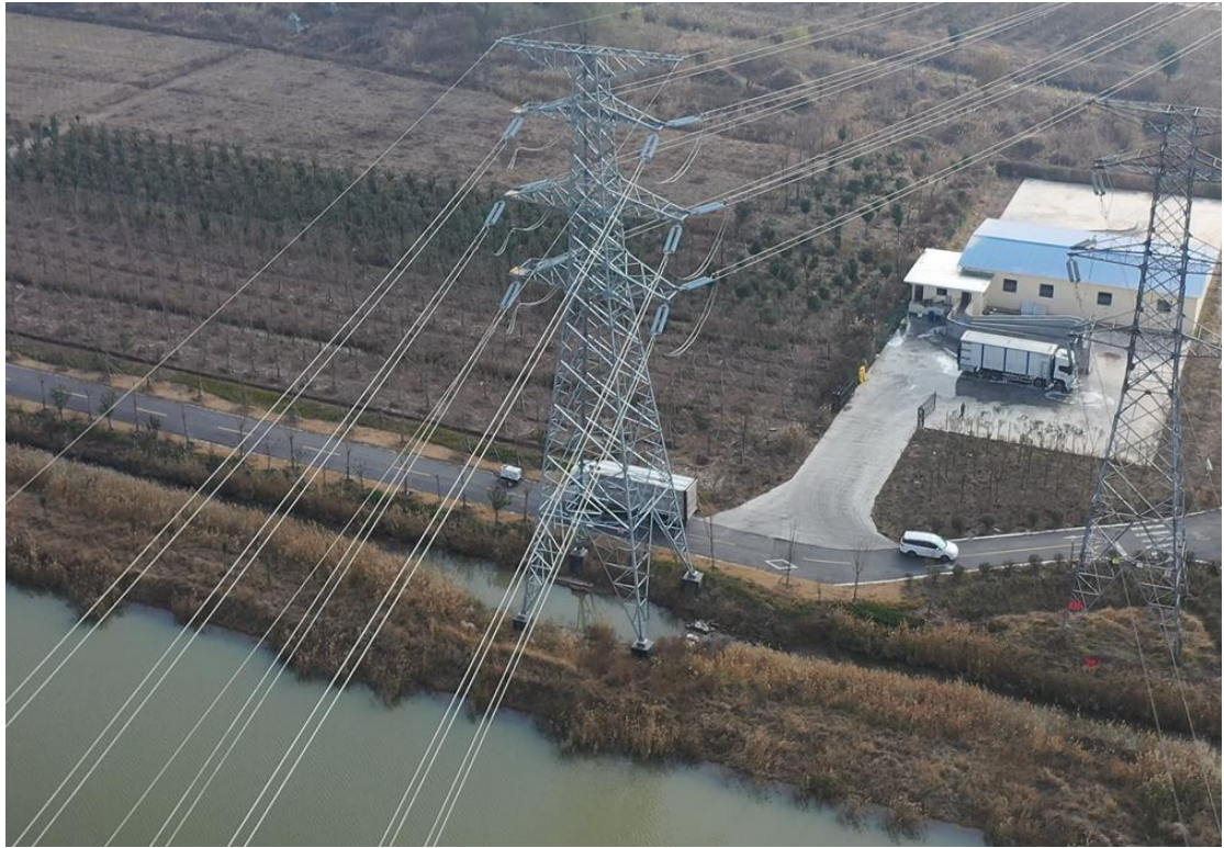
2021年12月15日 T45塔基施工区撒播草籽
