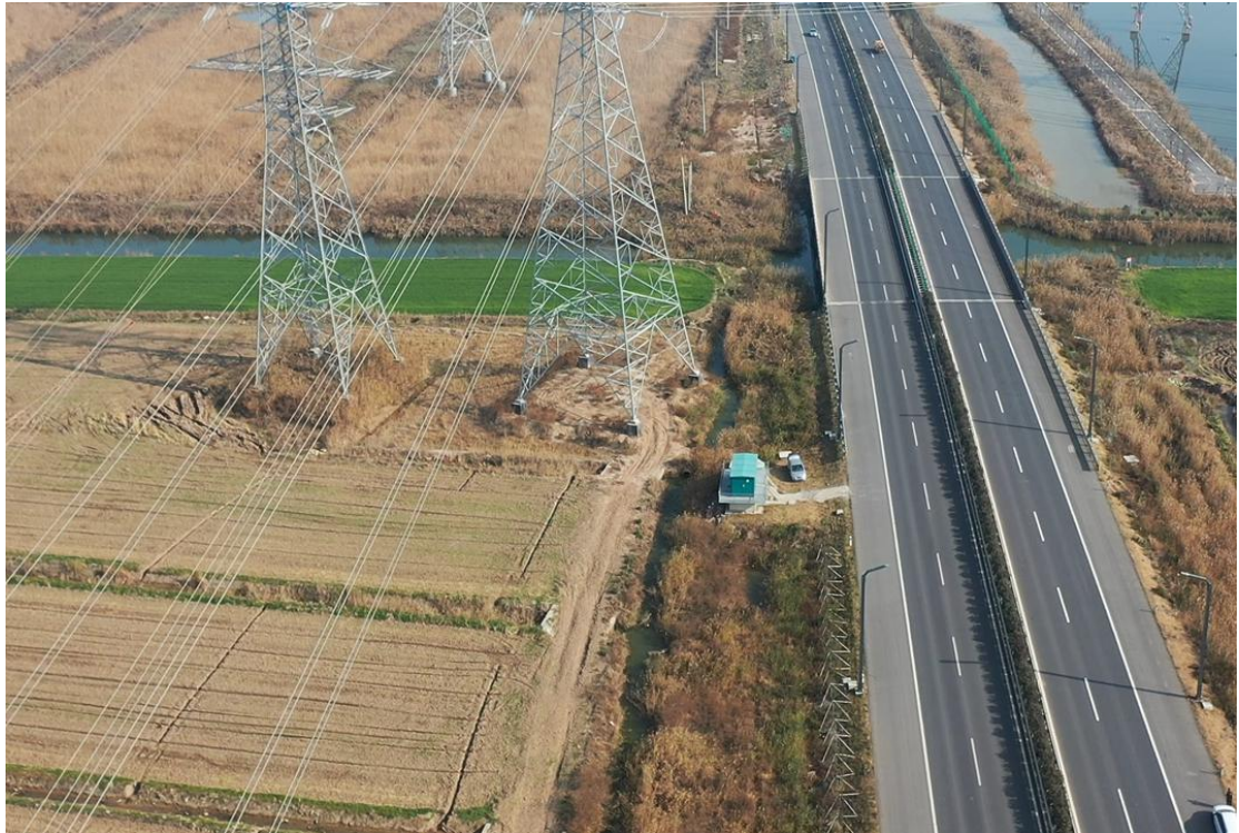
2021年12月15日 T43塔基施工区复耕
