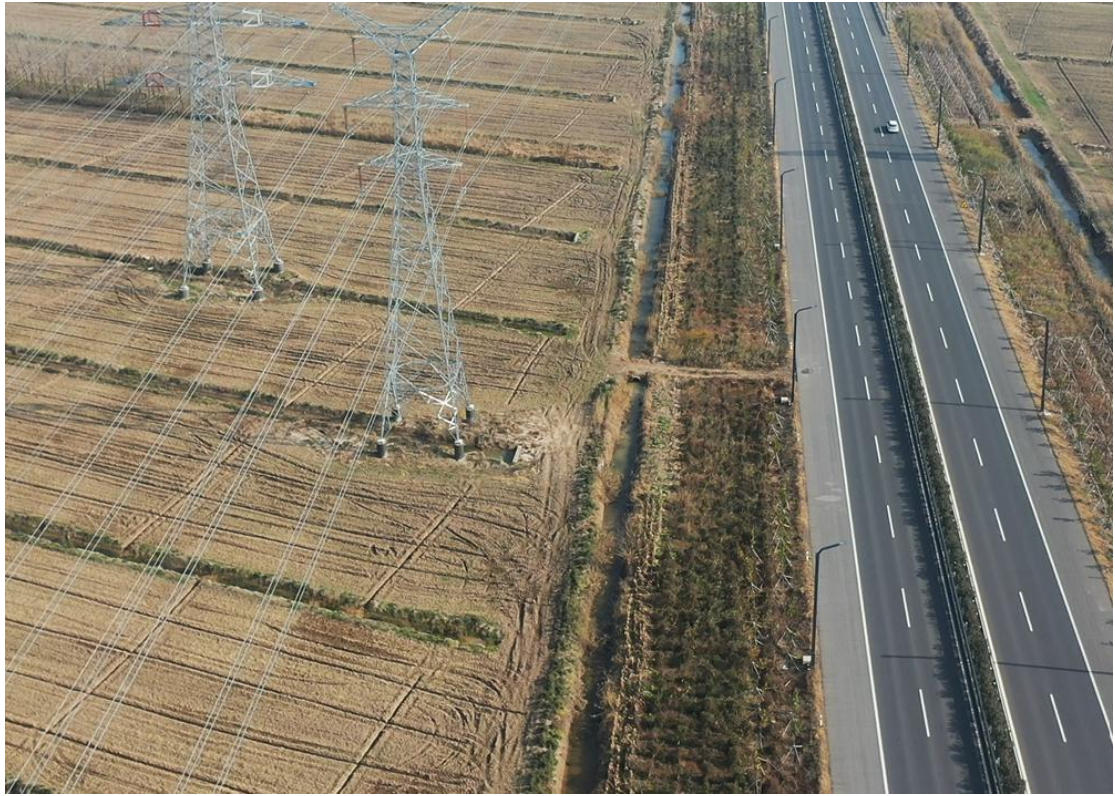
2021年12月15日 T35塔基施工区复耕
