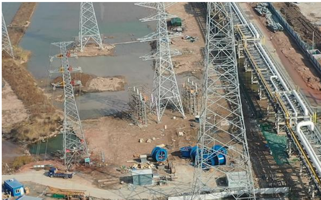
2021年12月15日 T25塔基施工区恢复盐田
