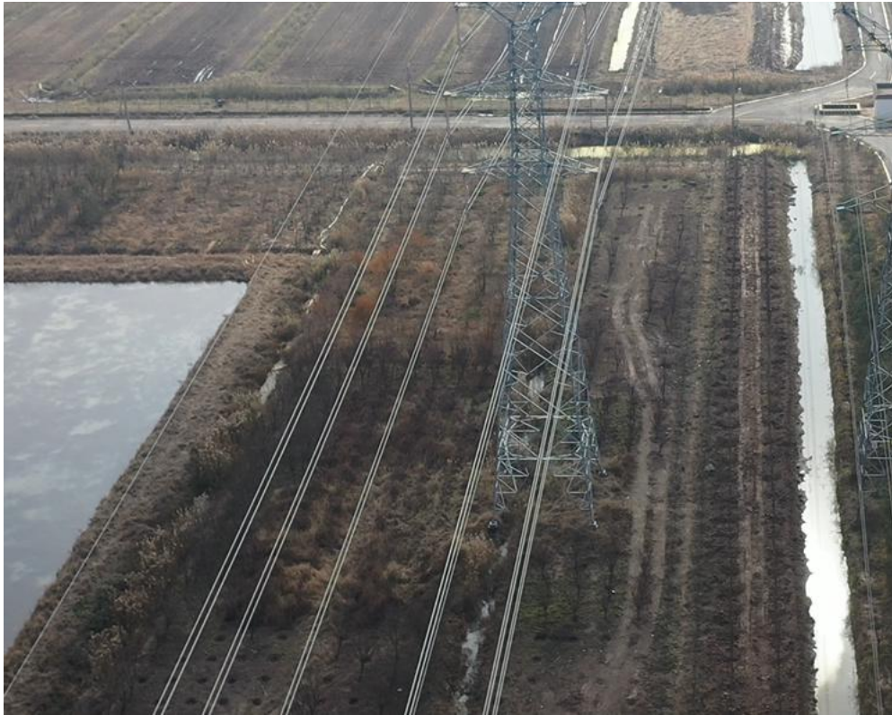
2021年12月15日 T47塔基施工区复耕
