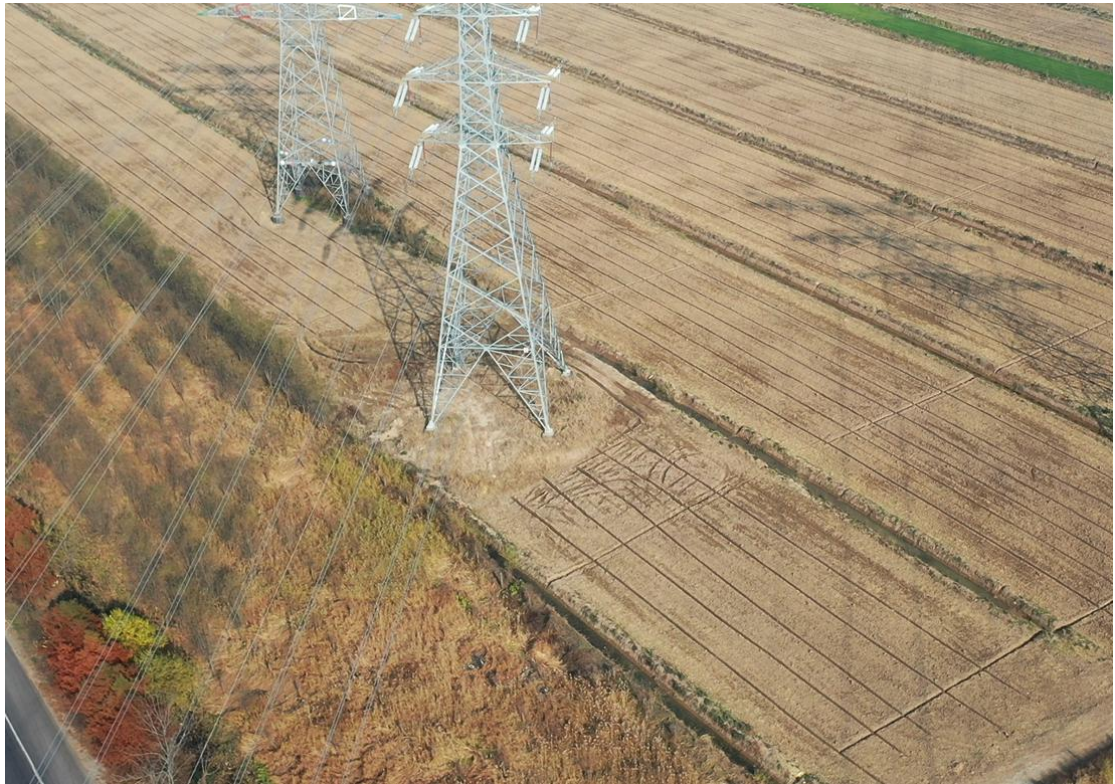
2021年12月15日 T28塔基施工区复耕
