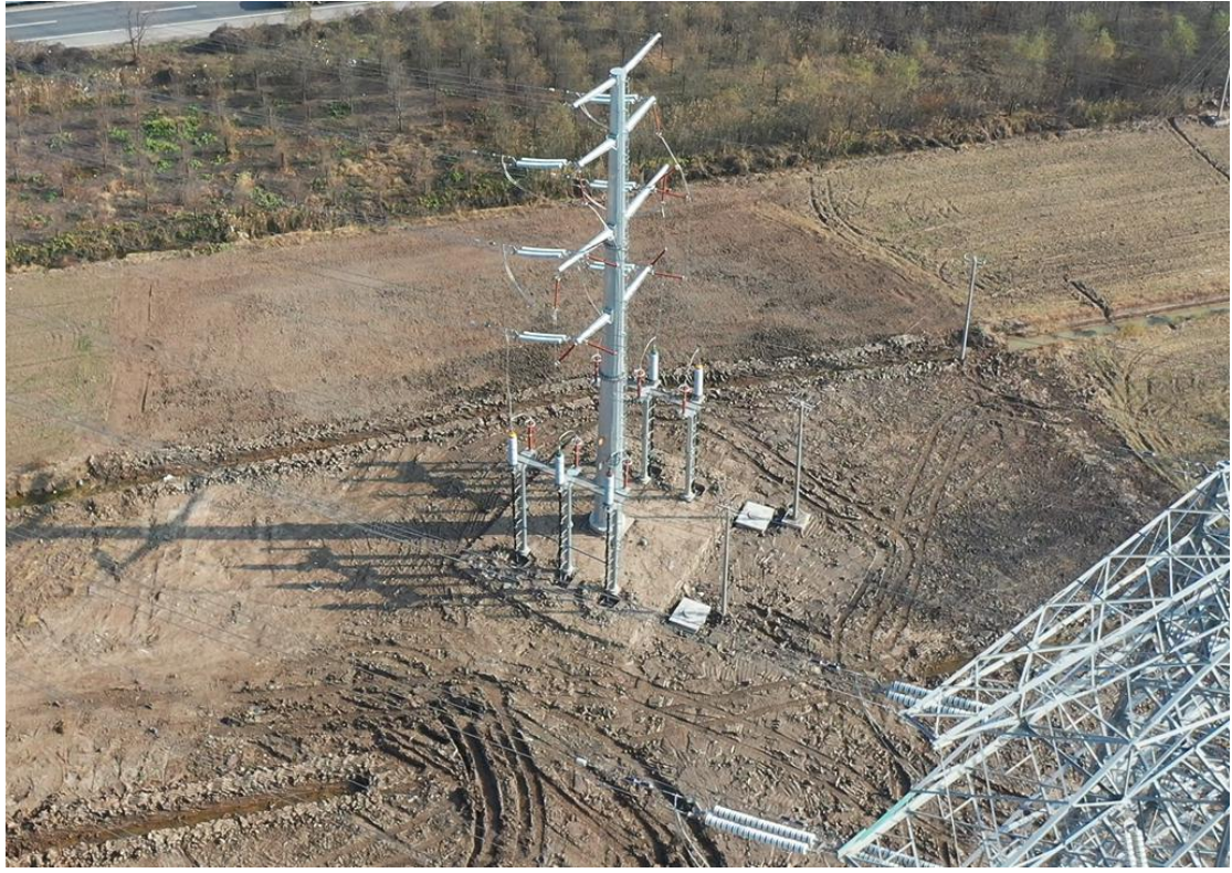
2021年12月15日 T27塔基施工区复耕
