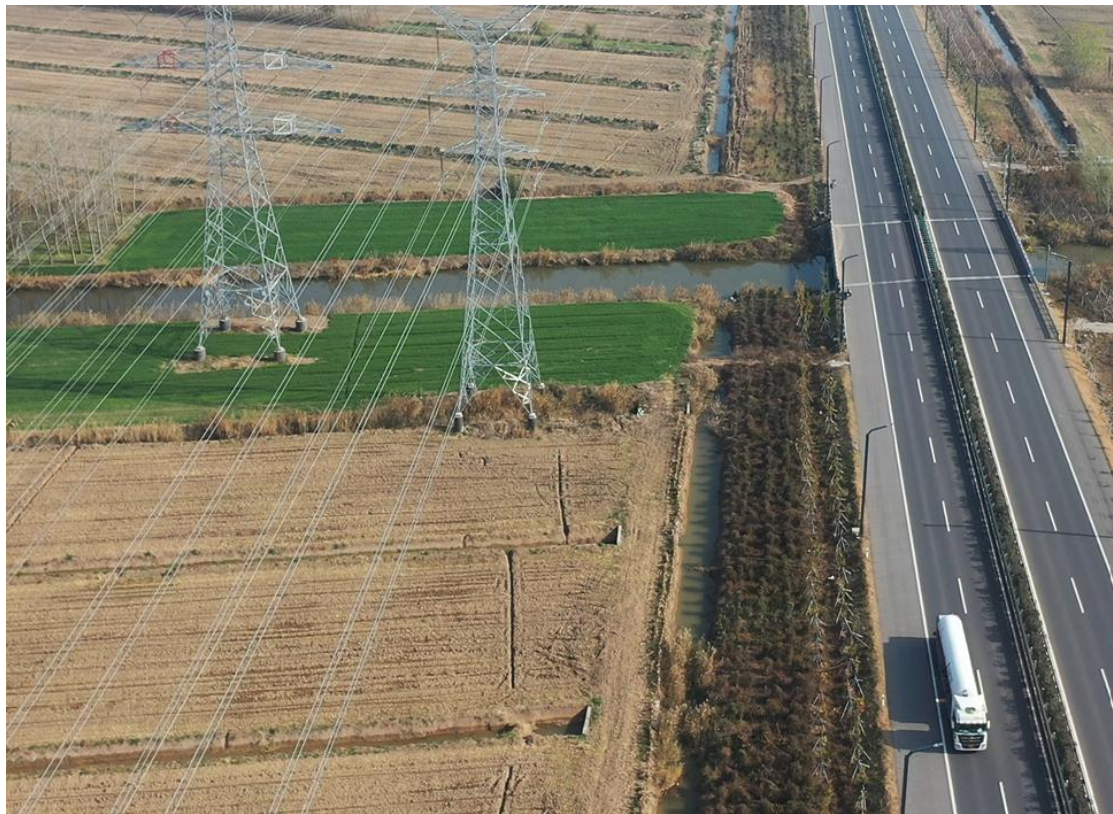
2021年12月15日 T34塔基施工区复耕
