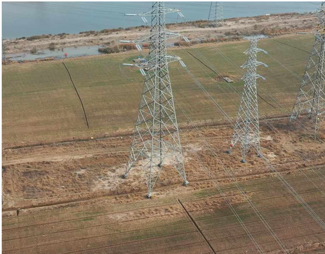
2021年12月15日 T56塔基施工区复耕
