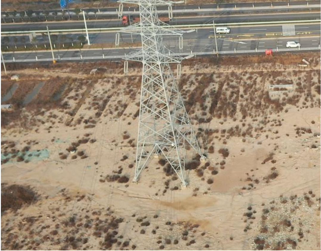
2021年12月15日 T1塔基施工区撒播草籽
