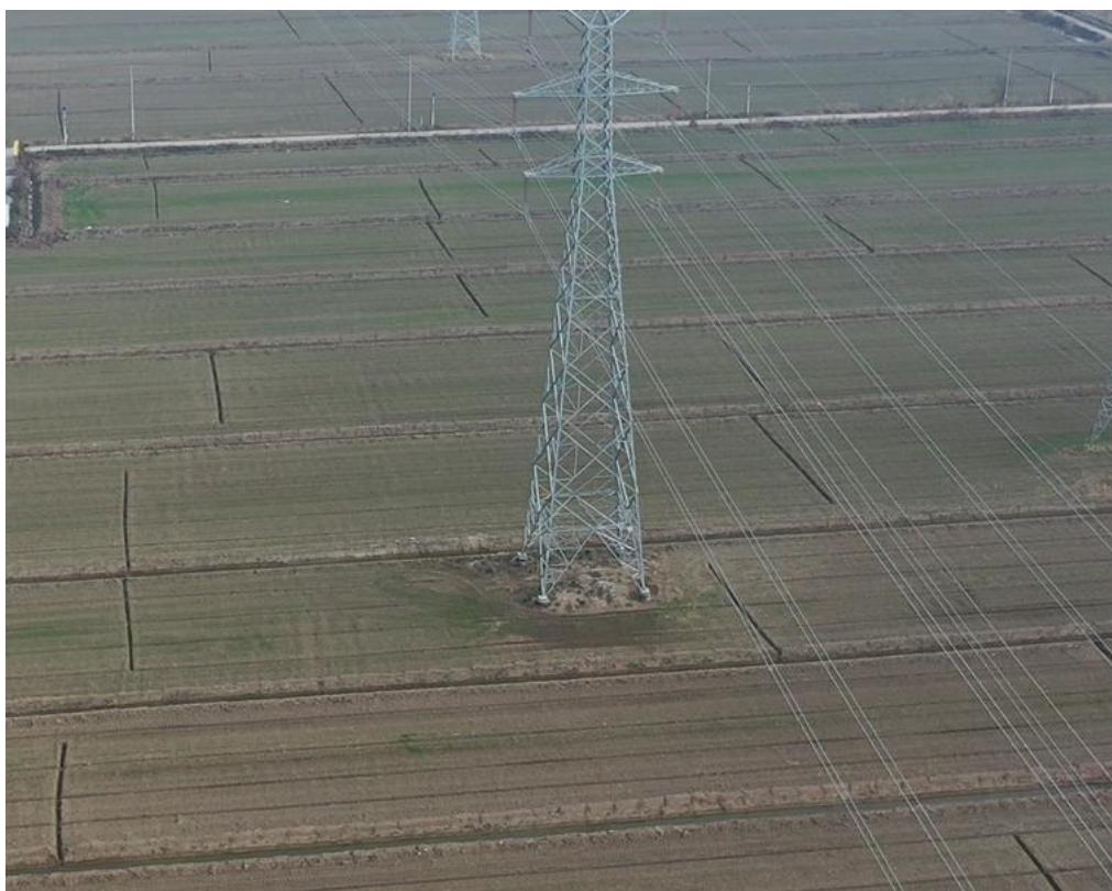
2021年12月15日 T53塔基施工区复耕
