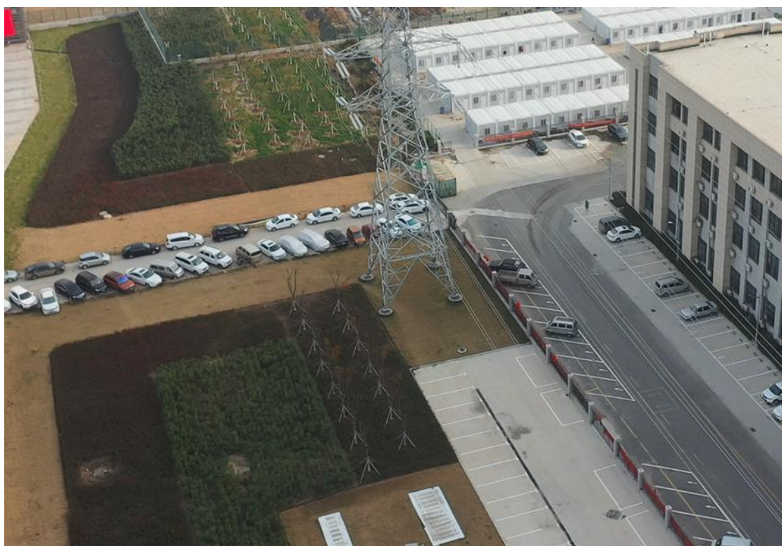
2021年12月15日 T13塔基施工区撒播草籽
