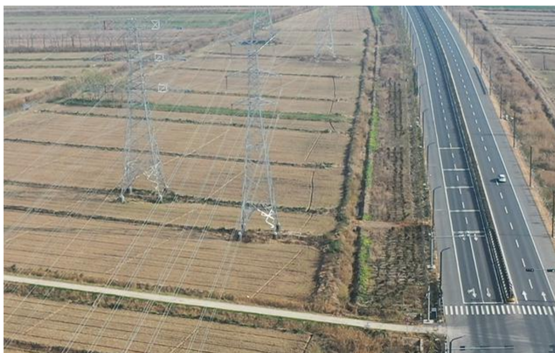
2021年12月15日 T38塔基施工区复耕
