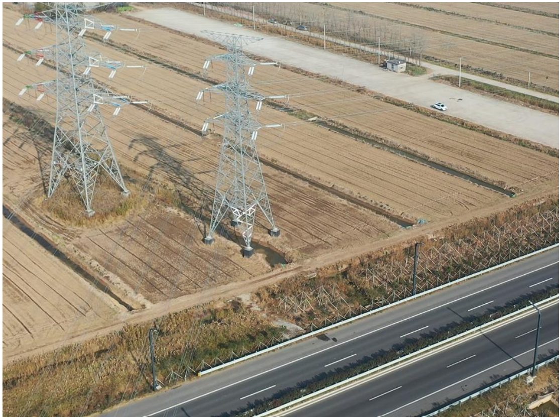
2021年12月15日 T30塔基施工区复耕
