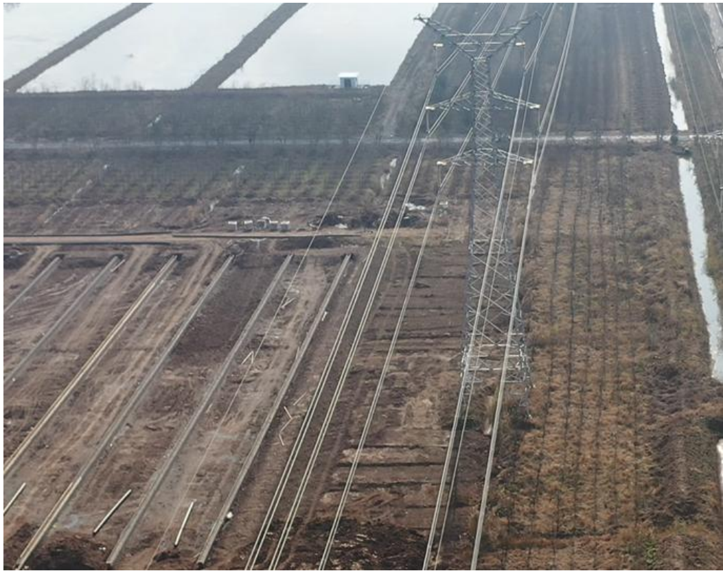
2021年12月15日 T46塔基施工区复耕
