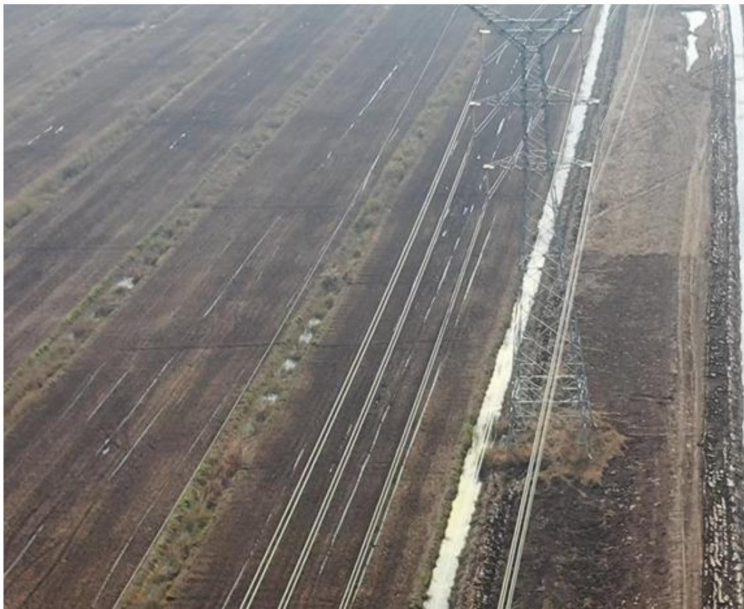
2021年12月15日 T48塔基施工区复耕
