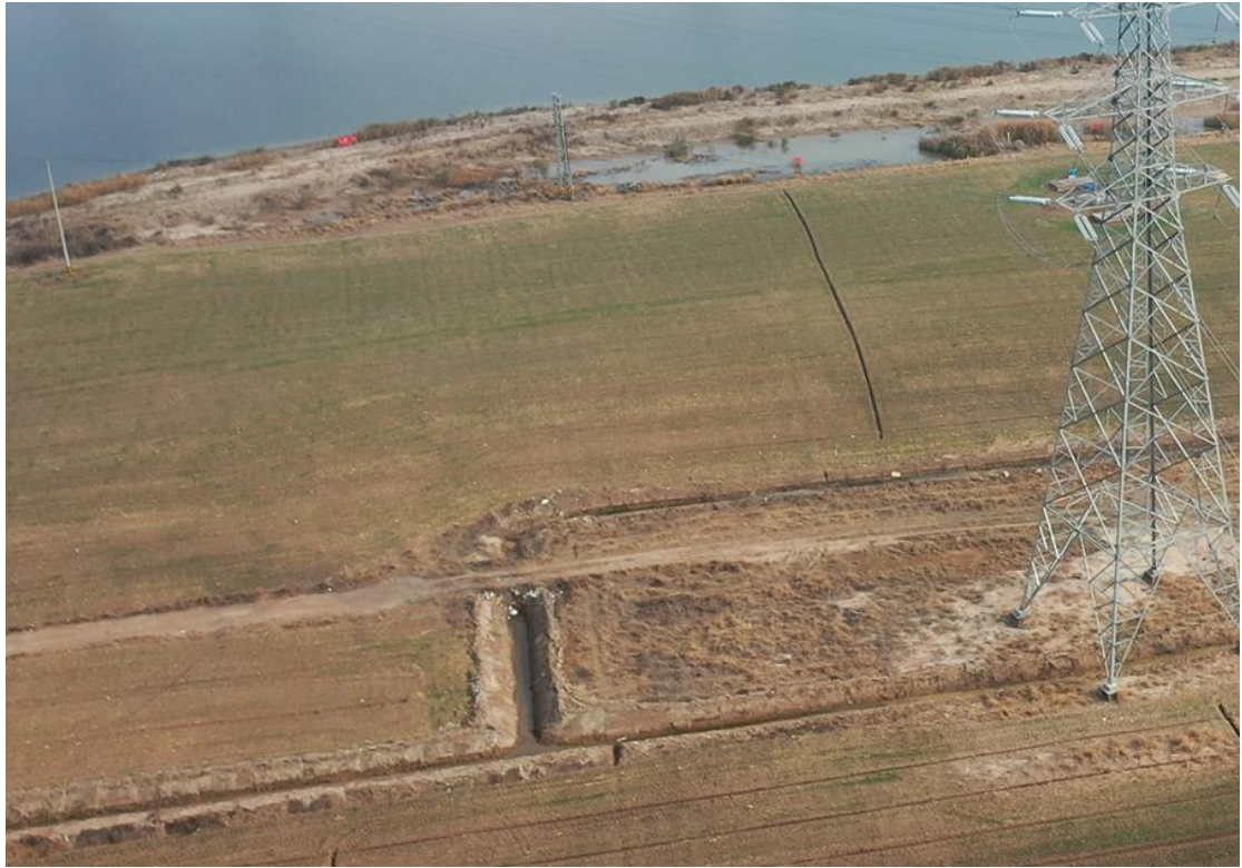
2021年12月15日 T71施工临时道路区复耕
