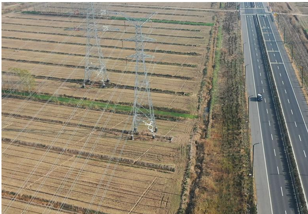
2021年12月15日 T37塔基施工区复耕
