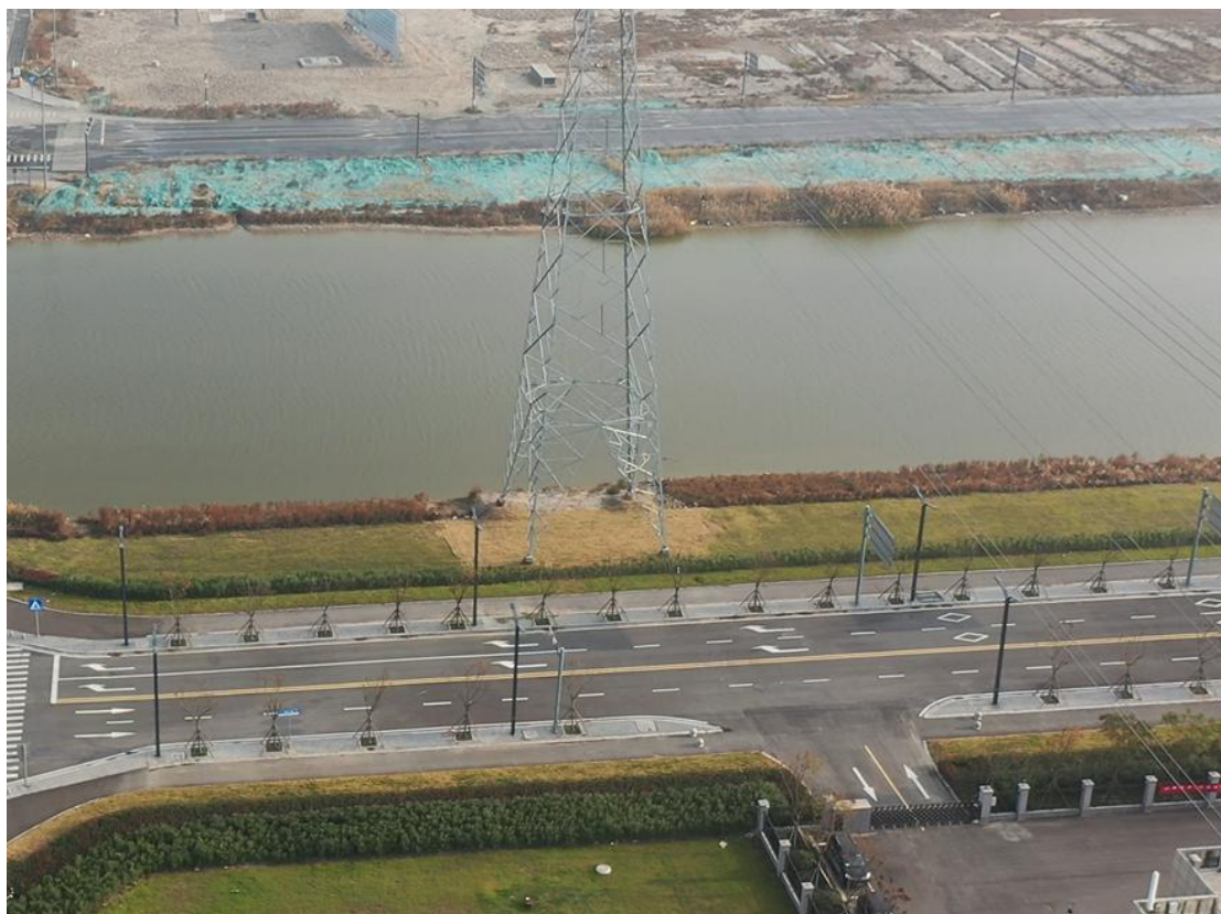
2021年12月15日 T3塔基施工区撒播草籽
