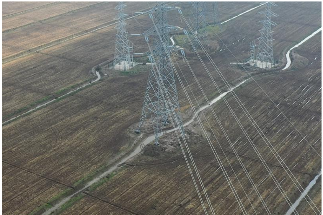
2021年12月15日 T51塔基施工区复耕
