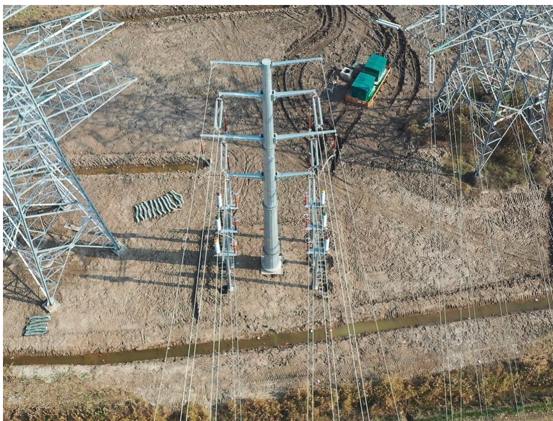
2021年12月15日 T26塔基施工区复耕
