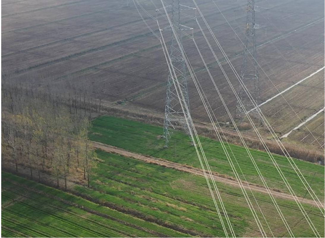
2021年12月15日 T50塔基施工区复耕
