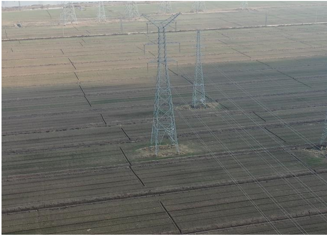
2021年12月15日 T55塔基施工区复耕
