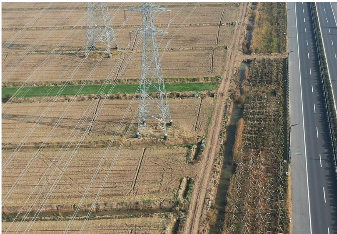
2021年12月15日 T31塔基施工区复耕
