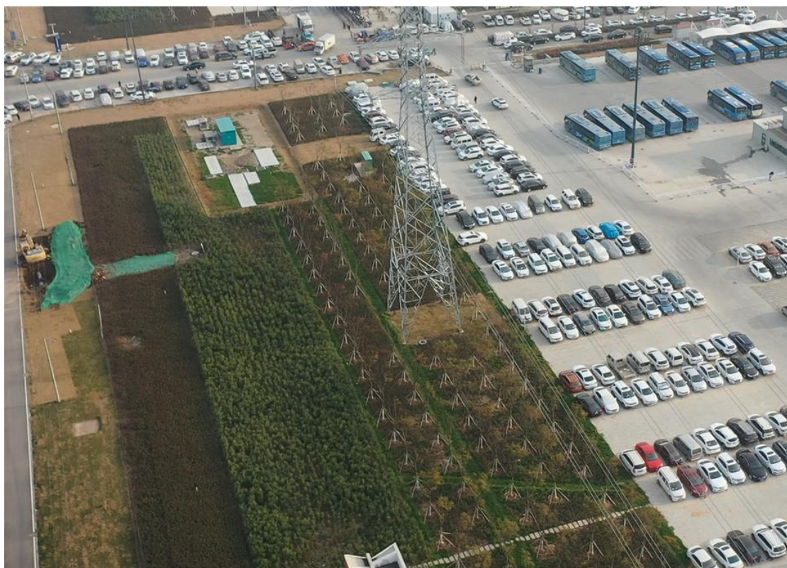
2021年12月15日 T12塔基施工区撒播草籽
