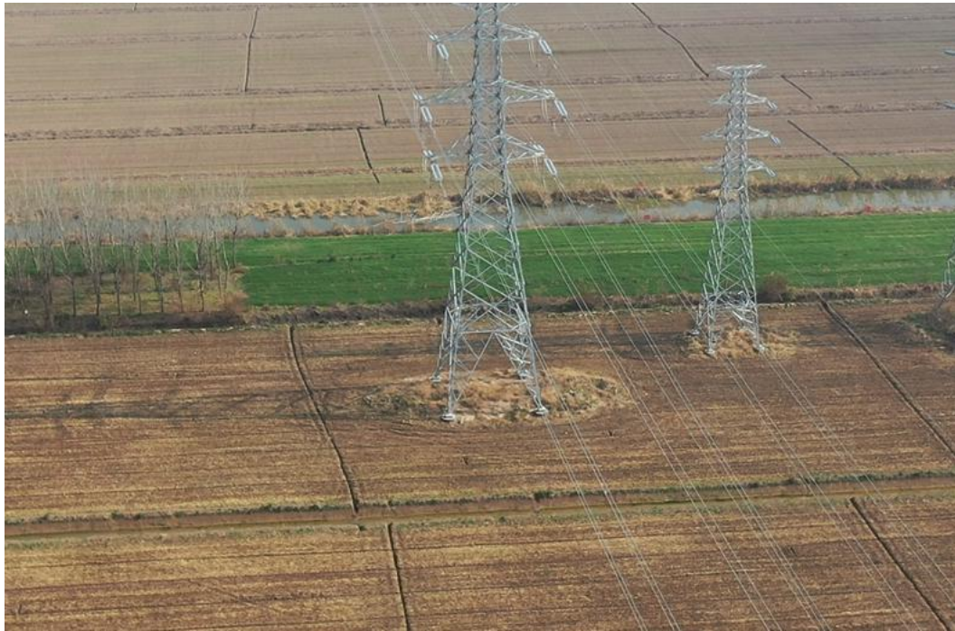
2021年12月15日 T52塔基施工区复耕
