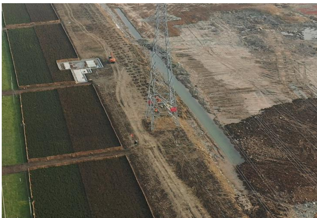
2021年12月15日 T9塔基施工区撒播草籽
