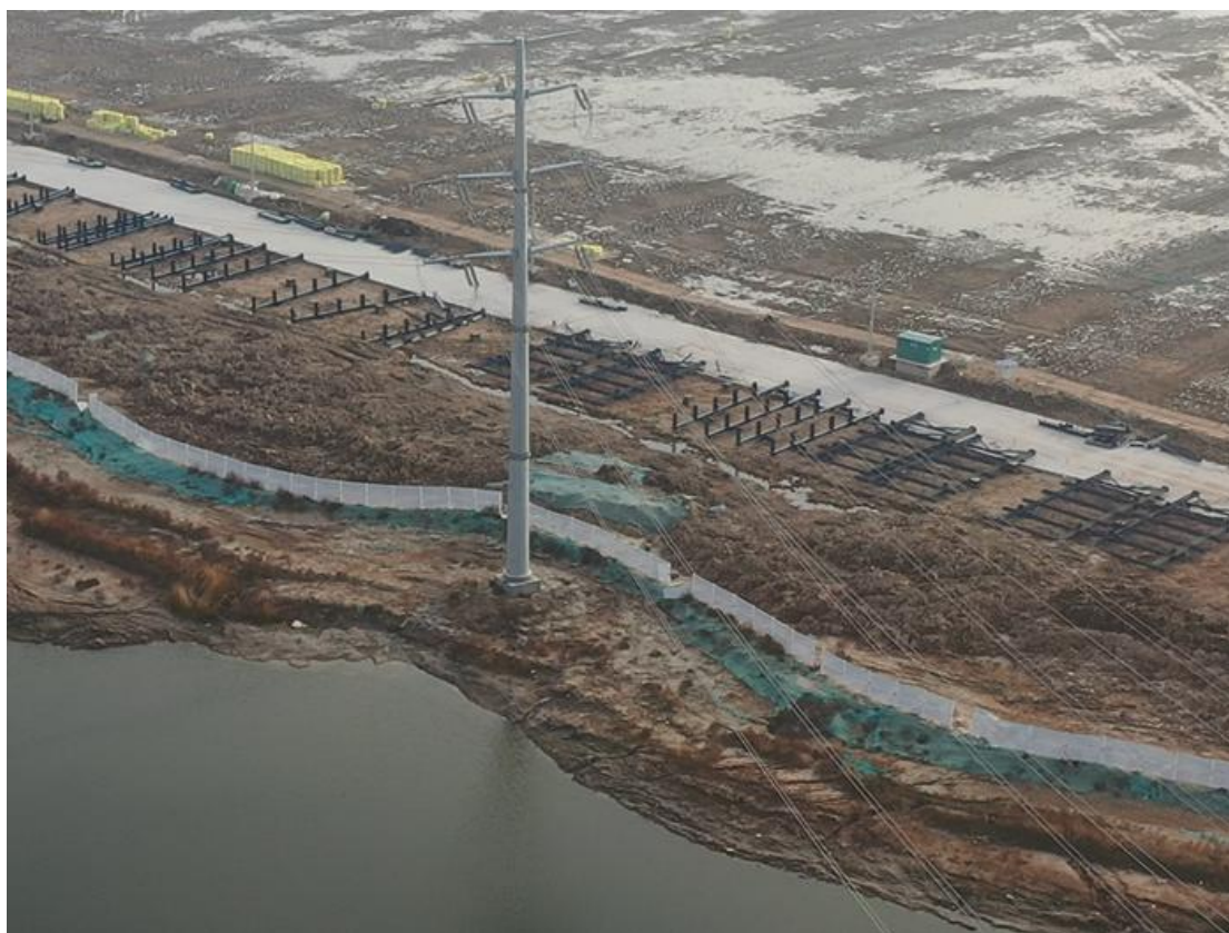
2021年12月15日 T19塔基施工区撒播草籽
