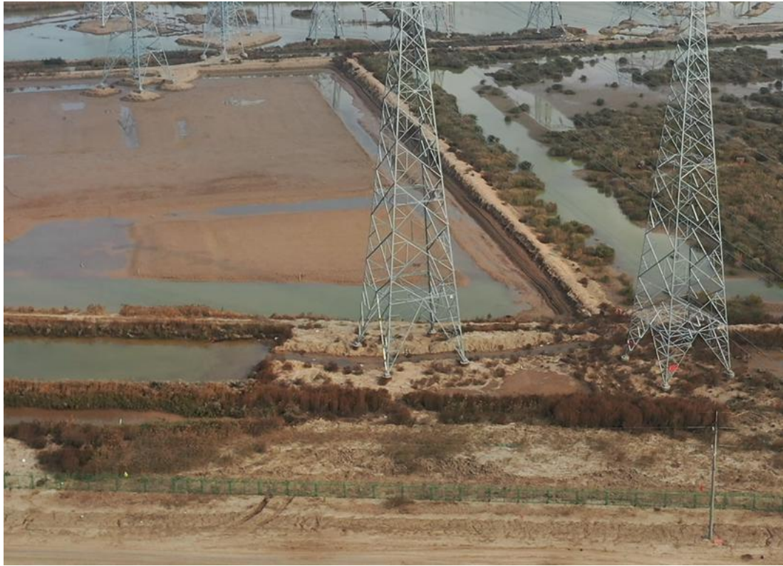
2021年12月15日 T57塔基施工区撒播草籽
