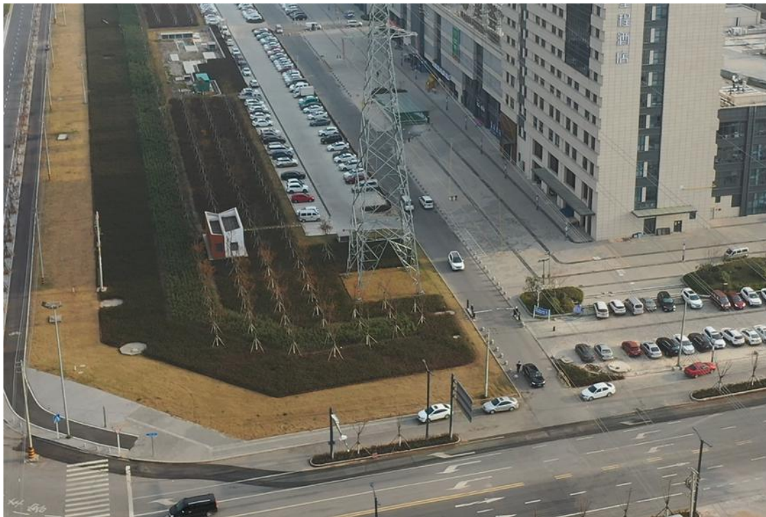
2021年12月15日 T7塔基施工区撒播草籽
