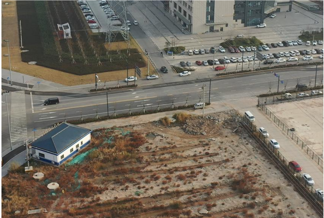
2021年12月15日 T71跨越场地施工区撒播草籽
