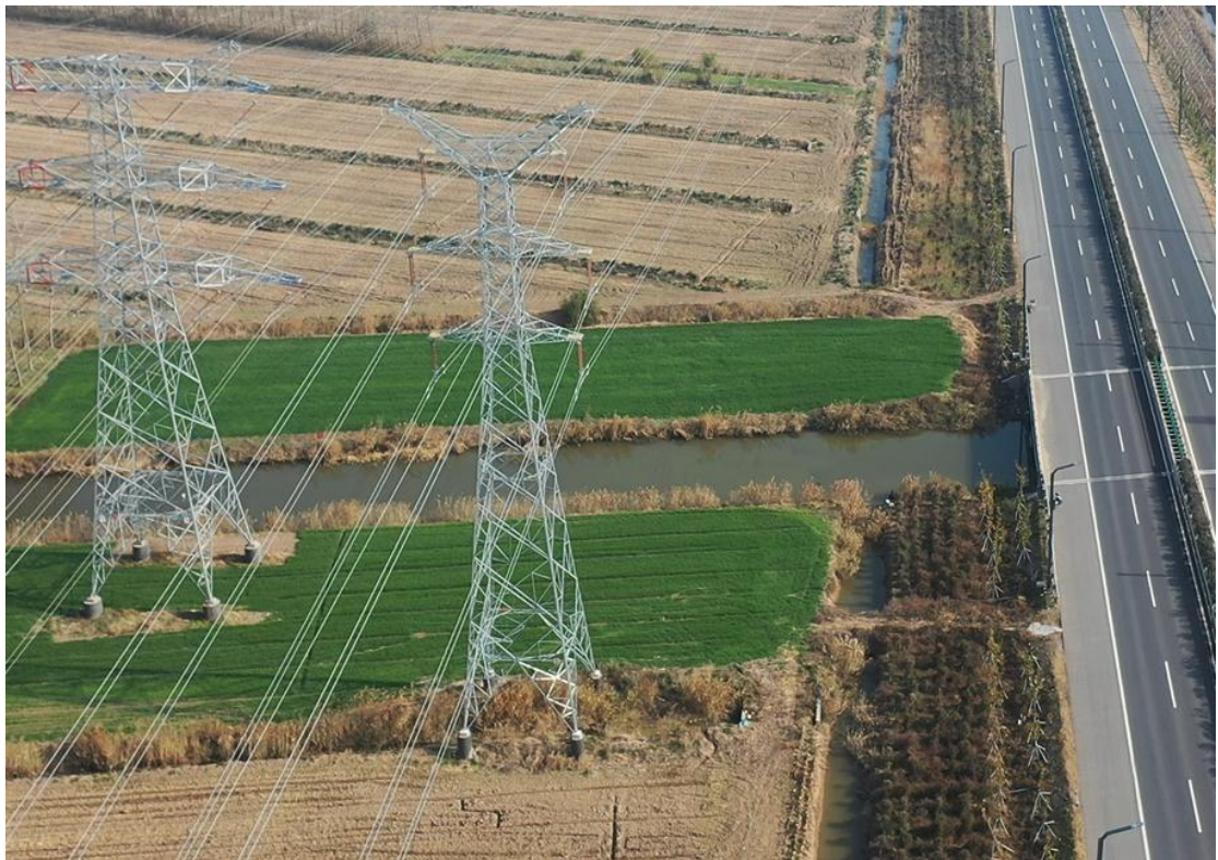
2021年12月15日 T71跨越场地施工区复耕
