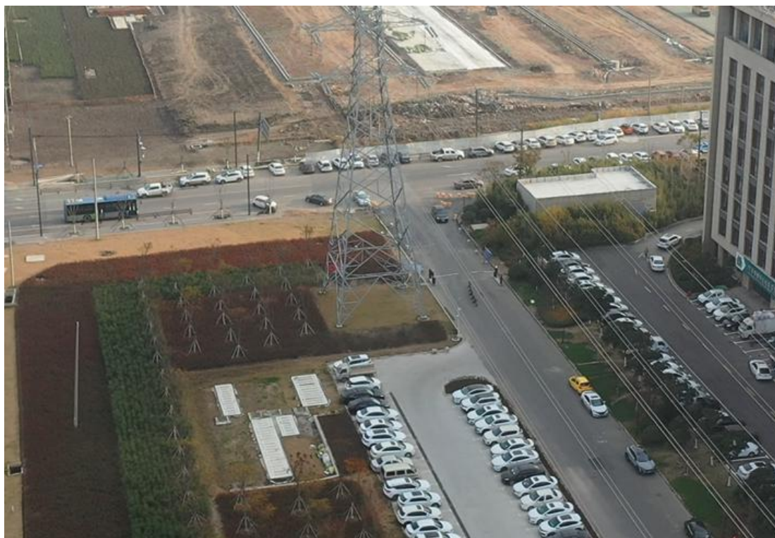
2021年12月15日 T8塔基施工区撒播草籽
