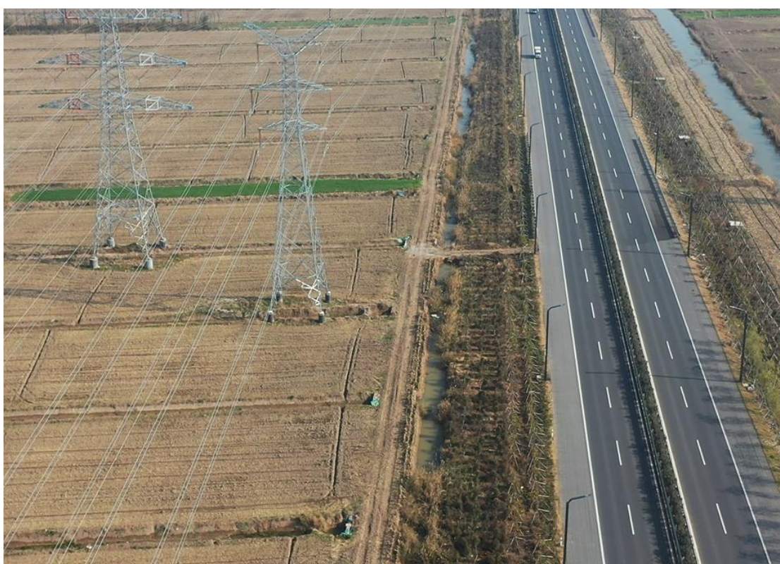
2021年12月15日 T32塔基施工区复耕
