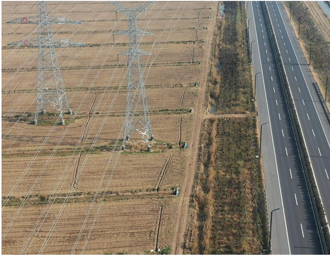
2021年12月15日 T33塔基施工区复耕
