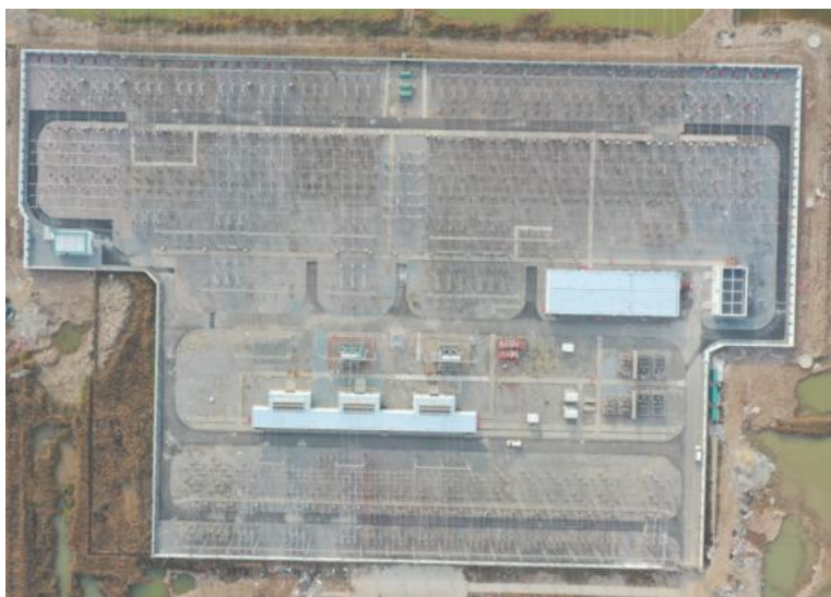
图 3-1 余方回填场地现状照片
