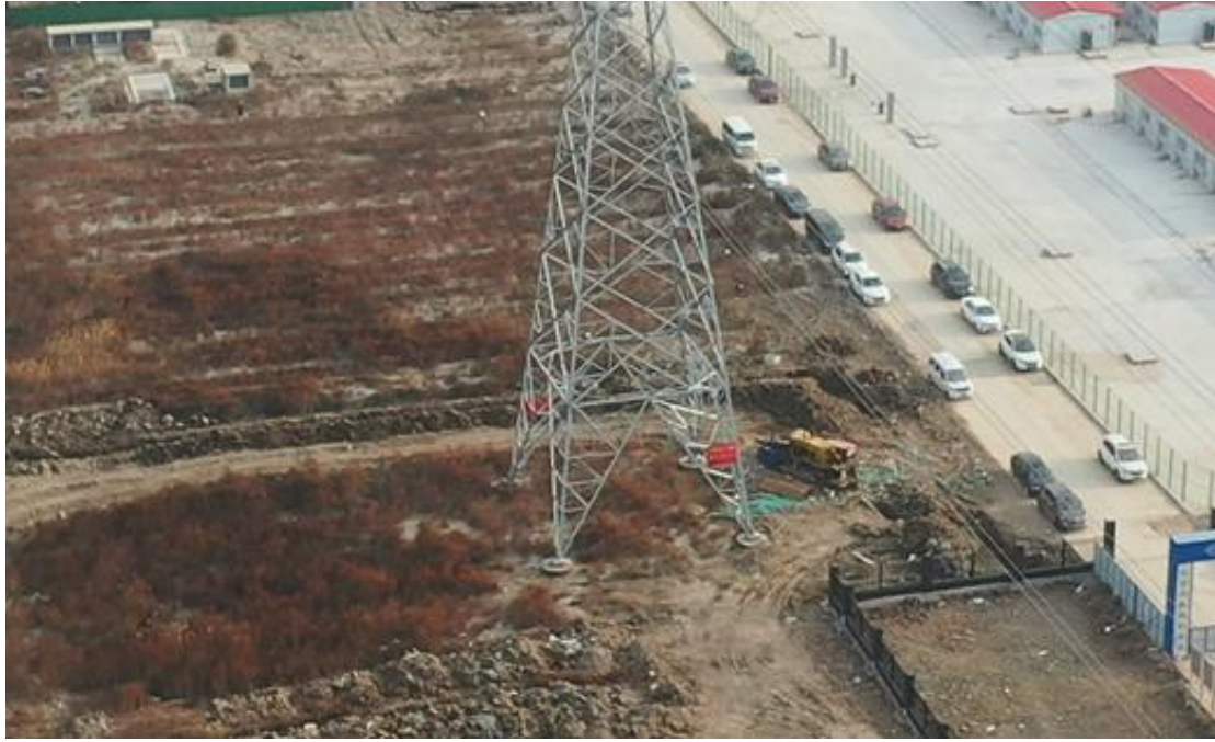
2021年12月15日 T6塔基施工区撒播草籽
