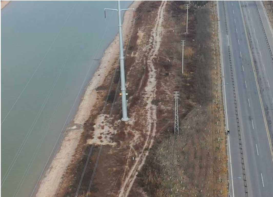
2021年12月15日 T63塔基施工区撒播草籽
