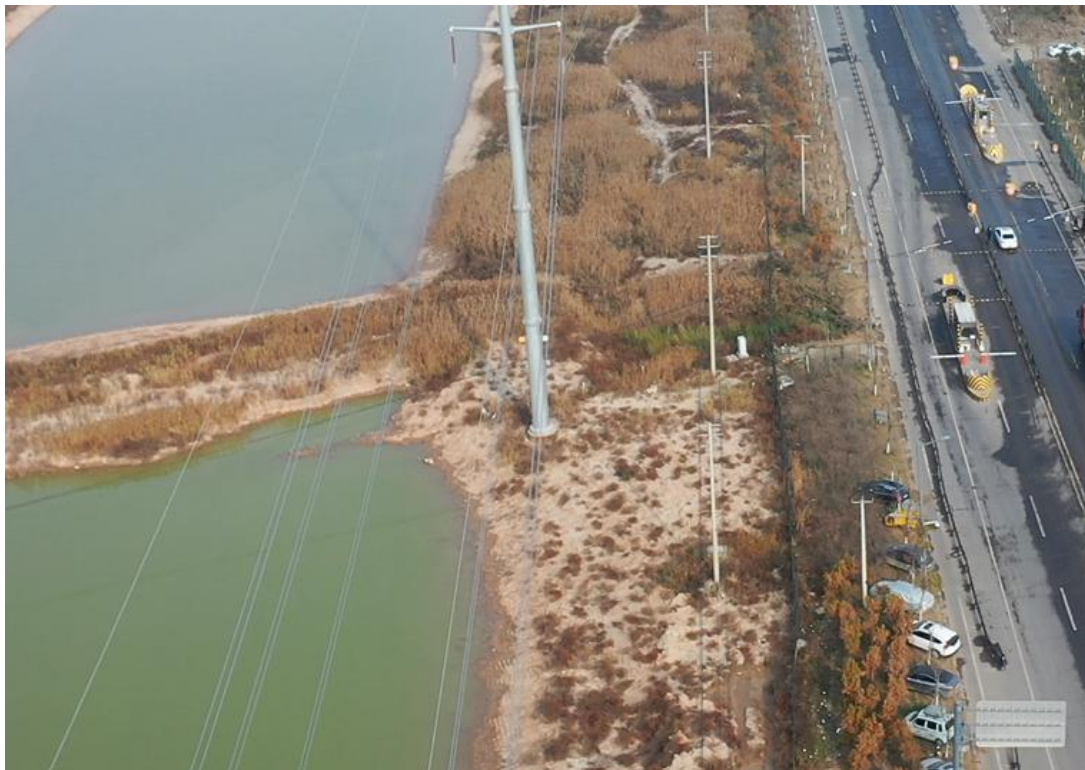
2021年12月15日 T62塔基施工区撒播草籽
