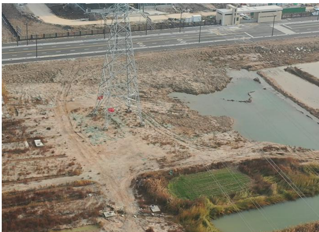
2021年12月15日 T5塔基施工区恢复盐田
