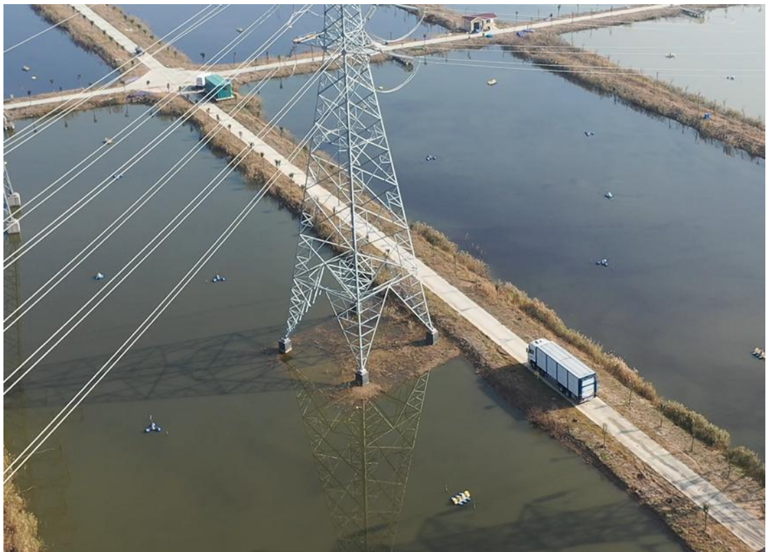
2021年12月15日 T44塔基施工区恢复鱼塘
