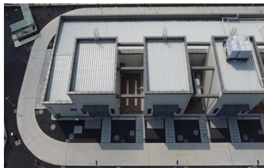
110kV 桂山变电站内碎石压盖 (摄于 2021 年 7 月 19 日)
