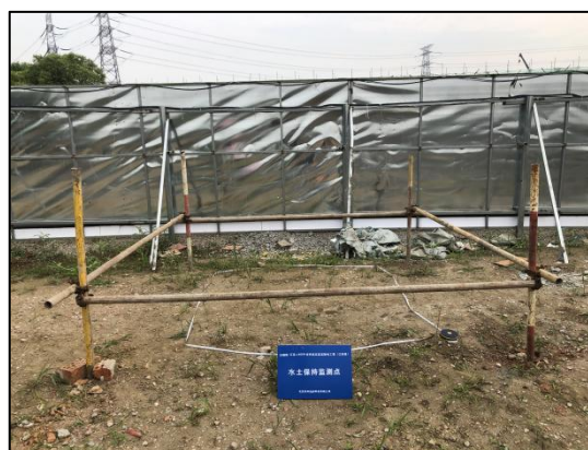
换流站进站道路区
