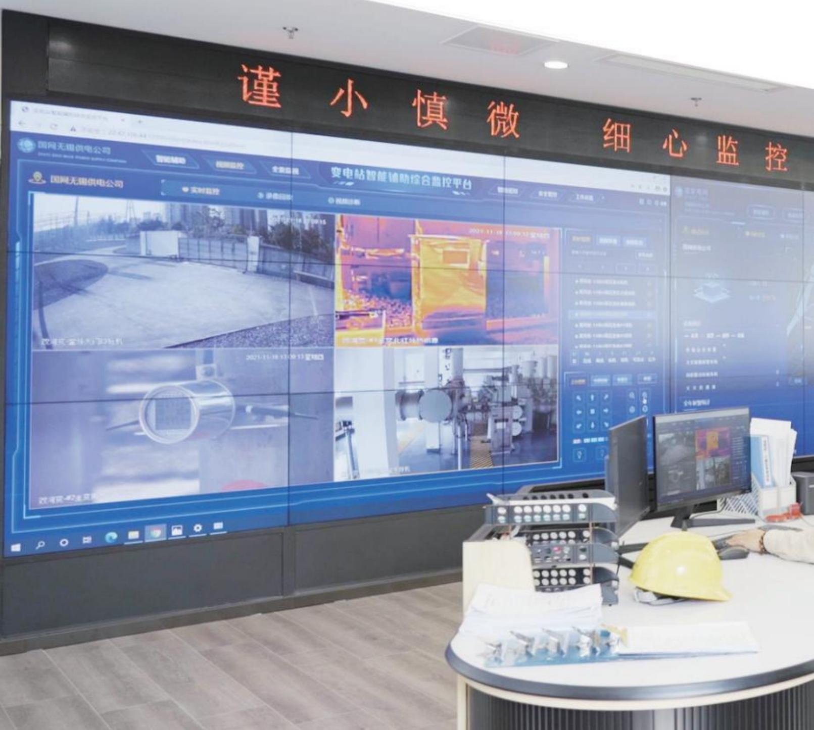
2021年9月29日，公司变电运维监控大厅进入“集中监控+无人值守”实体化运行，国网江阴市供电公司变电运维监控中心成为国网江苏省电力有限公司首个实现变电运维监控一体化运作的运维单位，同时也是国网江苏省电力有限公司首个实体化运作的主辅消一体化监控中心。该中心一体化设备监控平台集合了视频监控、在线监测、D5000、机器人等技术，兼具了消防监控等功能，通过图像识别、智能识别提升设备主动预警能力，并能通过大数据计算分析，判断设备健康运行趋势。
