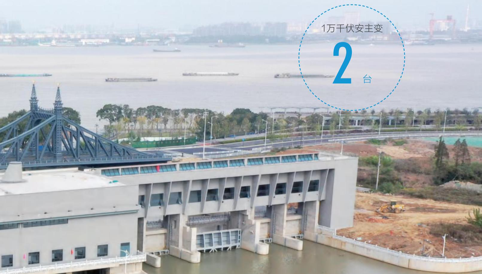
定波水利枢纽工程自 2019 年下半年开始建设，是省级重点水利工程项目——锡澄运河（黄昌河 - 长江段）整治工程的重要组成部分，位于锡澄运河与长江交汇口处，主要包括新建 48 米节制闸、120 立方米 / 秒双向泵站以及上下游引河等，建成后能进一步提高江阴地区区域洪水北排能力、改善水环境质量、优化水资源配置，促进区域经济社会发展。
