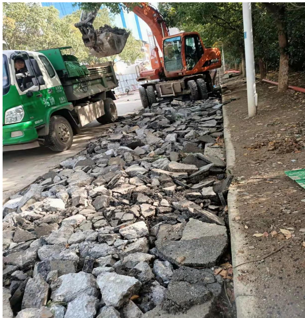
2021 年 10 月 恒发路监测点位 1 电缆沟开挖
