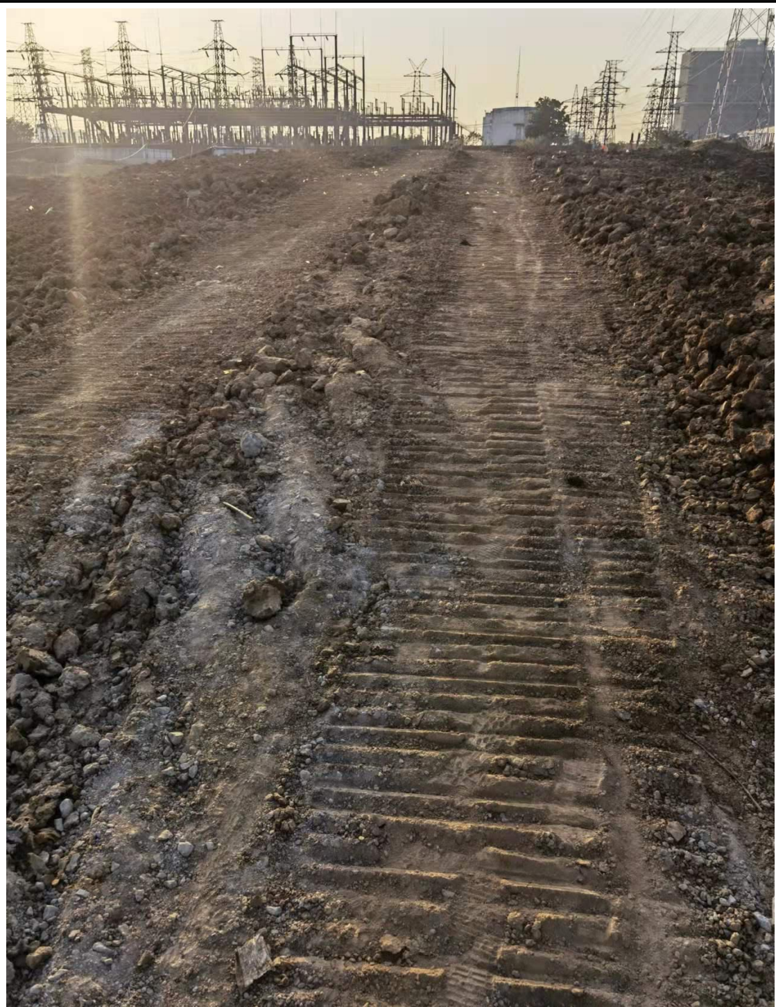
2021 年 10 月 尧新变附近 施工道路
