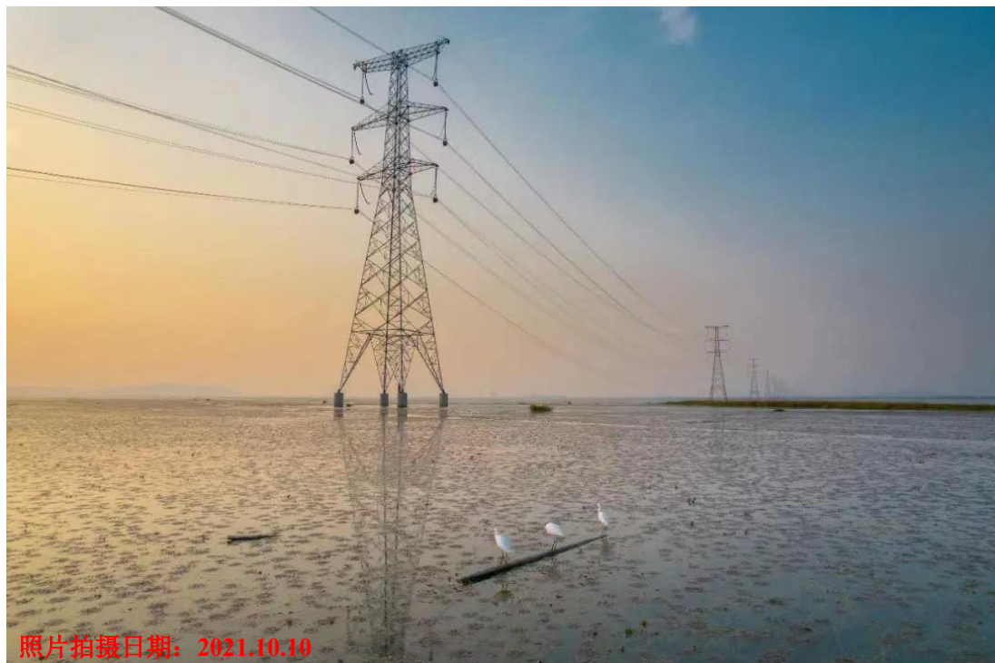
500kV 笠木 5K83/笠渚 5K84 线#63~#76 塔间穿越太湖重要湿地（吴江区、吴中区）施工期生态恢复照片
