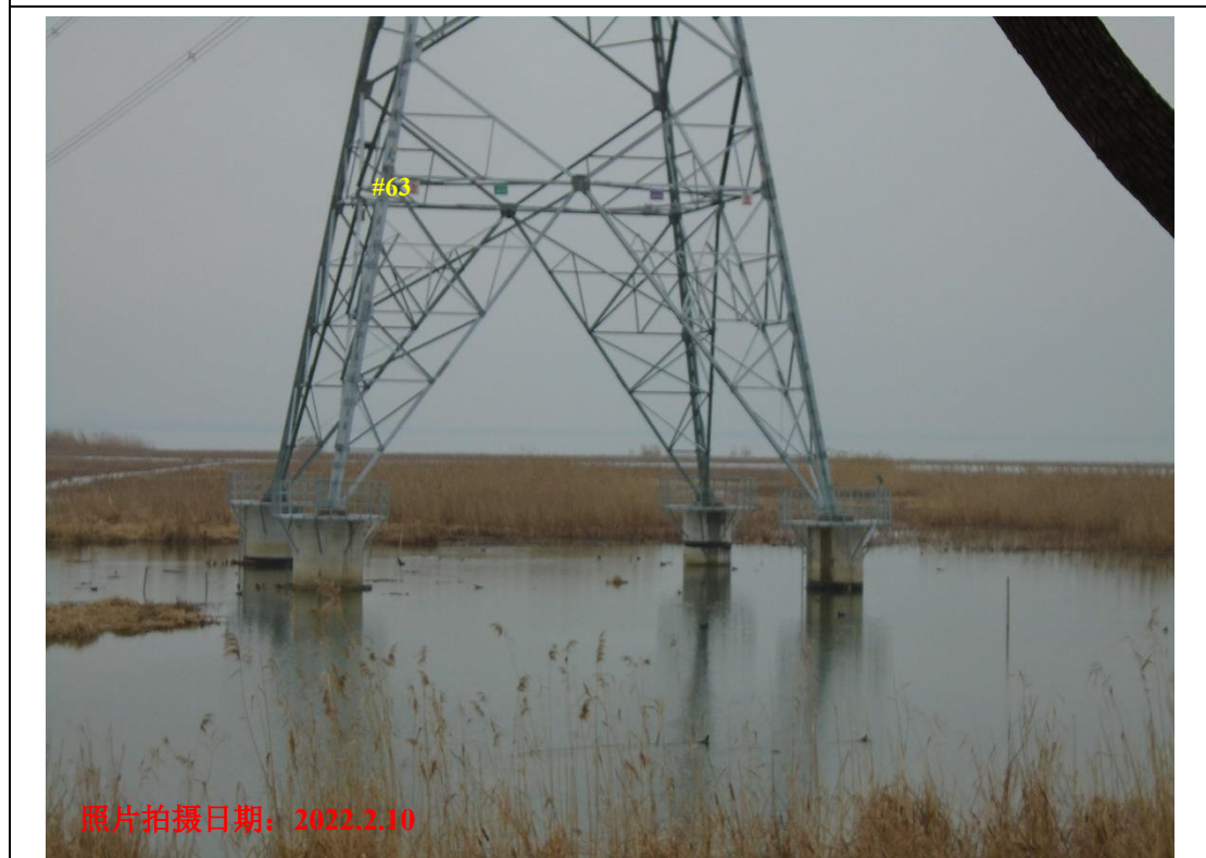
500kV 笠木 5K83/笠渚 5K84 线#63 塔基周围生态恢复照片
