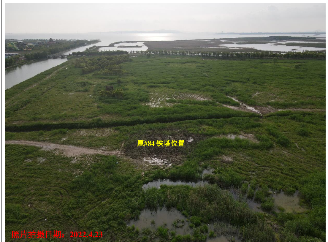
拆除 500kV 苏木 5229/苏淞 5230 线#61~#85 塔间穿越太湖（吴江区、吴中区） 重要保护区、太湖重要湿地（吴江区、吴中区）生态恢复照片
