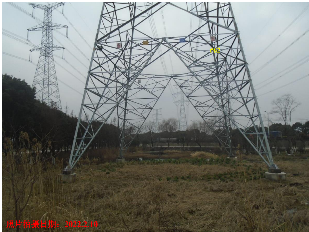
500kV 苏笠 5K85/苏泽 5K86 线#62 塔基周围生态恢复照片
