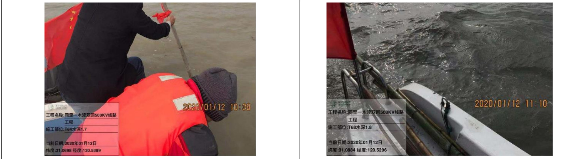
线路施工人员测量各塔位水深及 GPS 定位中心桩现场勘察照片
