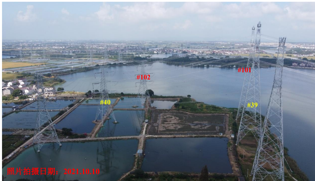
500kV 笠木 5K83/笠渚 5K84 线#99~#109 塔间、500kV 苏笠 5K85/苏泽 5K86 线#37~#47 塔间穿越长漾湖国家级水产种质资源保护区（东实验区）施工期照片
