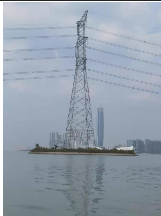
拆除 500kV 苏木 5229/苏渎 5230 线原有 #72 塔基周围生态环境照片
