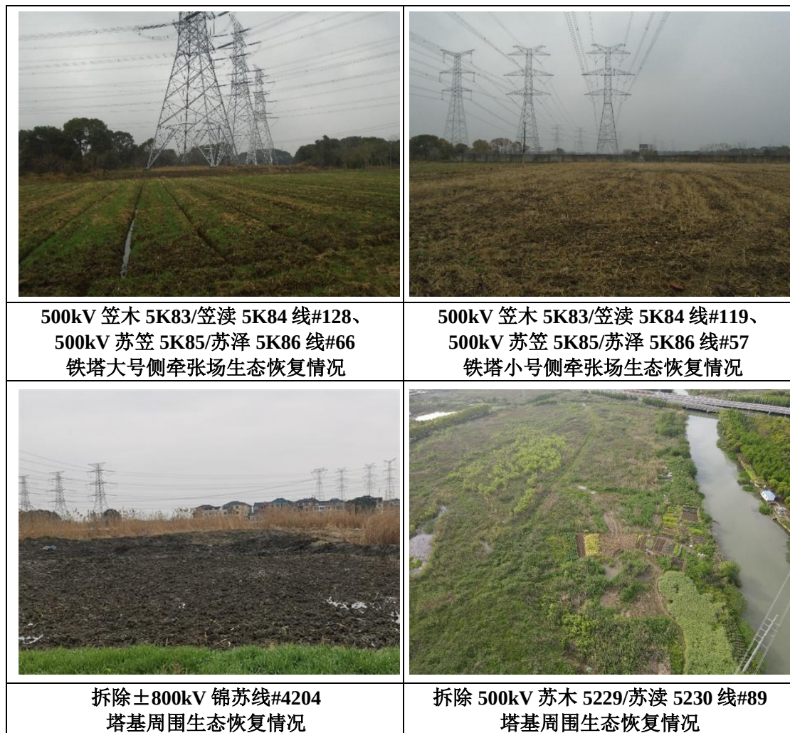
图 10-1 本项目施工迹地恢复示例
