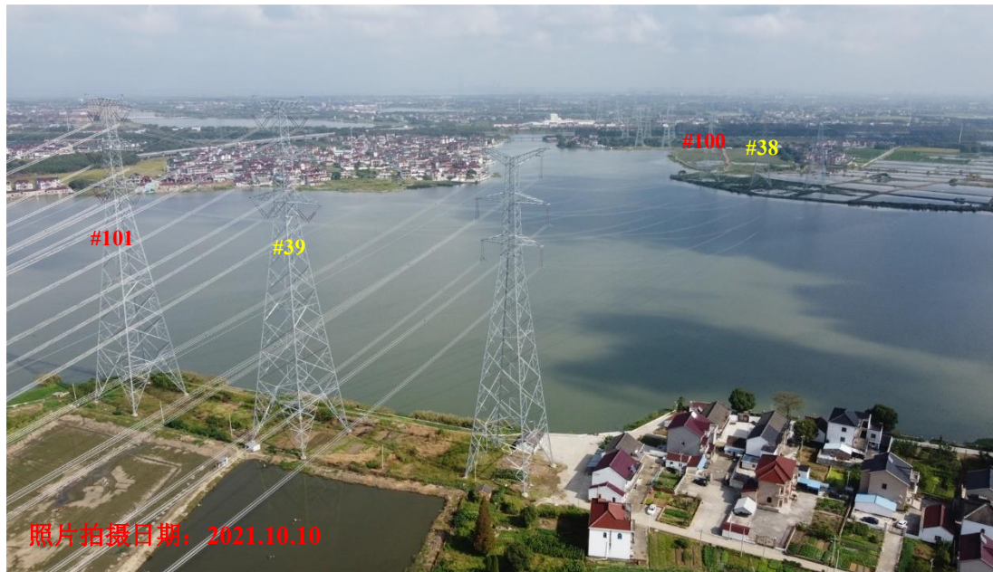
500kV 笠木 5K83/笠渚 5K84 线#99~#103 塔间、500kV 苏笠 5K85/苏泽 5K86 线#37~#41 塔间跨越雪落漾重要湿地施工期照片
