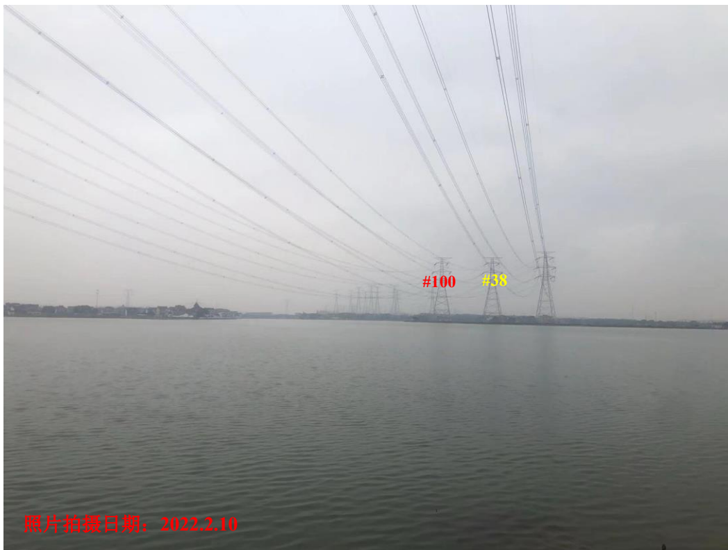
500kV 笠木 5K83/笠渚 5K84 线#99~#103 塔间、500kV 苏笠 5K85/苏泽 5K86 线#37~#41 塔间跨越雪落漾重要湿地照片
