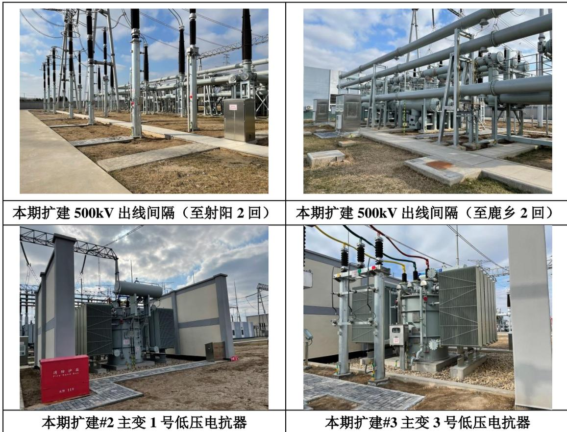
图 3-7 丰汇 500kV 变电站本期扩建工程设备照片
