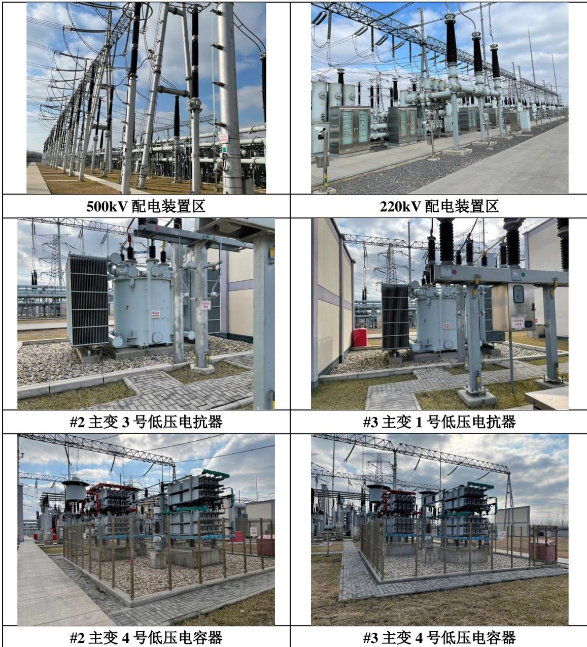
图 3-5 丰汇 500kV 变电站现有设施设备照片
