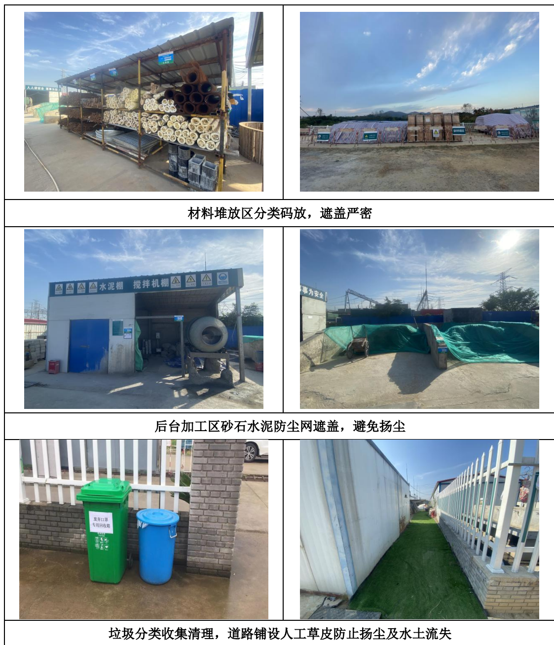
图 5-2 施工期环保措施落实情况照片
