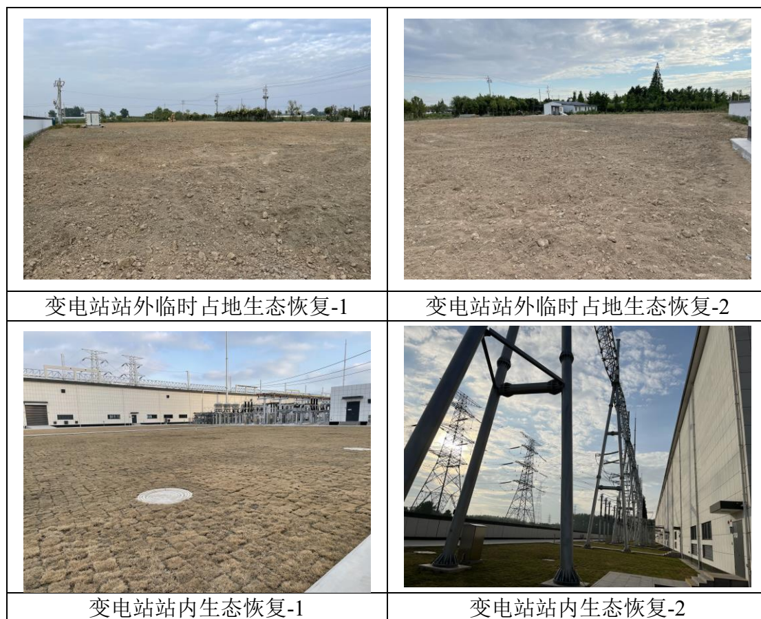
图 10-1 本项目变电站生态恢复情况
