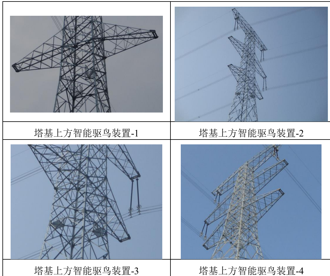
图 6-3 本项目新建智能驱鸟装置
