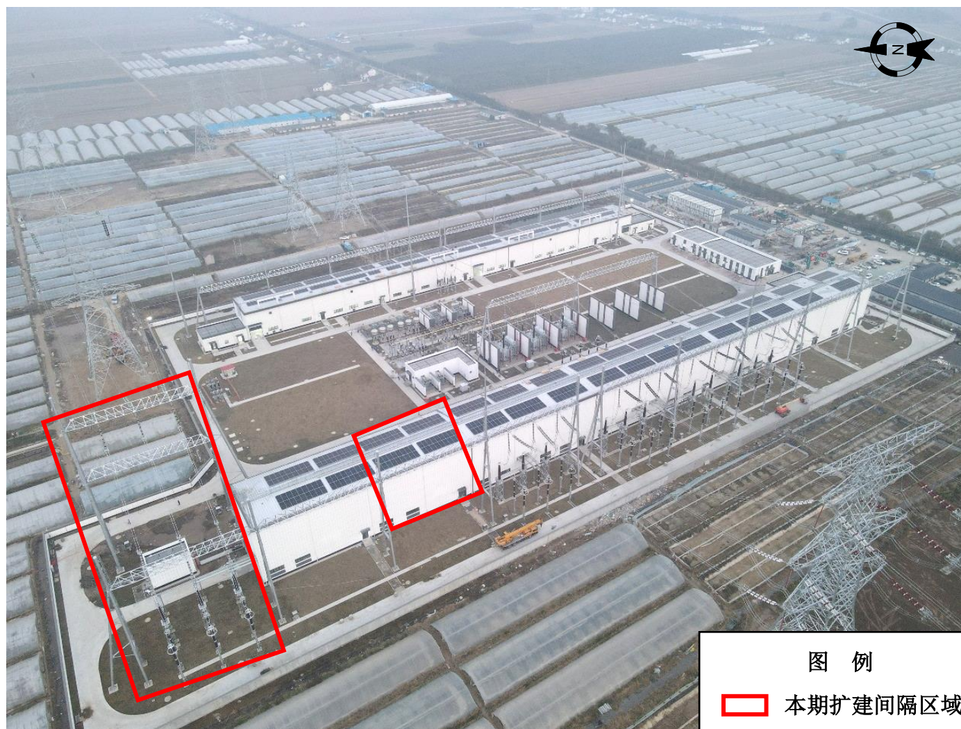
图 3-2 鹿乡 500kV 变电站鸟瞰图-1
