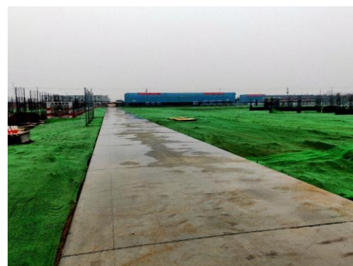
站区内部道路及时清扫并洒水抑尘，裸露表土采用密目网覆盖
