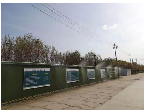
变电站设置施工围挡，并设置喷淋装置，用以控制扬尘
