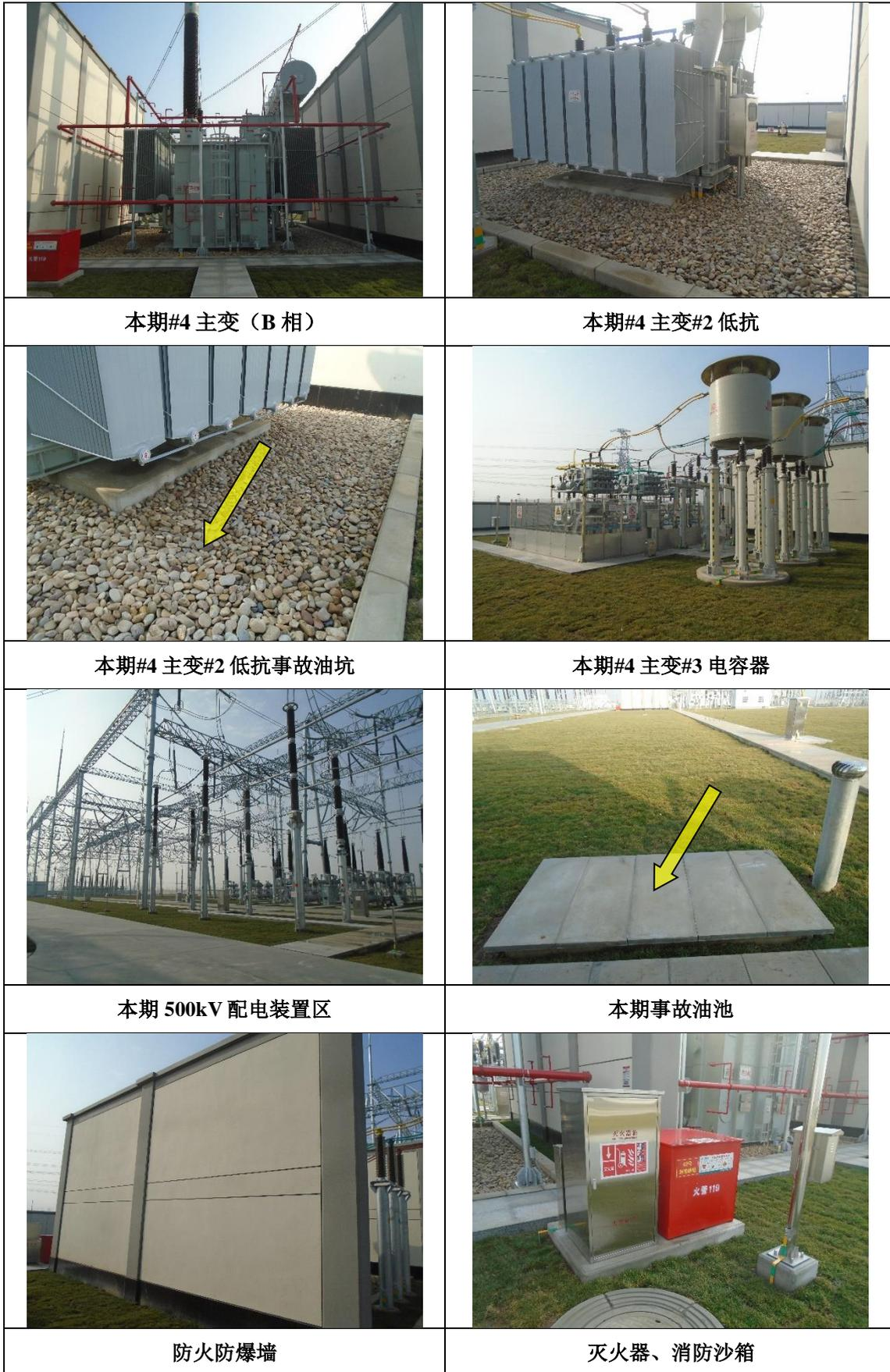
图 3-3 黄集 500kV 变电站本期规模设施及环保设施照片
