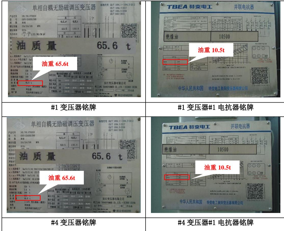
图 3-2 黄集 500kV 变电站主变压器及电抗器铭牌照片
