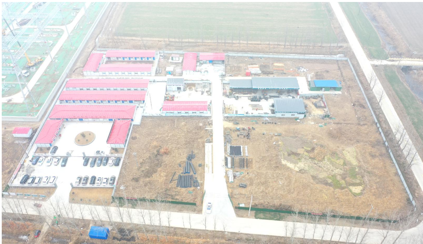
2021.01 施工生产区和临时堆土区
