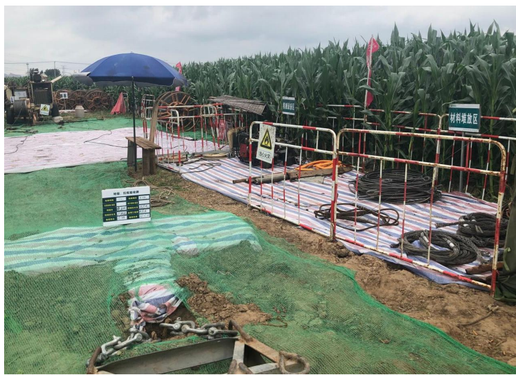
牵张及跨越场地区防尘网苫盖（2021 年 8 月）
