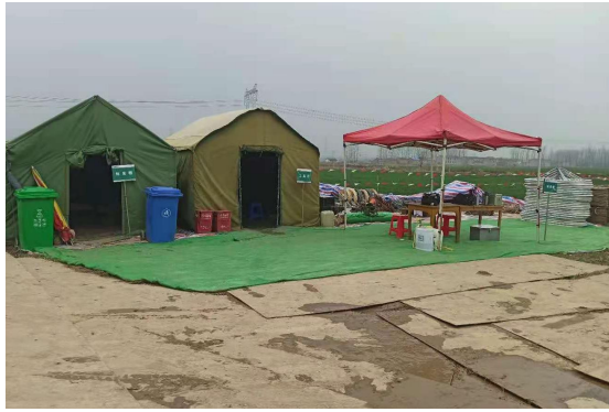
(11) 施工及人抬道路区钢板铺垫
