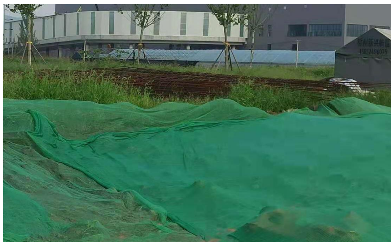
塔基及塔基施工场地区防尘网苫盖（2021 年 8 月）
