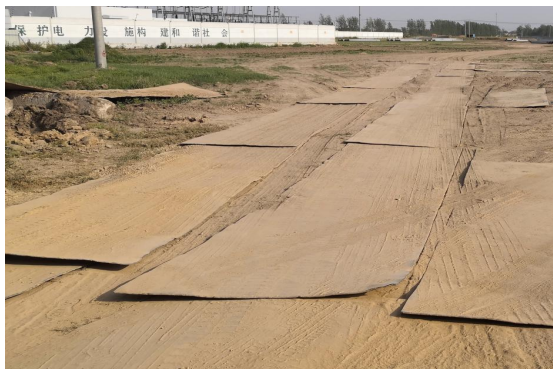
（1）升压扩建区钢板铺垫
