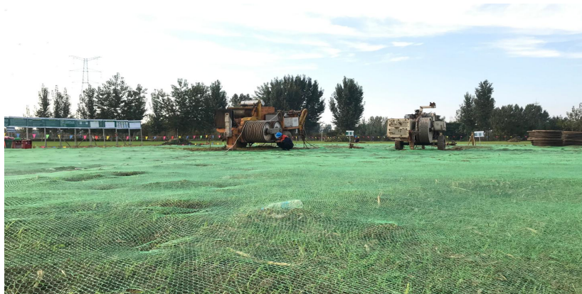
牵张及跨越场地区防尘网苫盖（2021 年 8 月）
