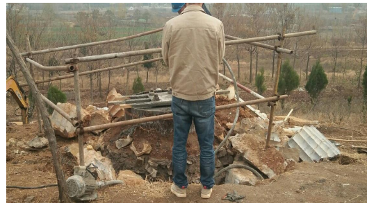
(4) 塔基及塔基施工场地区防冲护坡措施 拍摄时间：2021年11月
