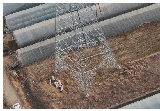
(4) 塔基及塔基施工场地区撒播草籽
