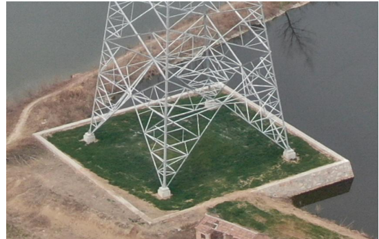
(2) 塔基及塔基施工场地区撒播草籽
