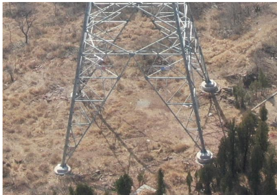
(3) 塔基及塔基施工场地区撒播草籽
