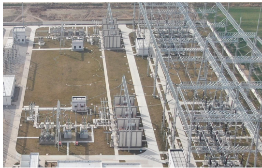
(1) 升压扩建区高羊茅草皮
