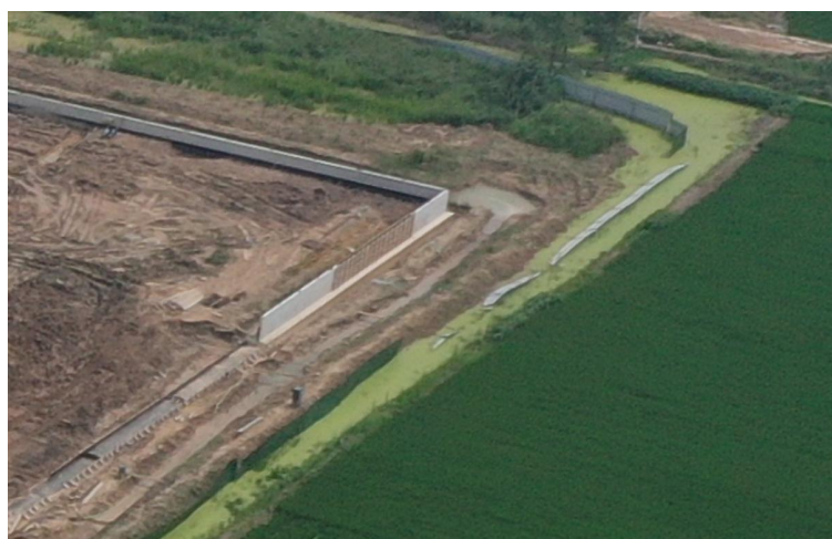
升压扩建区临时排水沟（2020 年 8 月）
