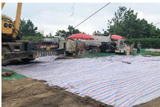
(9) 牵张及跨越场地区彩条布苫盖
