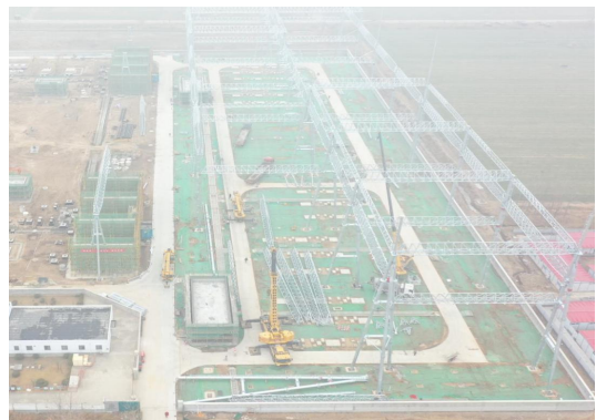
（2）升压扩建区防尘网苫盖
