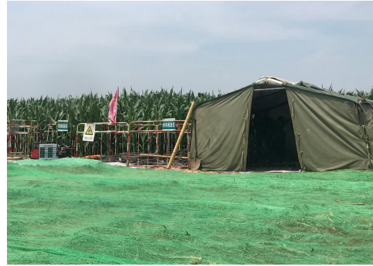
(12) 塔基及塔基施工场地区防尘网苫盖
