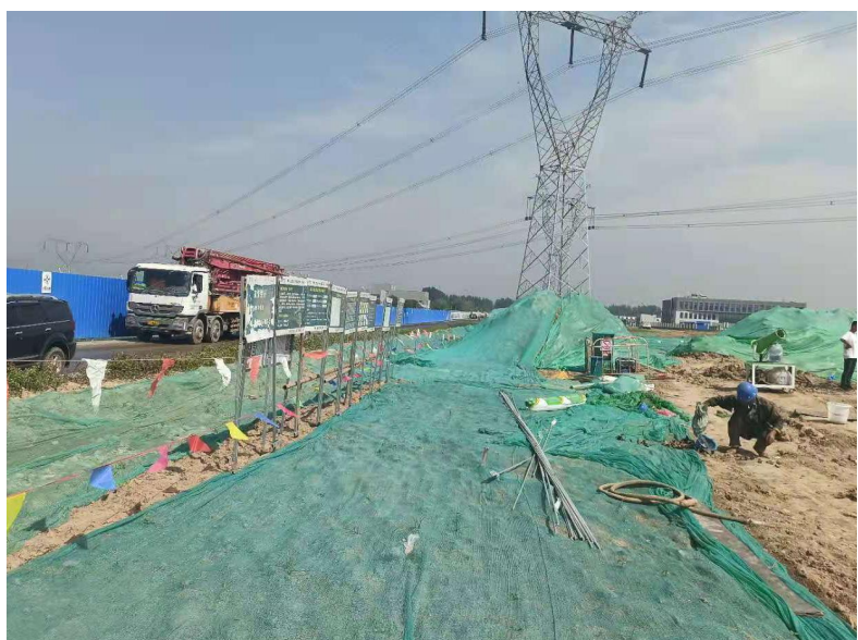
牵张及跨越场地区防尘网苫盖（2021 年 8 月）
