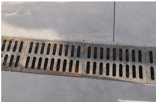
（3）施工生产区临时排水沟
