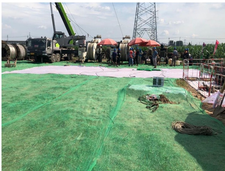
牵张及跨越场地区防尘网苫盖（2021 年 8 月）
