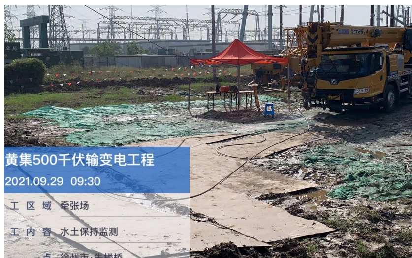
牵张及跨越场地区防尘网苫盖（2021 年 9 月）
