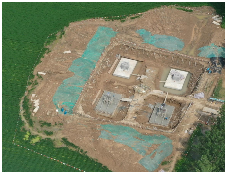
(1) 塔基及塔基施工场地区表土剥离 拍摄时间：2020年8月
