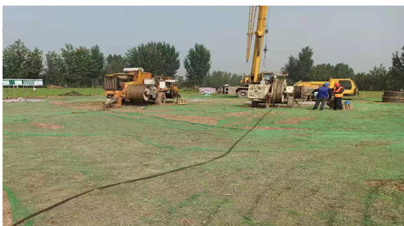
牵张及跨越场地区防尘网苫盖（2021 年 8 月）
