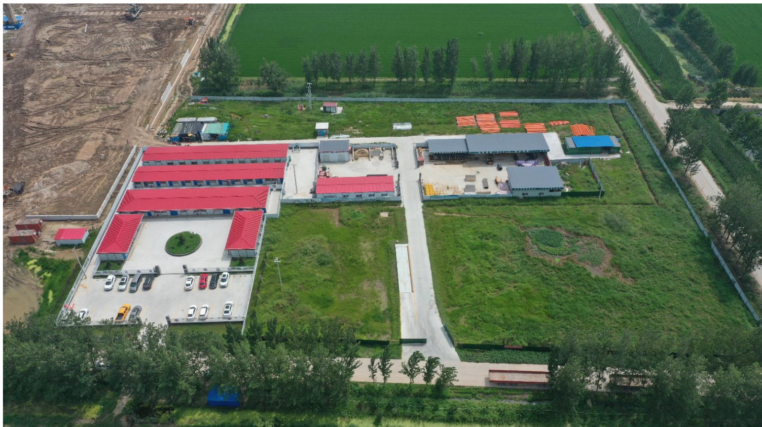
2020.08 施工生产区和临时堆土区
