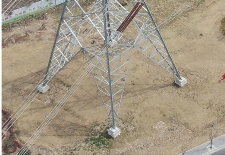
塔基及塔基施工区撒播草籽（2022 年 3 月）
