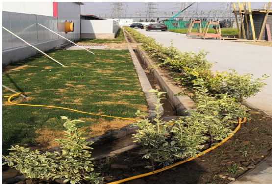
(5) 施工生产区临时排水沟
