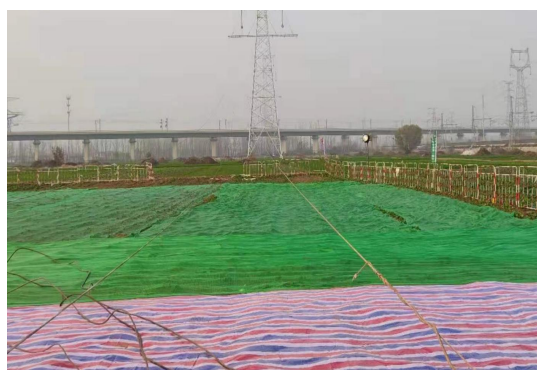
(10) 牵张及跨越场地区防尘网苫盖
