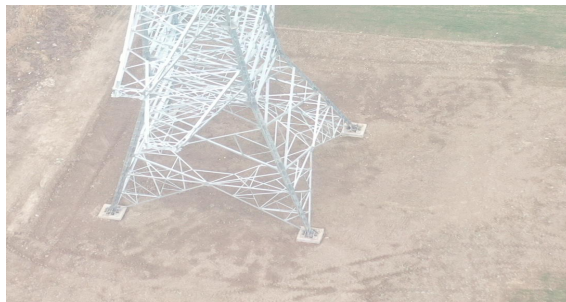
(3) 塔基及塔基施工场地区土地整治 拍摄时间：2021年11月
