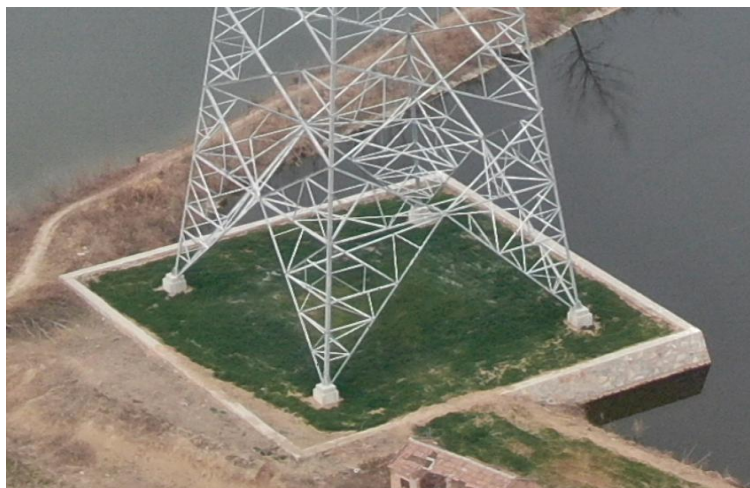
塔基及塔基施工区撒播草籽（2022 年 3 月）
