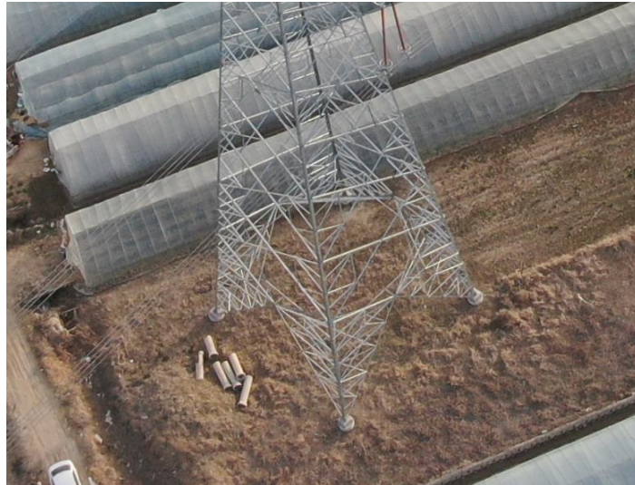
塔基及塔基施工区撒播草籽（2022 年 3 月）
