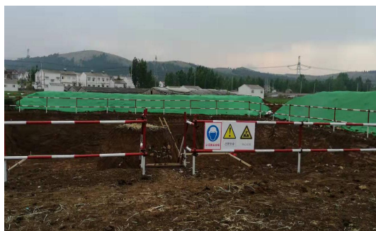
(7) 塔基及塔基施工场地区防尘网苫盖
