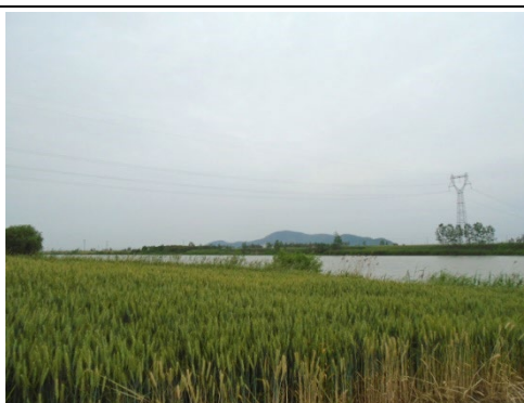
220kV 芦瀛 4913 线#12~#13 一档跨越古泊善后河照片
