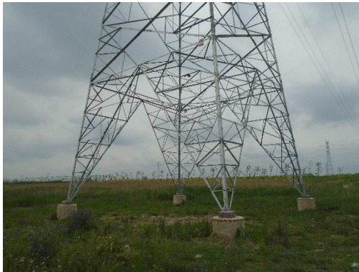
220kV 沿徐 49P1 线#32 塔基周围生态恢复示例
