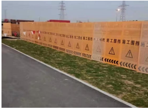
图 8-1 本工程施工期设置围挡照片
