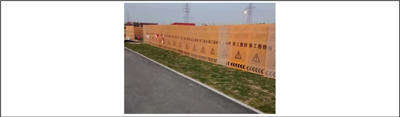
图 6-1 本工程施工期设置围挡照片
