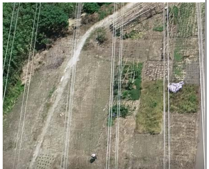
施工临时道路区 撒播狗牙根草籽
