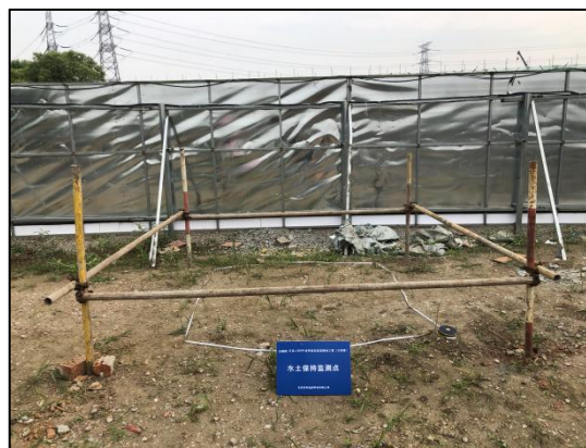
换流站进站道路区
