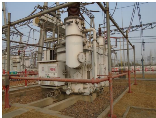
#1 主变 (现已拆除)
