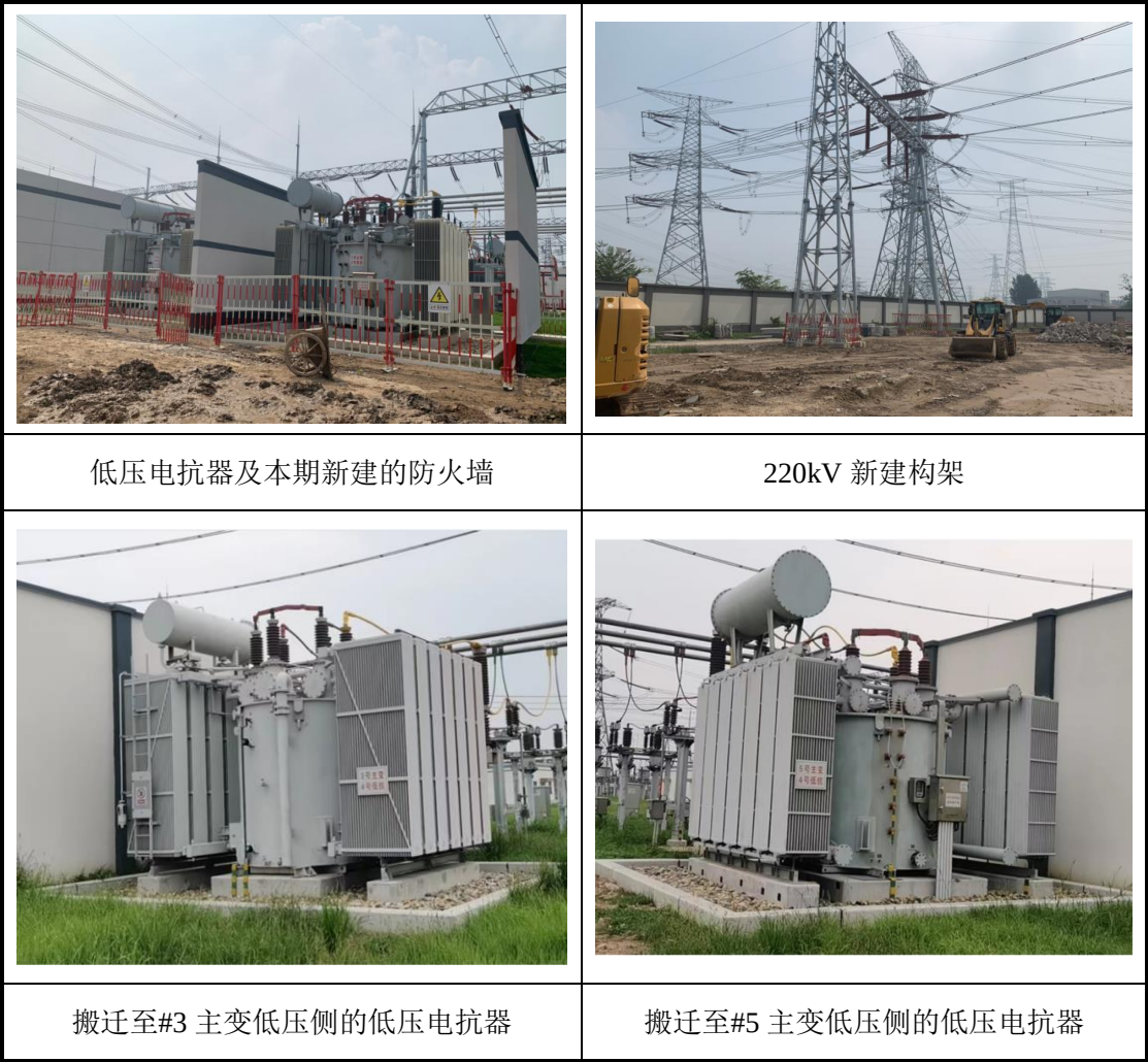
图 3.3-3 任庄 500kV 变电站本期新建设施
