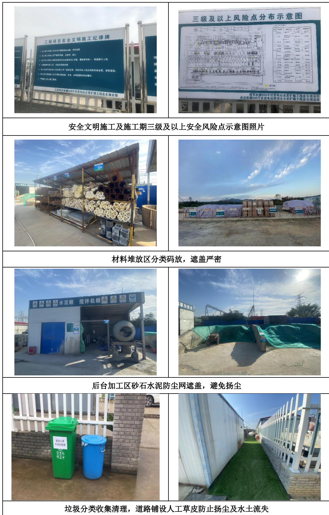
图 5-2 施工期环保措施落实情况照片
