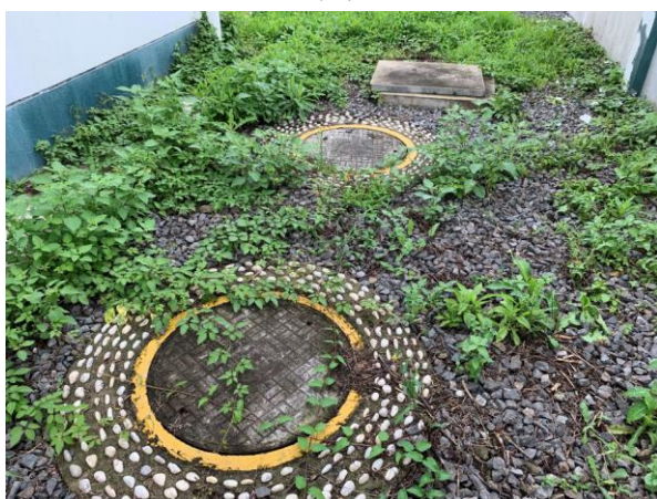
220kV 主控楼处化粪池
