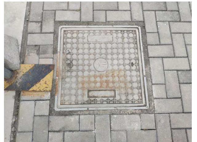
500kV 主控楼处化粪池
