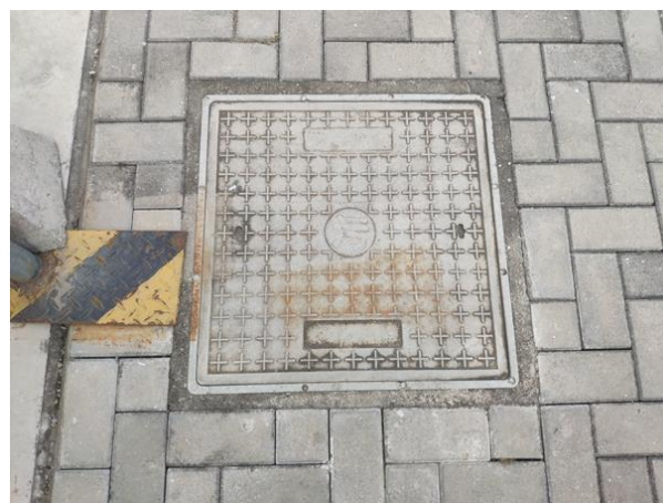
500kV 主控楼处化粪池
