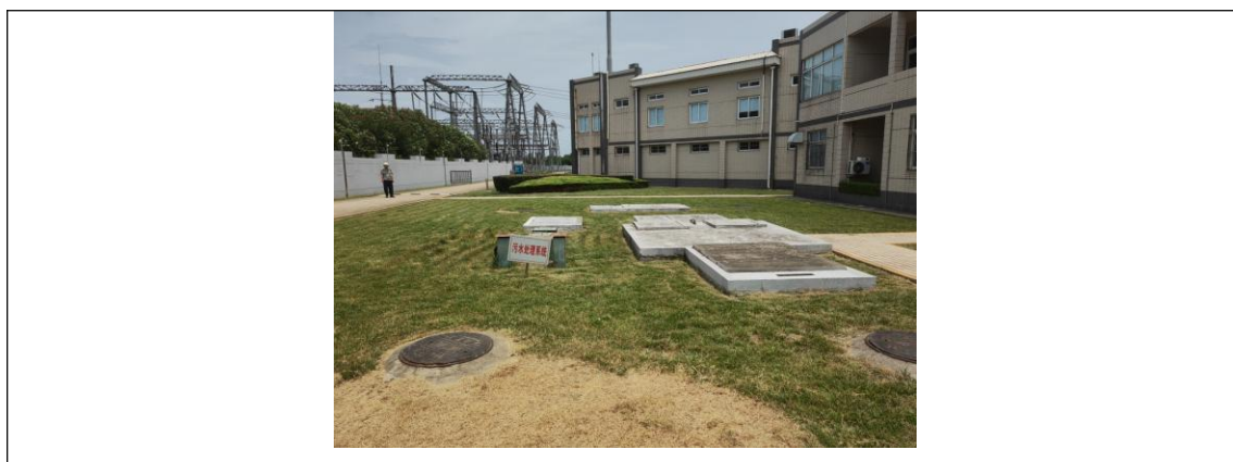
图3.9 老车坊500kV变电站原有污水处理设施情况
