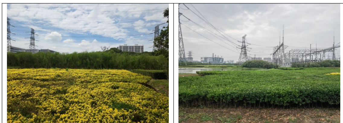
图3.4 车坊500kV变电站超规模扩建场地情况
