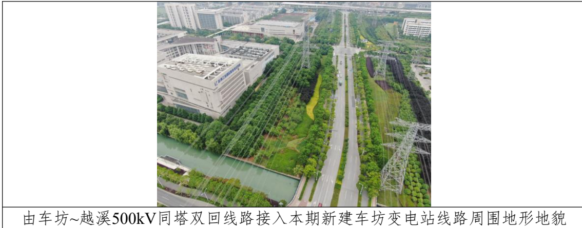
图4.2 本期新建车坊500kV变电站、500kV线路沿线经过地区地形地貌
