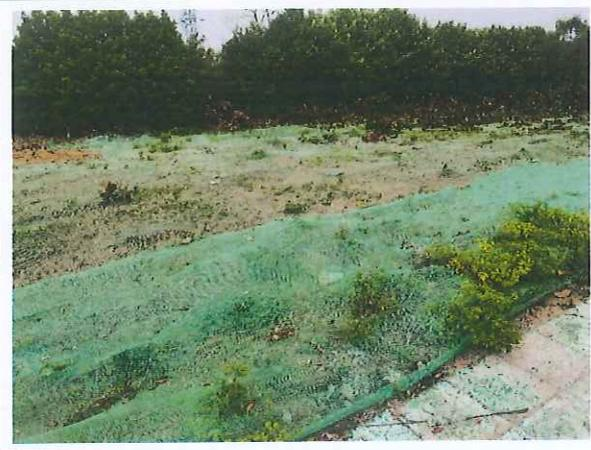
塔基及场地施工区现场裸露区域已采取密目网苫盖措施。
