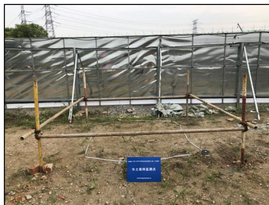
换流站进站道路区
