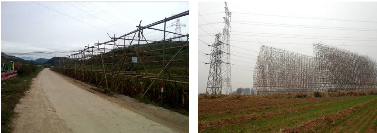
图 1.1-3 线路工程临时跨越形式照片
