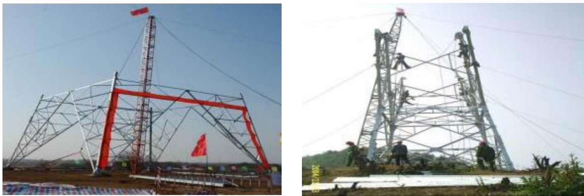
图 1.1-4 类似线路工程铁塔组装现场照片
