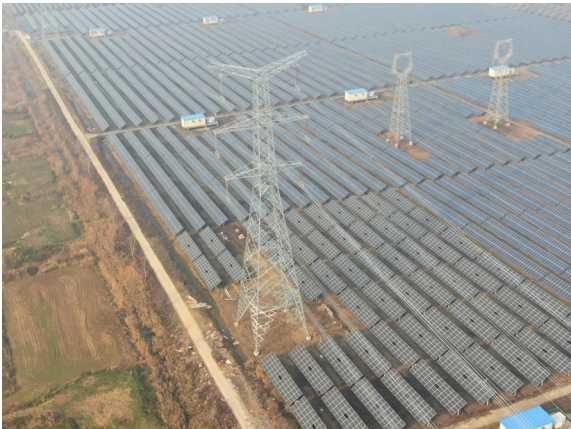
塔基及塔基施工区扰动面积图 (T4)3 月
