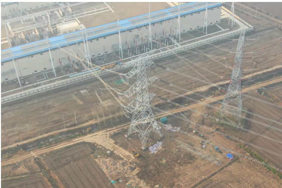
塔基及塔基施工区扰动面积图(T19)3月
