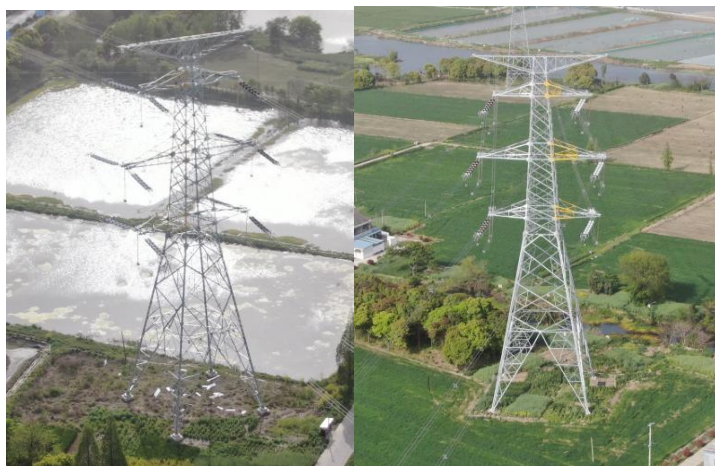
塔基及塔基施工区图-4月
