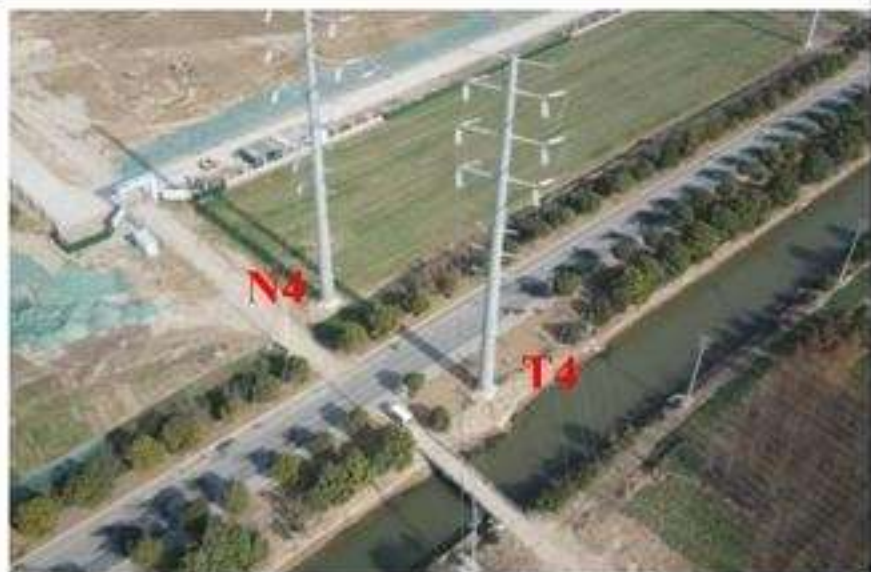
塔基 N4 复耕、T4 植被恢复 (2023.1.11)
