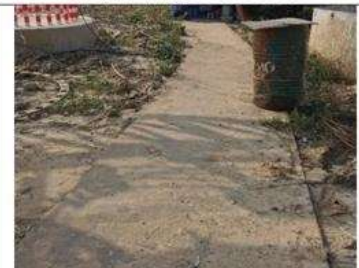
施工临时道路区铺设钢板 (2021.12.6)
