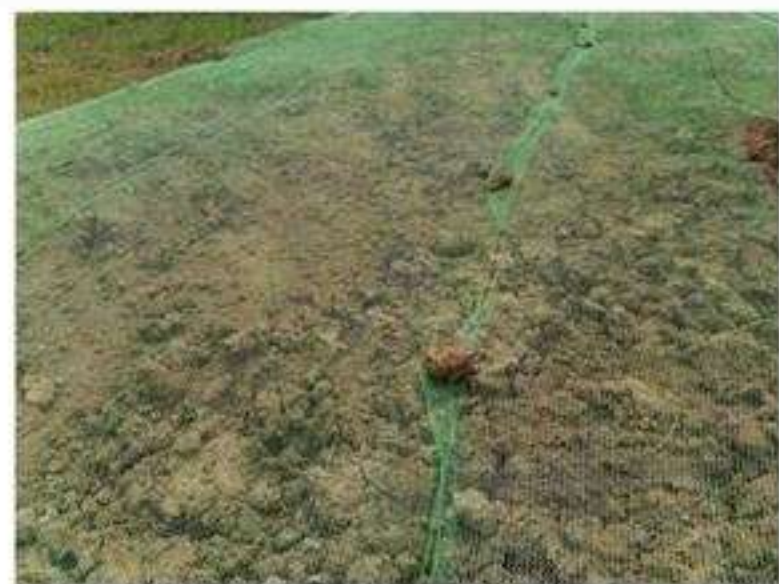
塔基及塔基施工区编织布覆盖 (2022.6.6)
