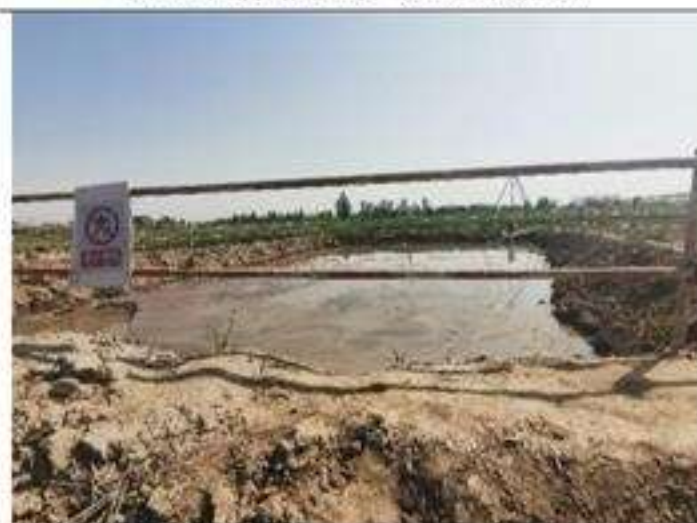
塔基及塔基施工区泥浆池 (2022.3.16)
