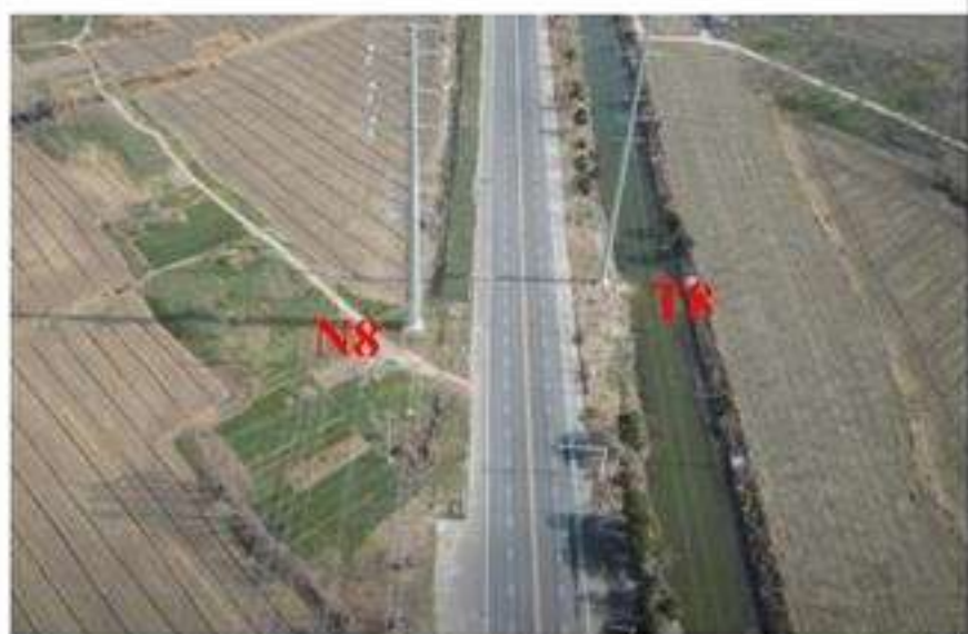
塔基 N8 复耕、T8 植被恢复 (2023.1.11)
