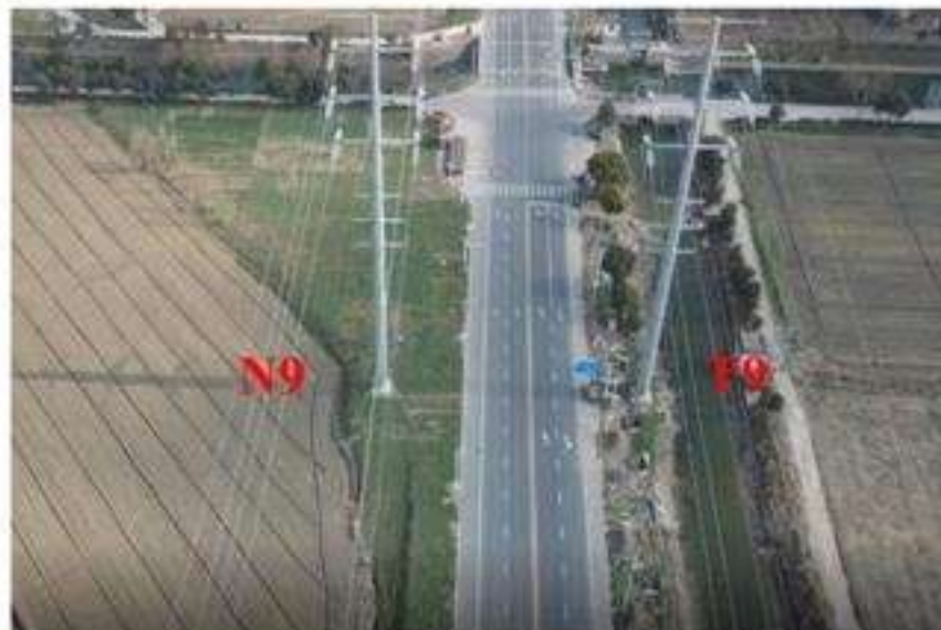
塔基 N9 复耕、T9 植被恢复 (2023.1.11)
