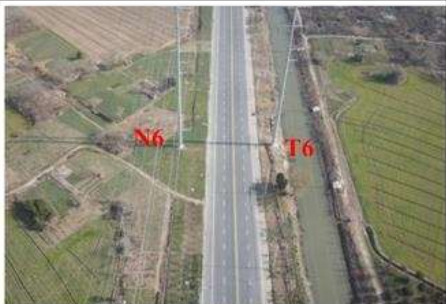
塔基 N6 复耕、T6 植被恢复 (2023.1.11)
