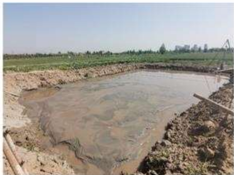
塔基及塔基施工区泥浆池 (2022.3.16)
