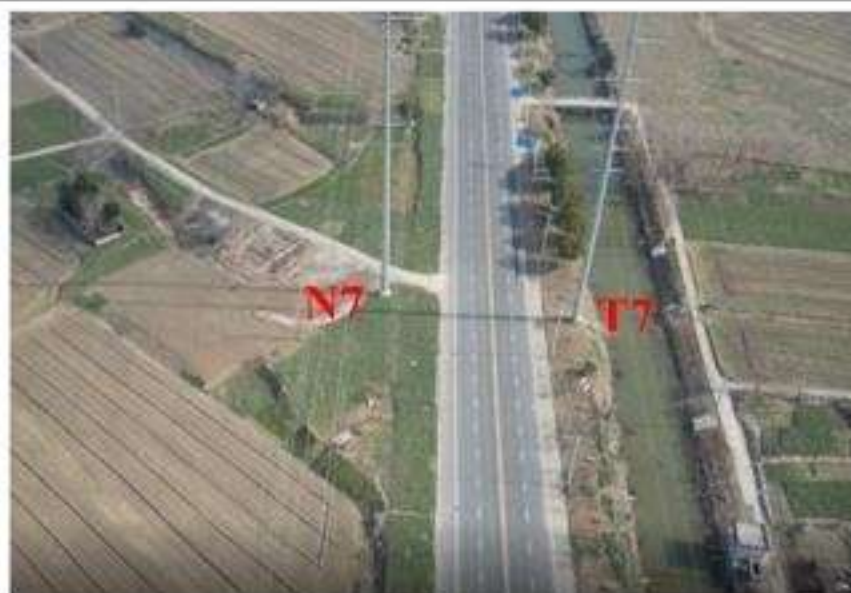
塔基 N7 复耕、T7 植被恢复 (2023.1.11)
