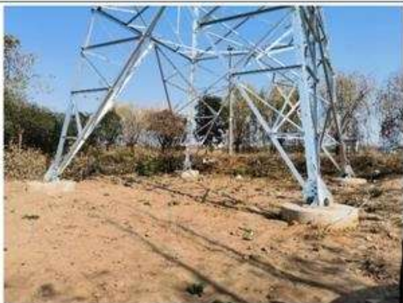
塔基及塔基施工区土地整治（2022.10.25）
