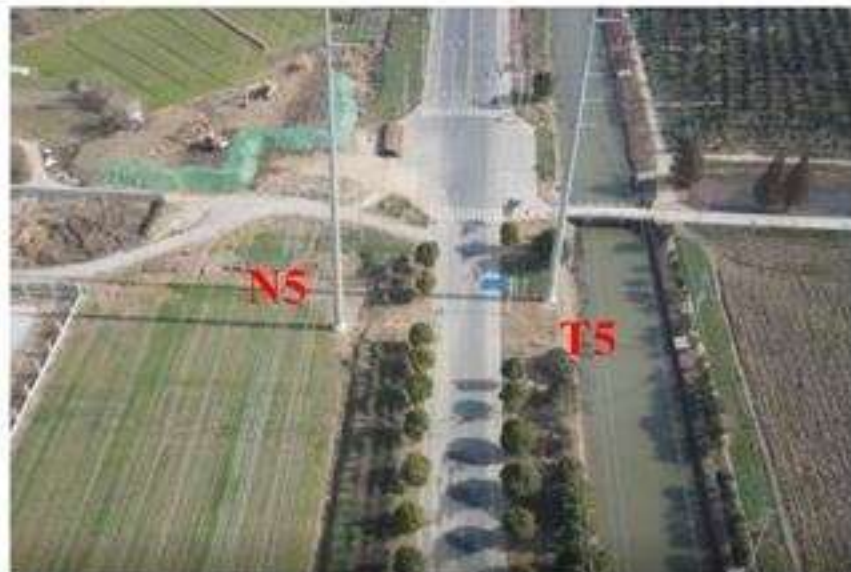
塔基 N5 复耕、T5 植被恢复 (2023.1.11)
