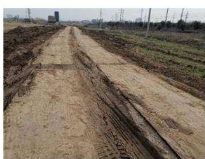
施工临时道路区铺设钢板 (2022.3.16)
