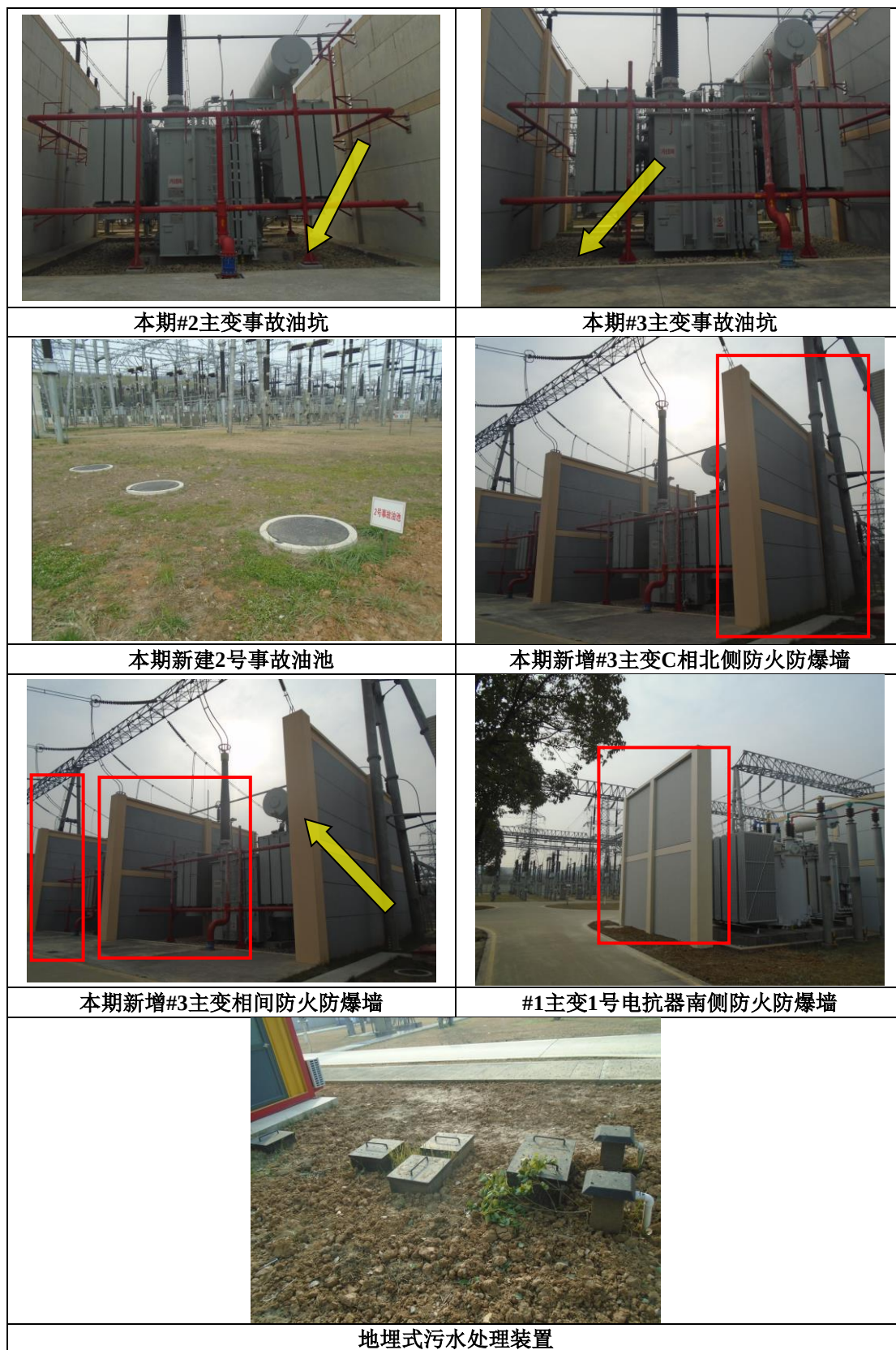
图 5-1 设计阶段环保措施落实情况照片
