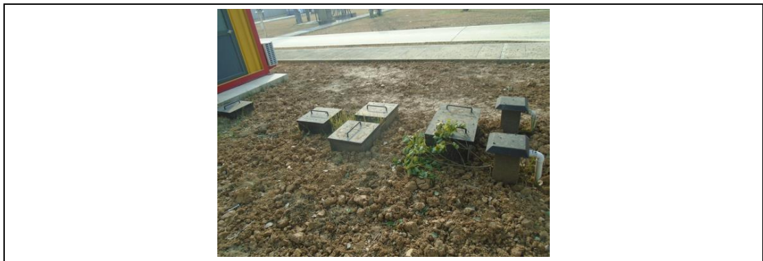
图 9-1 龙王山 500kV 变电站内地埋式污水处理设施
