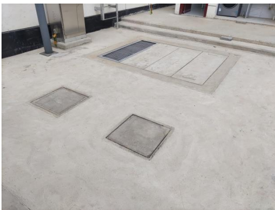
图 9.2-1 青龙山变电站化粪池
