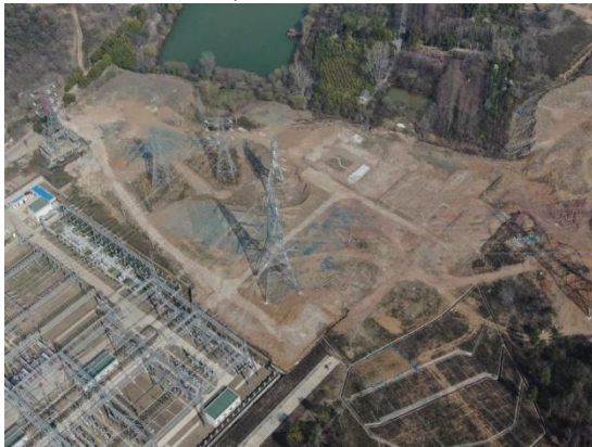
青龙山变电站站外临建场地平整
