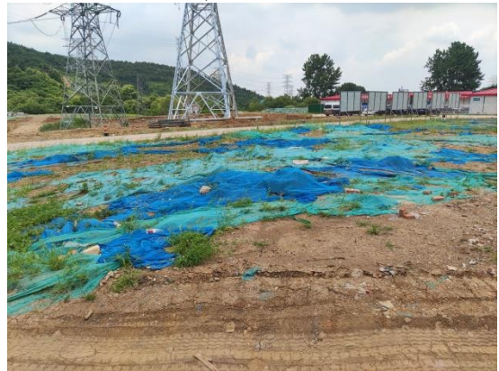
牵张场临时占地恢复
