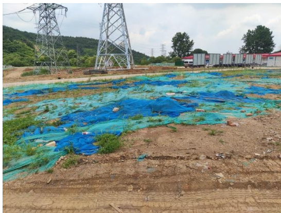
施工期防尘网苫盖
