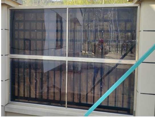
青龙山变电站实体围墙
