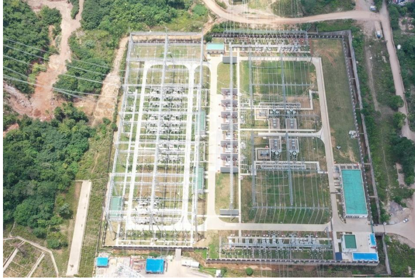
青龙山变电站
