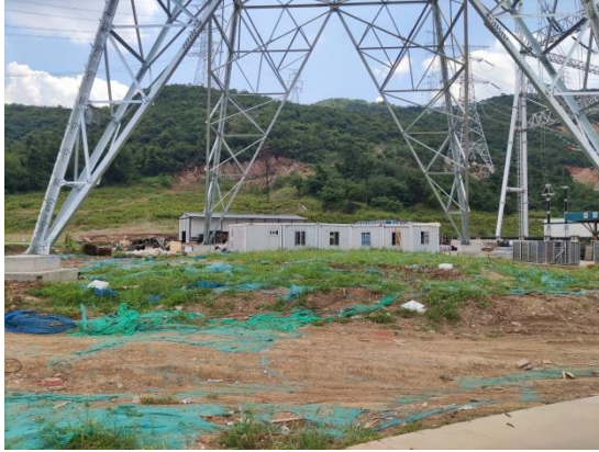
500kV 龙青 5261 线\500kV 龙石 5262 线 42 号塔基
