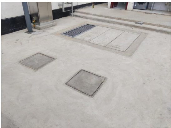
青龙山变电站化粪池
