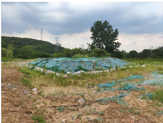
施工期临时堆土苫盖
