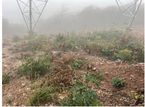
500kV 青东 5W21 线\500kV 青桥 5W22 线 4 号塔基
