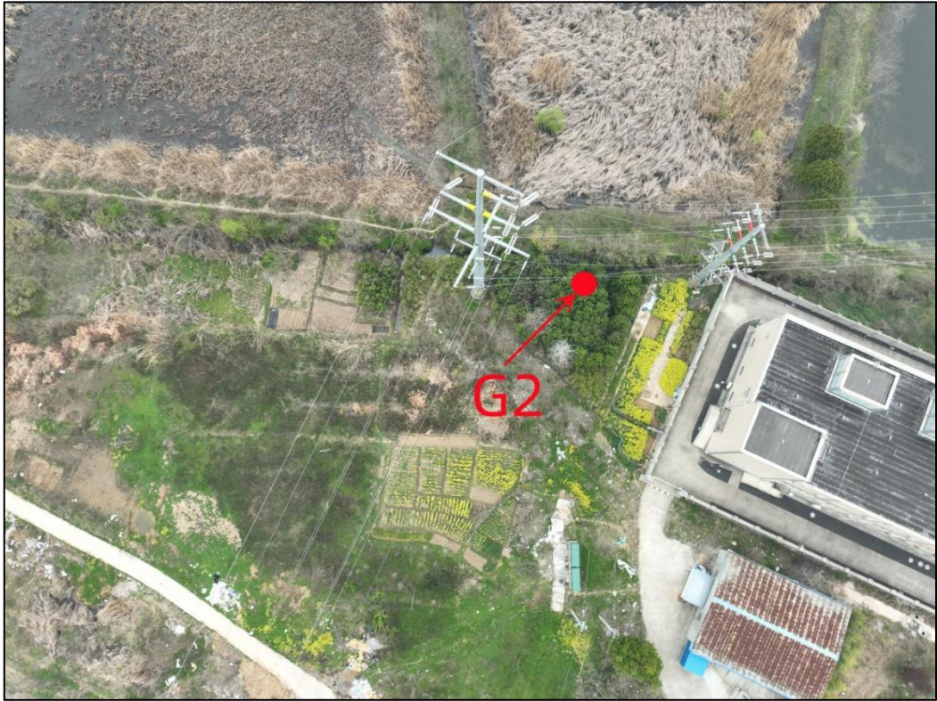
图 1.1-6 北城变现场照片 (拍摄时间: 2023 年 3 月 20 日)
