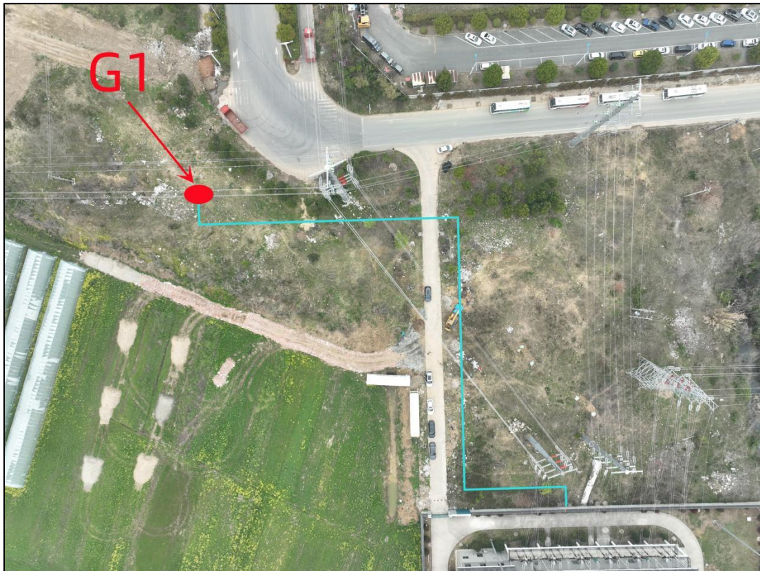
图 1.1-7 凤来变现场照片（拍摄时间：2023 年 3 月 20 日）
