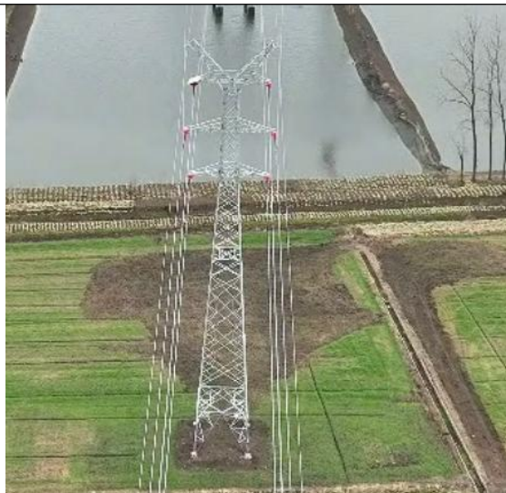
T39 塔基及塔基施工区复耕
