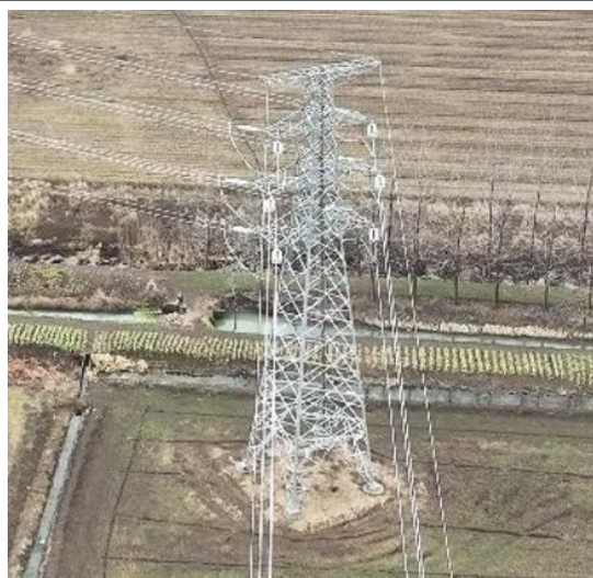
T49 塔基及塔基施工区复耕
