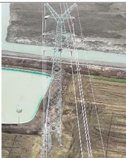
T45 塔基及塔基施工区复耕
