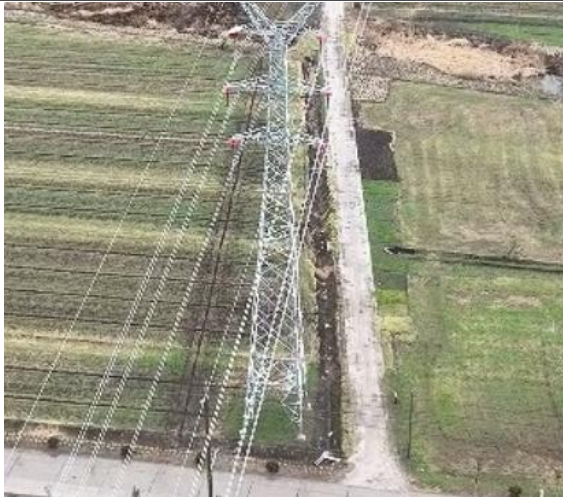
T33 塔基及塔基施工区复耕
