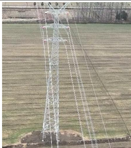
T38 塔基及塔基施工区复耕
