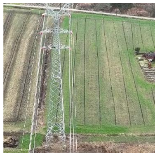
T34 塔基及塔基施工区复耕
