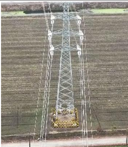
T13 塔基及塔基施工区复耕
