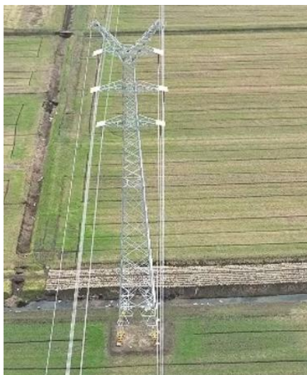
T25 塔基及塔基施工区复耕
