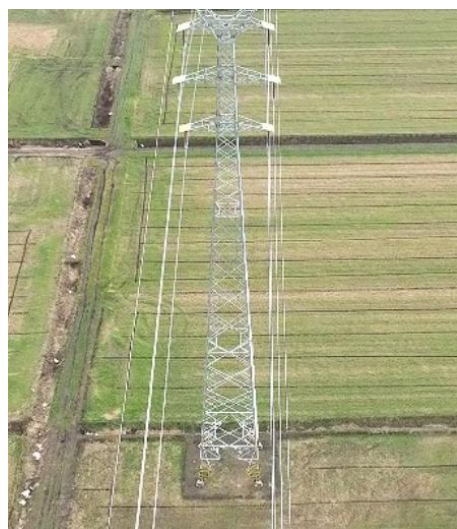
T26 塔基及塔基施工区复耕
