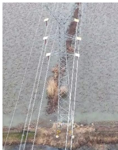
T16 塔基及塔基施工区复耕
