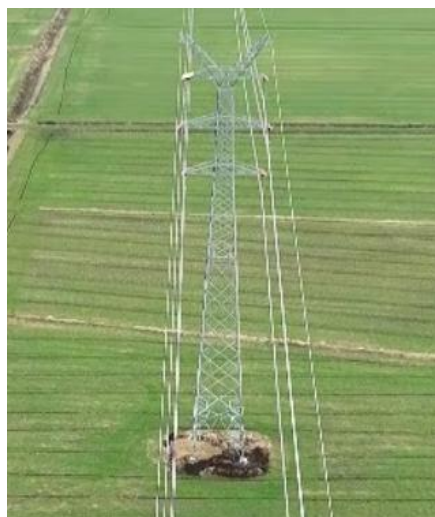
T46 塔基及塔基施工区
