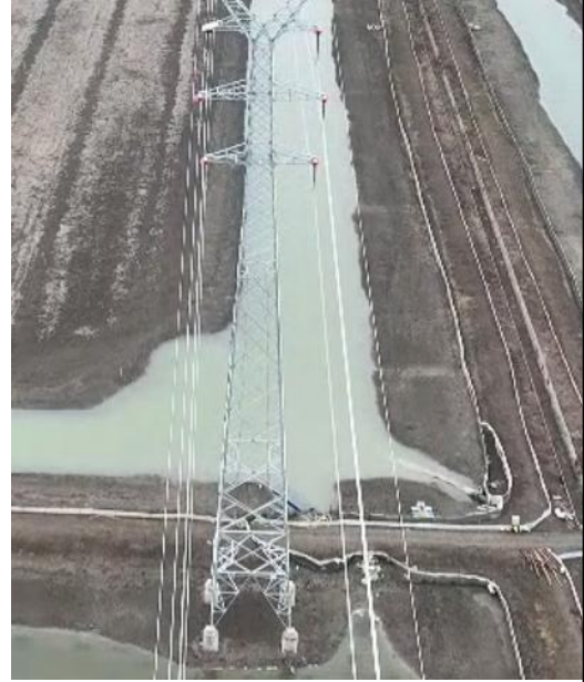
T42 塔基及塔基施工区
