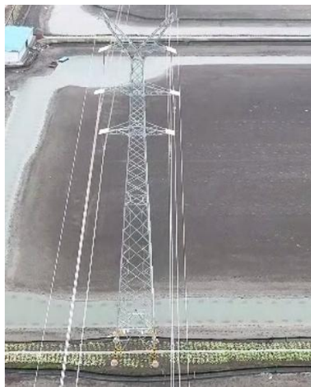
T14 塔基及塔基施工区复耕
