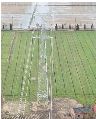
T15 塔基及塔基施工区复耕
