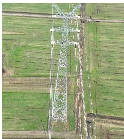
T28 塔基及塔基施工区复耕
