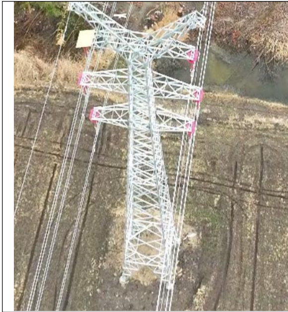
T31 塔基及塔基施工区复耕
