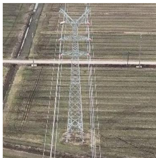
T48 塔基及塔基施工区
