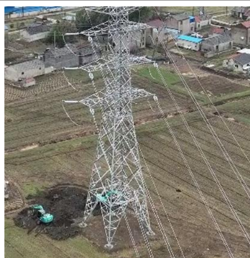
T50 塔基及塔基施工区
