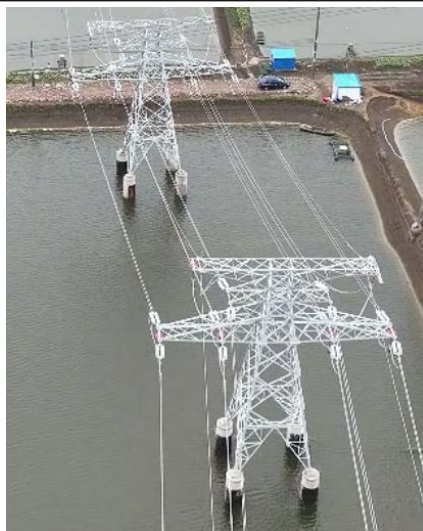
T40 塔基及塔基施工区
