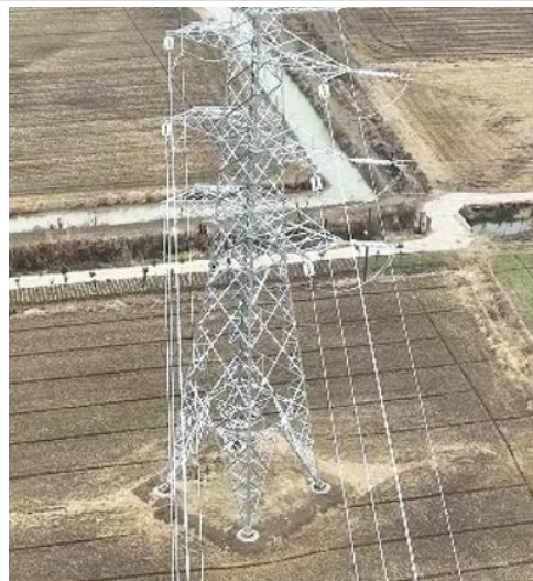
T30 塔基及塔基施工区复耕
