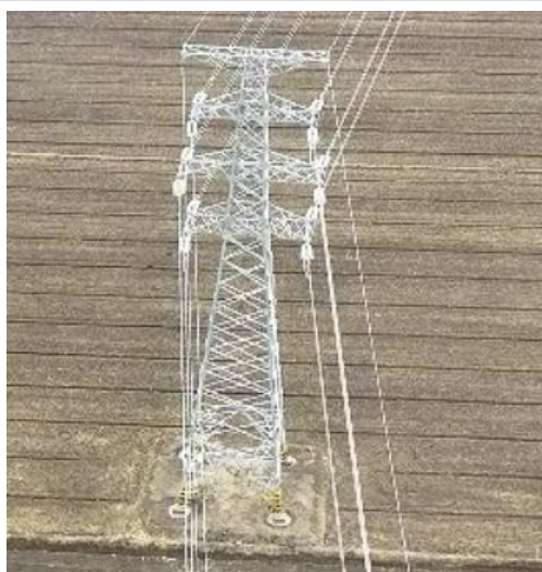
T29 塔基及塔基施工区复耕
