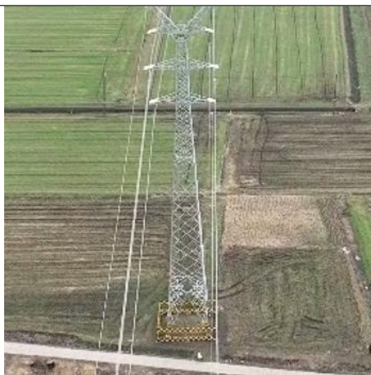
T27 塔基及塔基施工区复耕
