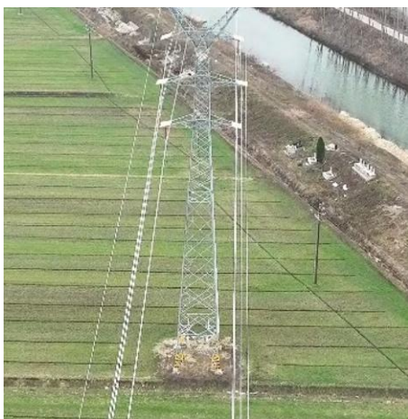
T17 塔基及塔基施工区复耕
