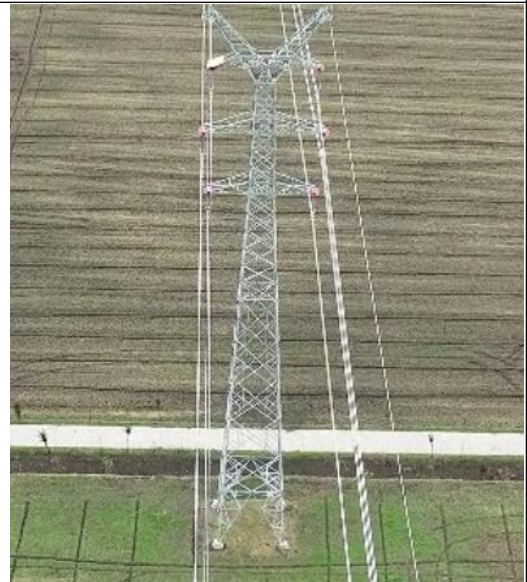
T44 塔基及塔基施工区
