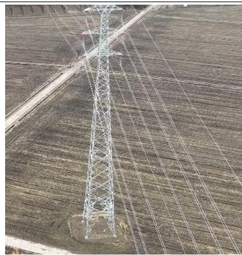
T36 塔基及塔基施工区复耕
