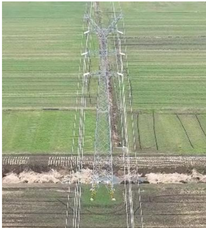
T12 塔基（完工后）
