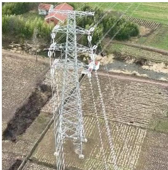
T37 塔基及塔基施工区复耕
