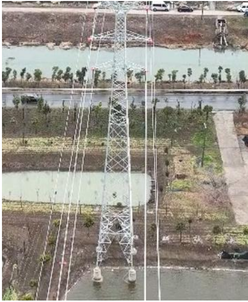
T41 塔基及塔基施工区复耕
