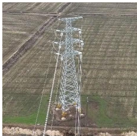
T18 塔基及塔基施工区复耕
