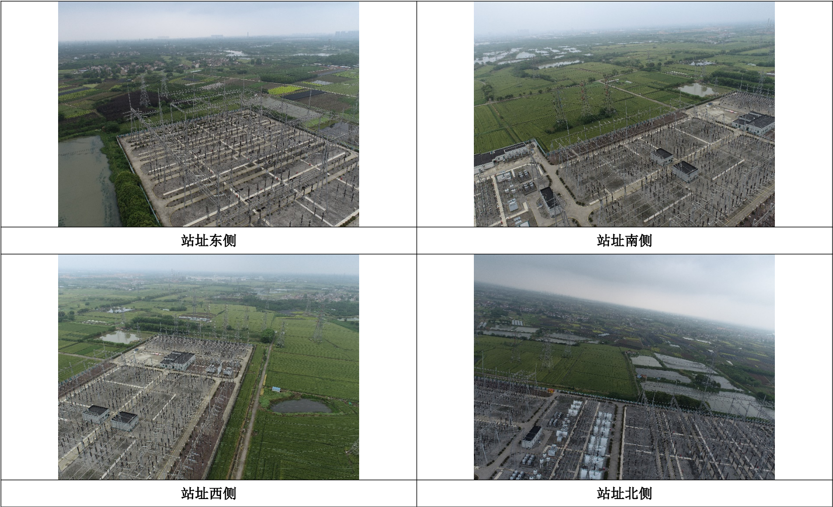
图 3.2 变电站周围情况
