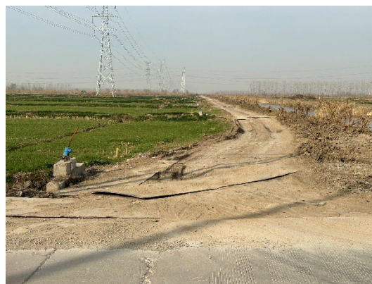
施工临时道路区钢板铺垫
