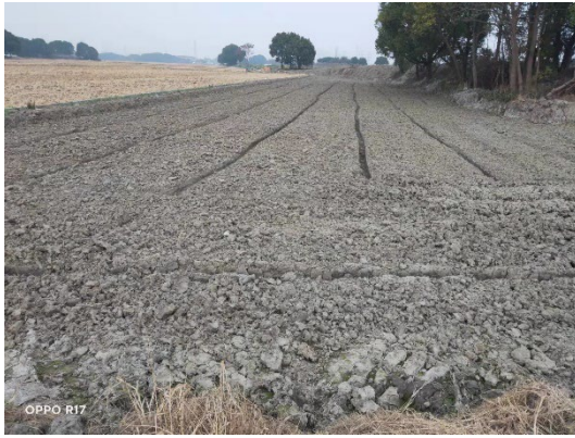
施工临时道路区土地整治
