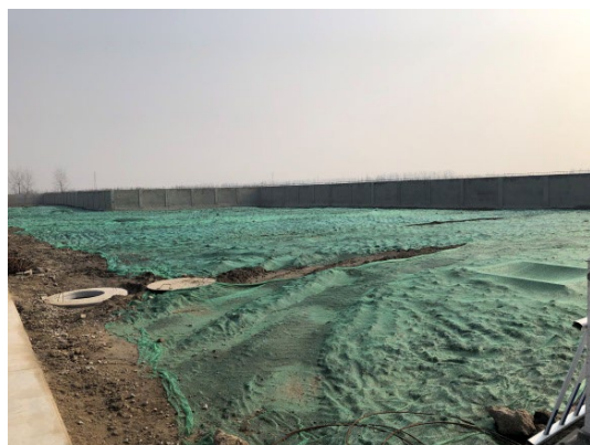
扩建间隔区防尘网苫盖
