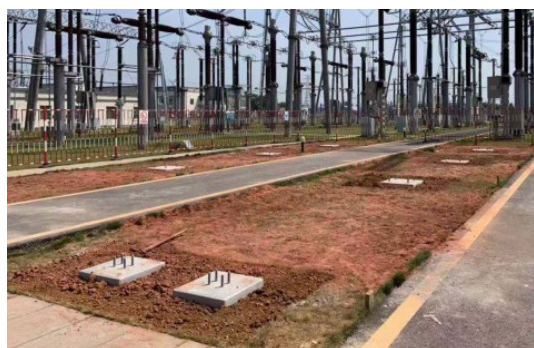
扩建间隔区土地整治
