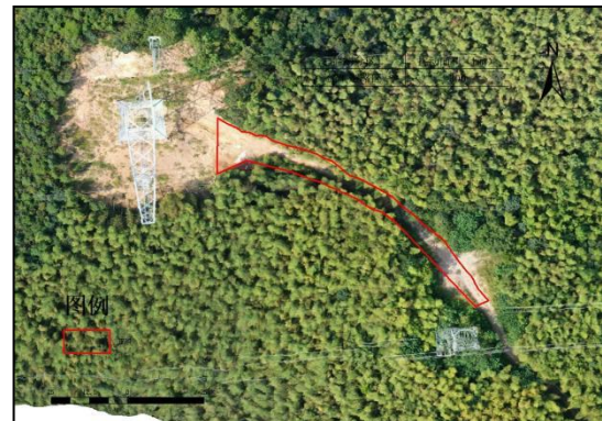
N7478施工道路区扰动面积解译图-9月
