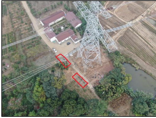
N7402-N7403跨越场地区面积解译图-12月
