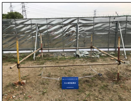
换流站进站道路区
