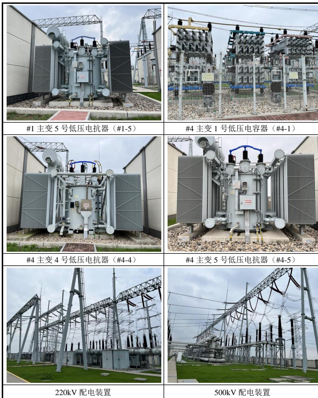
图 3.3-1 徐圩 500kV 变电站前期工程内部设施
