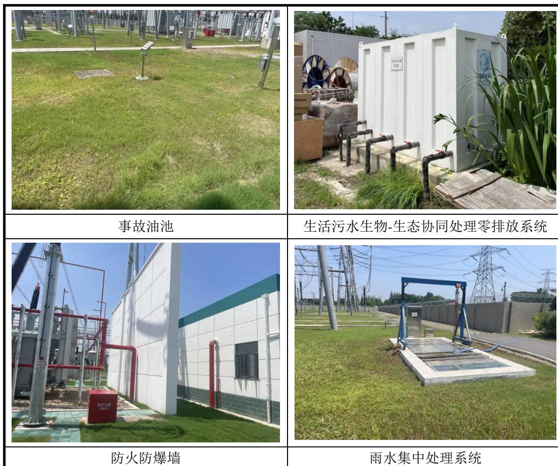
图 3.3-2 三官殿 500kV 变电站前期项目的环保设施
