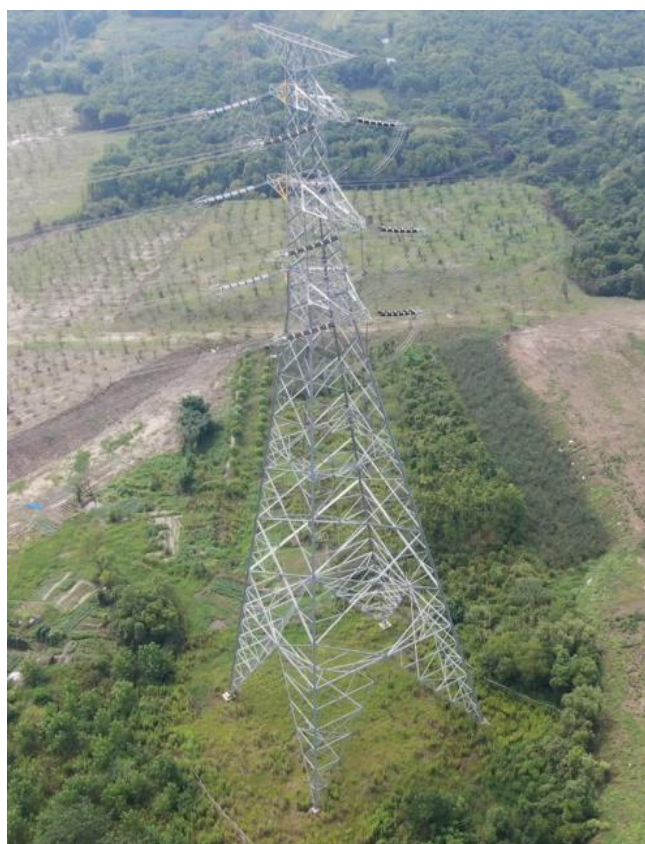
塔基及塔基施工区图-8月
