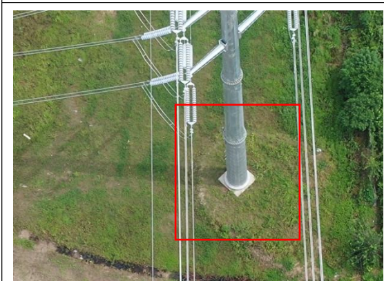
塔基区 T19 撒播草籽 (2023.8)
