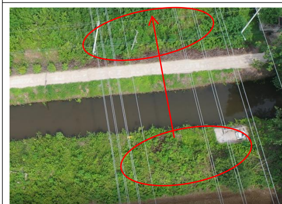
牵张及跨越场区 撒播草籽（2023.8）
