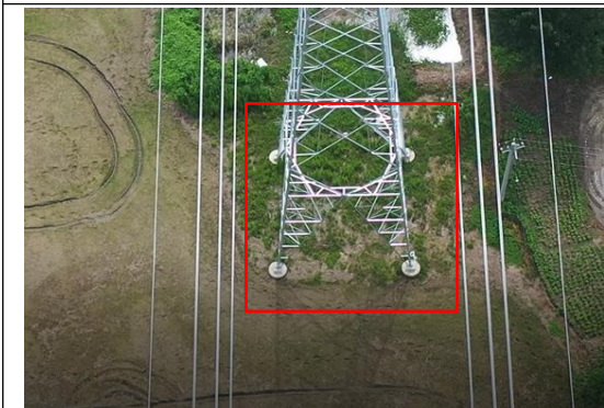
塔基区 T11 复耕 (2023.8)
