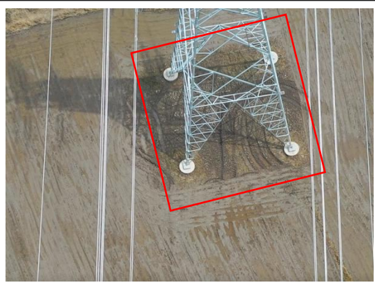
塔基区 T8 复耕 (2023.8)
