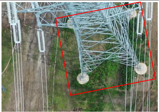
塔基区 T28 撒播草籽 (2023.8)
