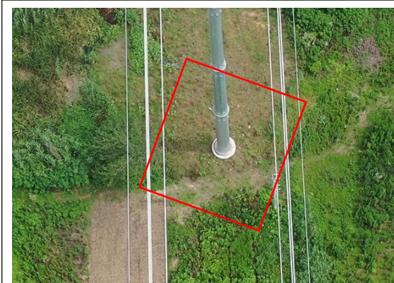
塔基区 T21 撒播草籽 (2023.8)
