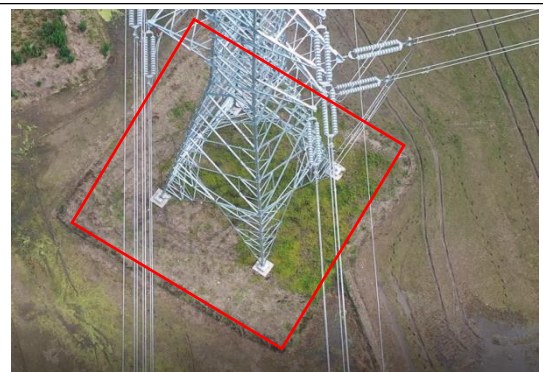
塔基区 T12 复耕 (2023.8)
