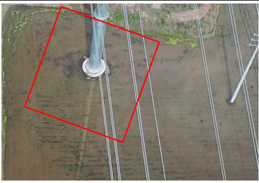
塔基区 T24 复耕 (2023.8)
