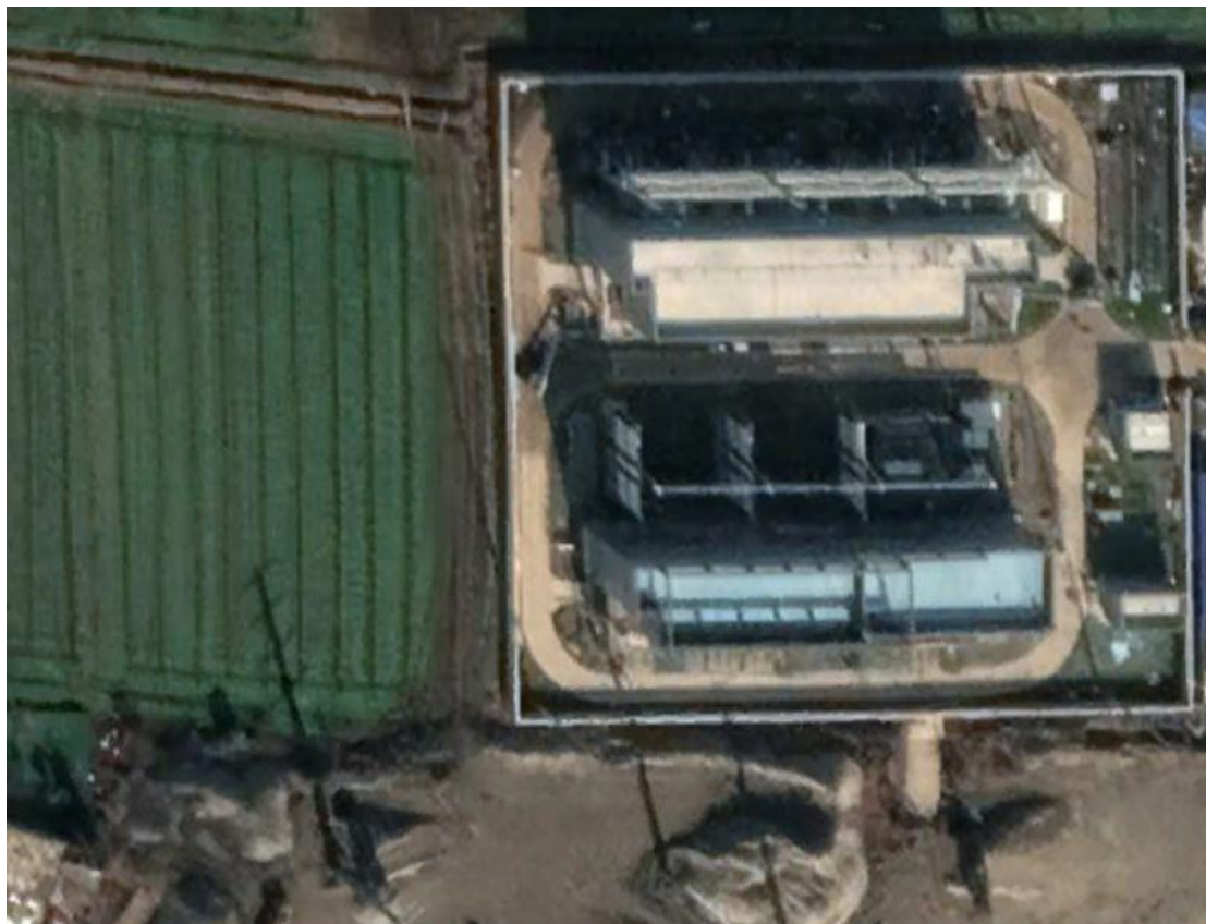
越江变间隔扩建区施工前遥感影像图（2021.12）
