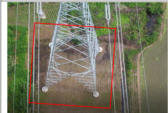
塔基区 T13 复耕 (2023.8)
