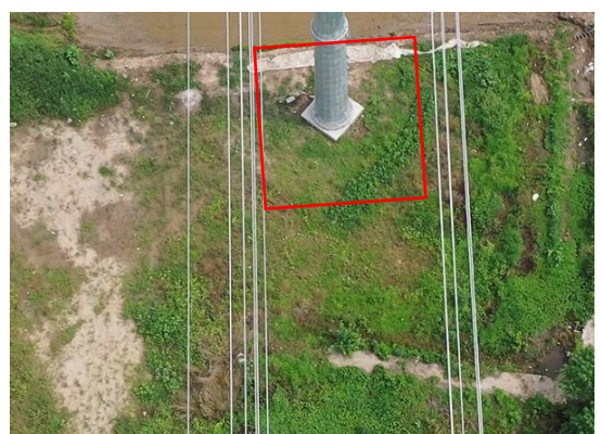
塔基区 T18 撒播草籽 (2023.8)
