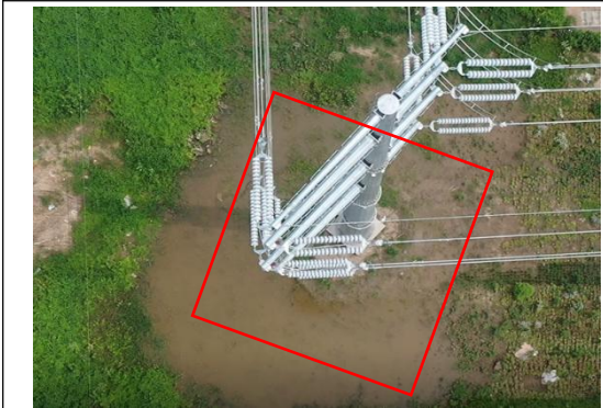
塔基区 T23 撒播草籽 (2023.8)
