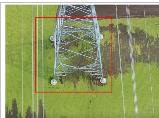
塔基区 T15 复耕 (2023.8)
