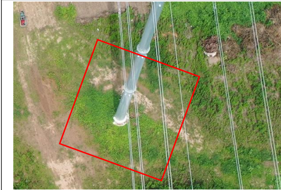
塔基区 T25 撒播草籽 (2023.8)
