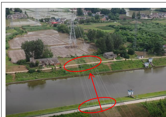
牵张及跨越场区 撒播草籽+复耕（2023.8）
