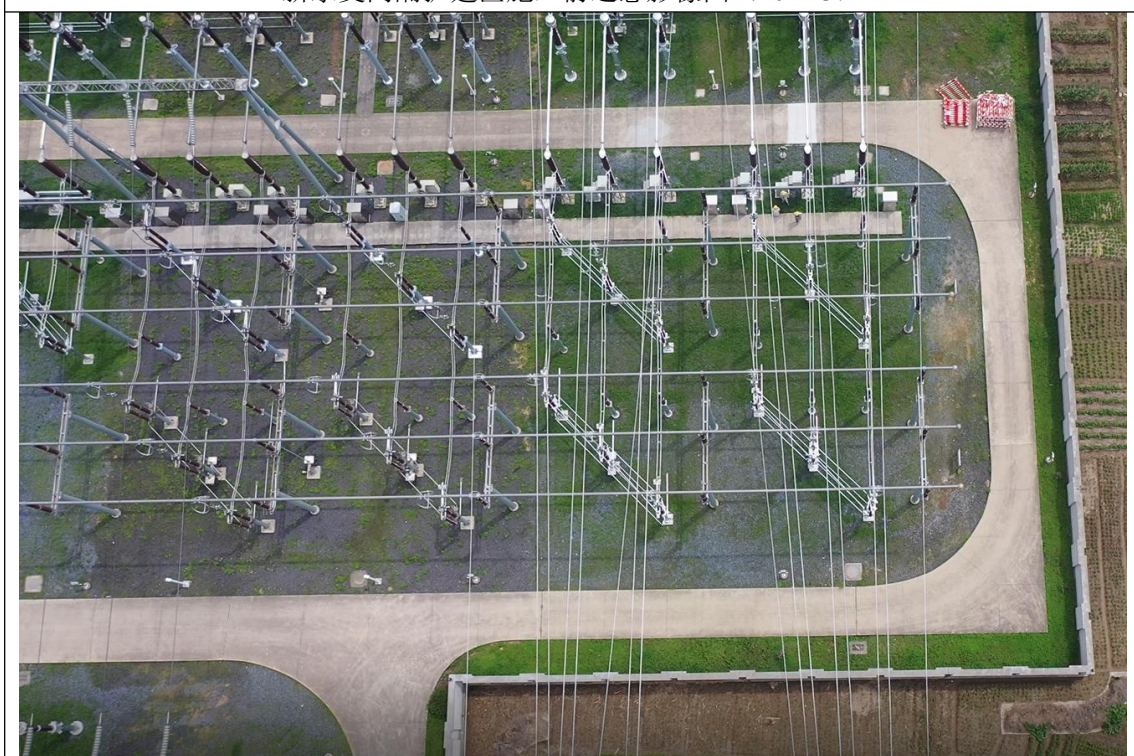
新东变间隔扩建区施工后遥感影像图（2023.8）
