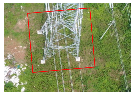
塔基区 T26 撒播草籽 (2023.8)
