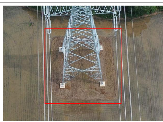
塔基区 T16 复耕 (2023.8)
