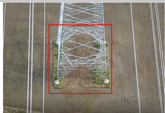
塔基区 T14 复耕 (2023.8)
