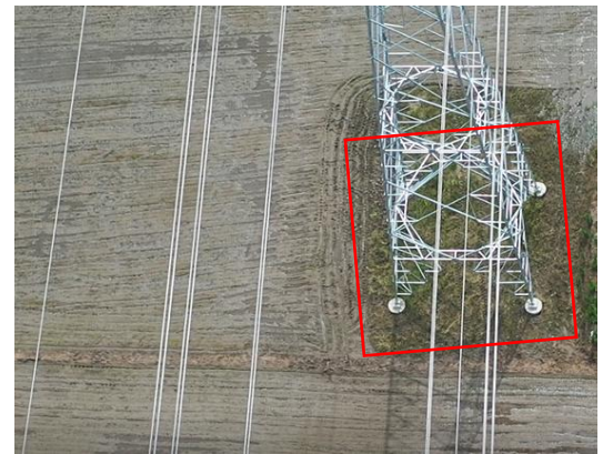
塔基区 T10 复耕 (2023.8)
