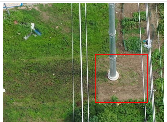
塔基区 T20 撒播草籽 (2023.8)
