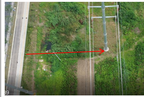
施工临时道路区 撒播草籽 (2023.8)
