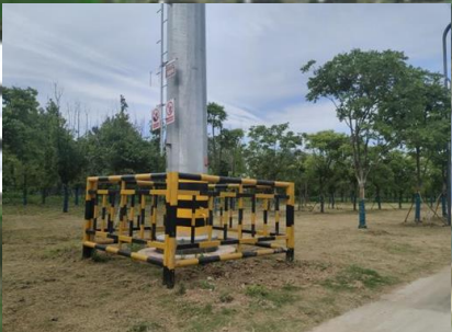
塔基区 撒播草籽恢复情况
