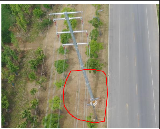
塔 N8 撒播草籽 (2023 年 8 月)
