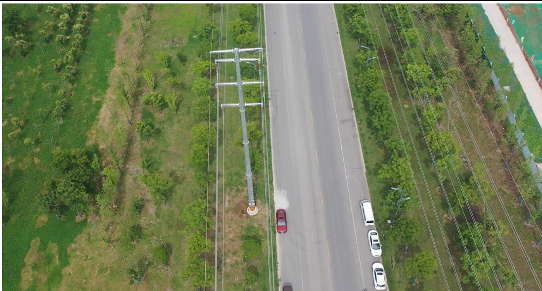
塔基 N8 施工前影像（2020.03）
