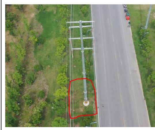
塔 N11 撒播草籽 (2023 年 8 月)
