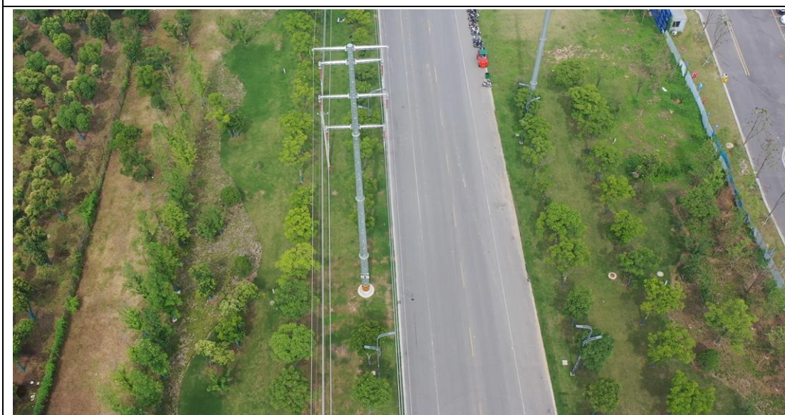
塔基 N12 施工后影像（2023.08）
