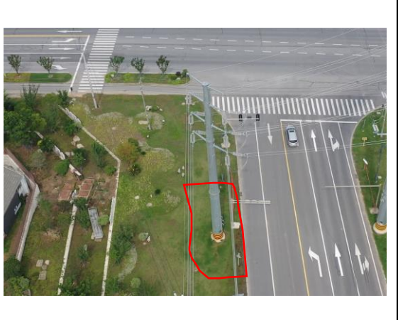
塔 N12 撒播草籽 (2023 年 8 月)
