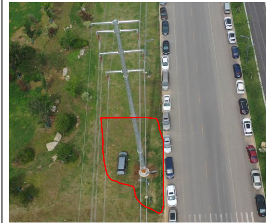
塔 N9 撒播草籽 (2023 年 8 月)
