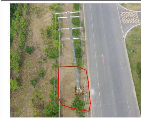
塔 N7 撒播草籽 (2023 年 8 月)
