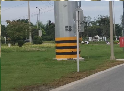
塔基区 撒播草籽恢复情况
