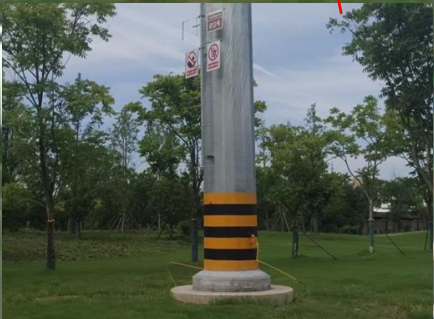
塔基区 撒播草籽恢复情况
