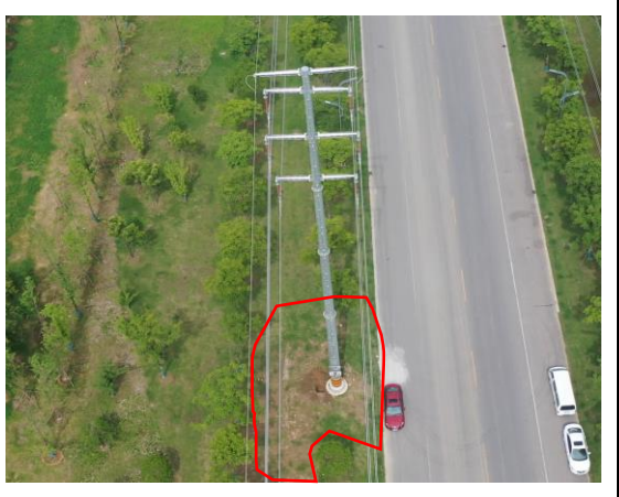
塔 N10 撒播草籽 (2023 年 8 月)
