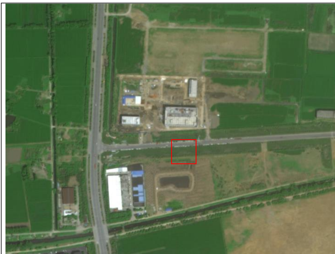
塔基 N12 施工前影像（2020.03）
