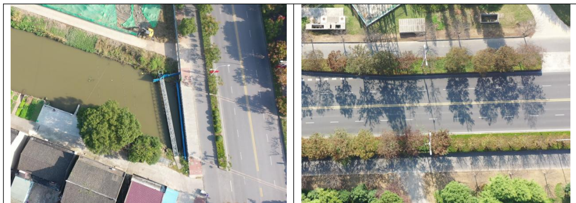
图 1.1.5 跨越处现场照片
