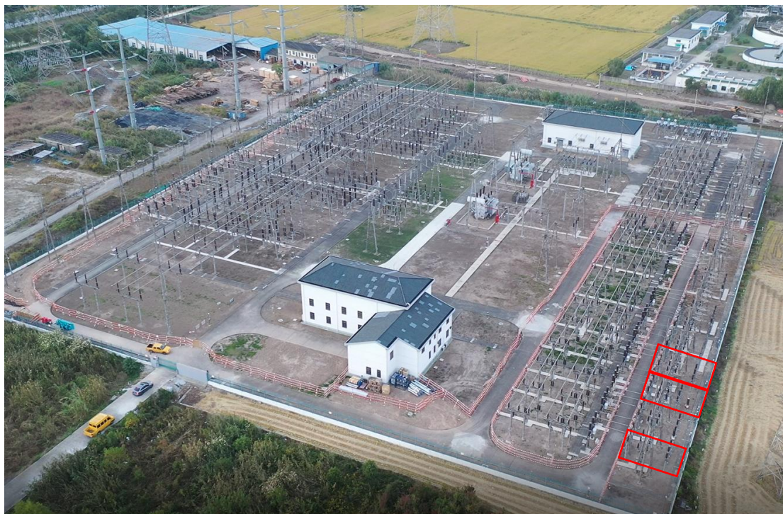
图 1.1-2 本期园区 220kV 变电站 110kV 间隔改造工程现场照片
