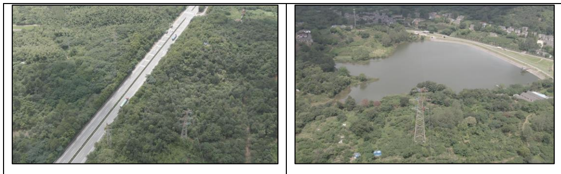
图 1.1.3 跨越处现场照片
