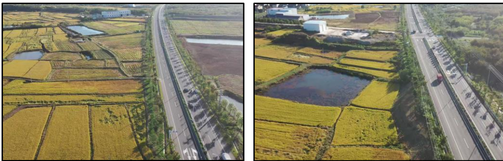
图 1.1-3 国能宝堰光伏升压站~丹徒 110 千伏线路工程沿线现状照片
