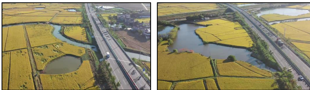
图 1.1.4 跨越处现场照片
