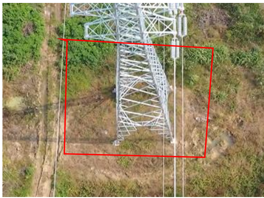
塔基区 T14 撒播草籽 (2023.11)
