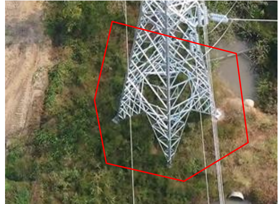
塔基区 T16 撒播草籽 (2023.11)
