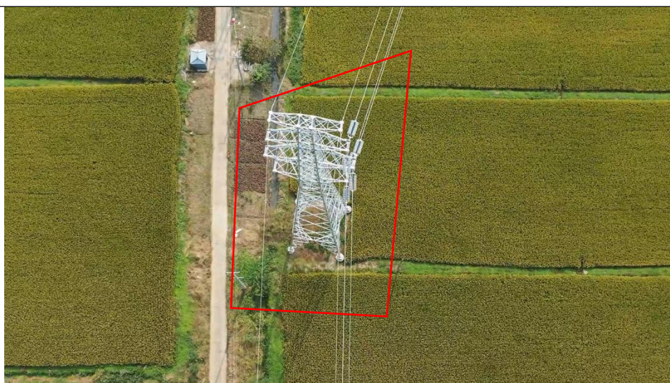
塔基及塔基施工区T7角钢塔复耕现状（2023.11）
