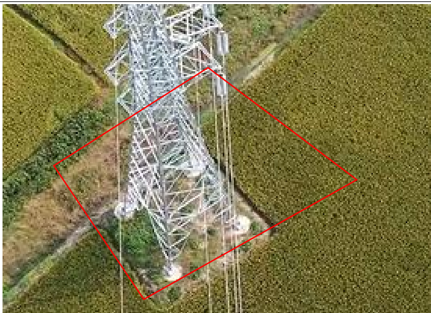
塔基及塔基施工区T10角钢塔复耕现状（2023.11）
