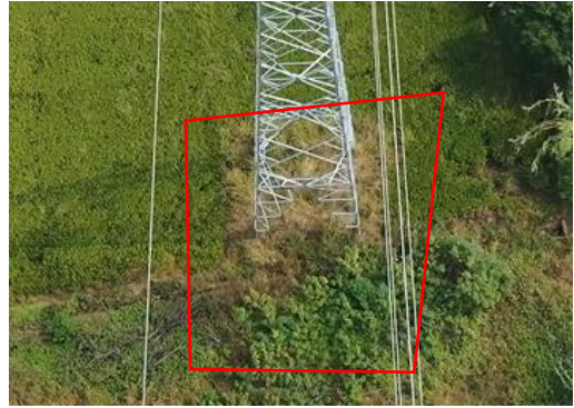
塔基区 T13 复耕 (2023.11)
