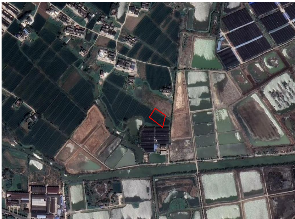
塔基及塔基施工区T10角钢塔施工前（2023.03）
