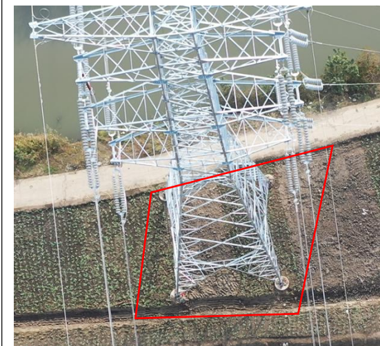
塔基区 T6 复耕 (2023.11)
