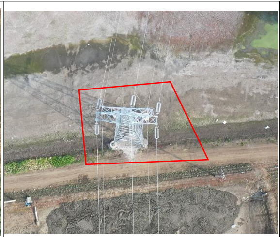
塔基区 T3 恢复鱼塘 (2023.11)
