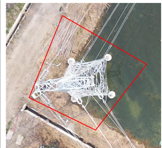
塔基区 T7 恢复鱼塘 (2023.11)
