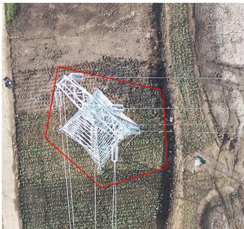
塔基区T5角钢塔复耕现状（2023.11）
