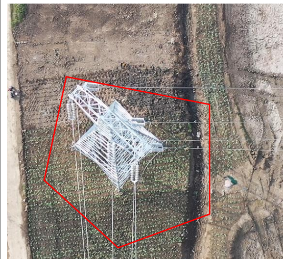
塔基区 T5 复耕 (2023.11)
