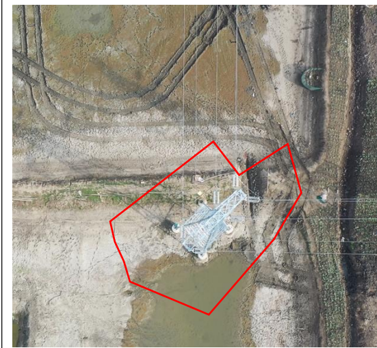
塔基区 T4 恢复鱼塘 (2023.11)
