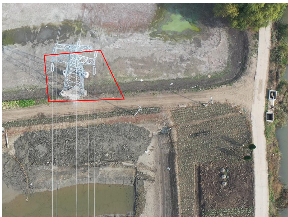
塔基区T3角钢塔恢复原貌现状（2023.11）
