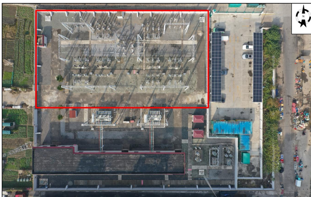
图 1.1-2 八里 110 千伏变电站改造工程站址现状（红线框为改造区域）
