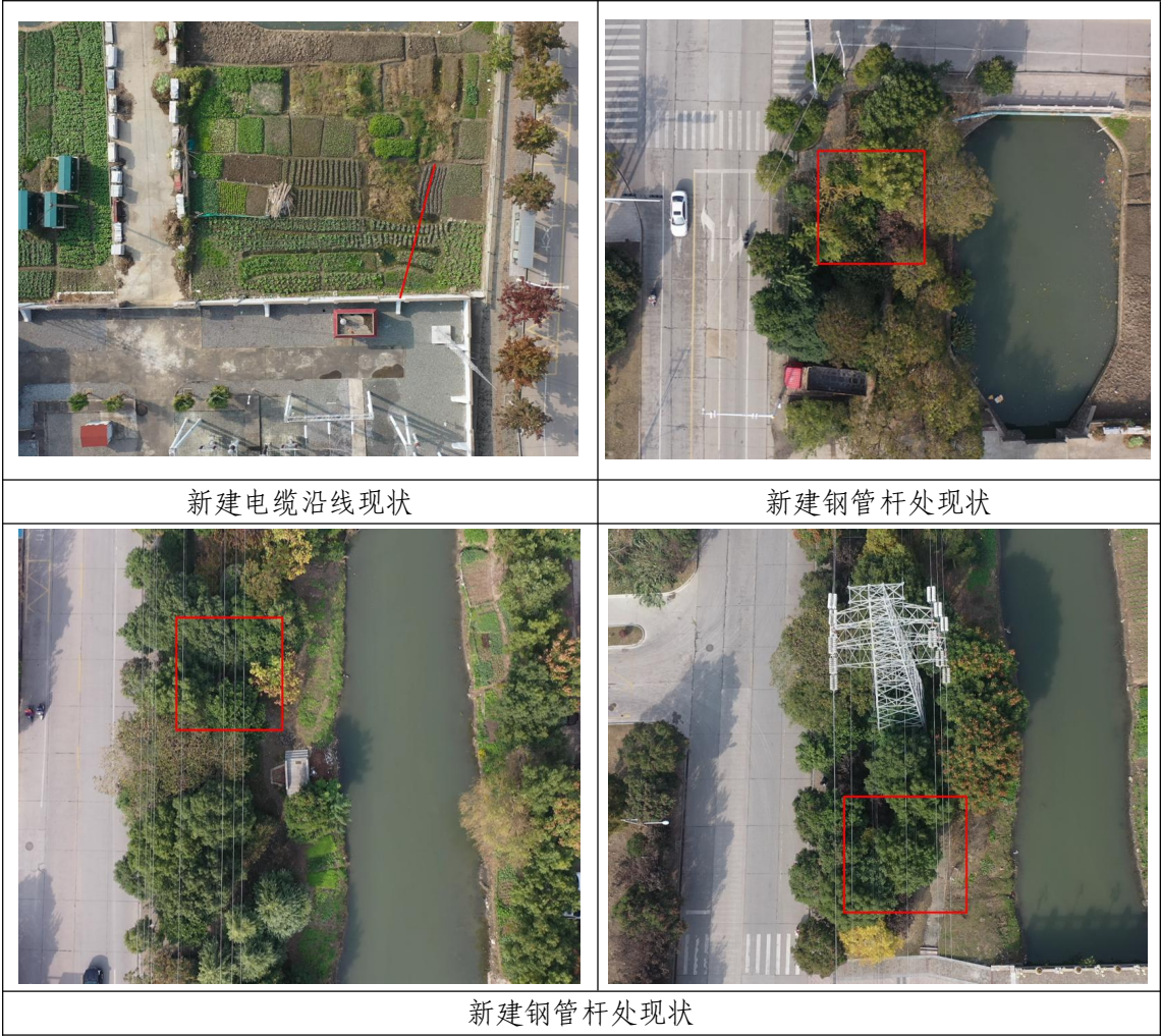
图 1.1-5 线路工程现状照片
