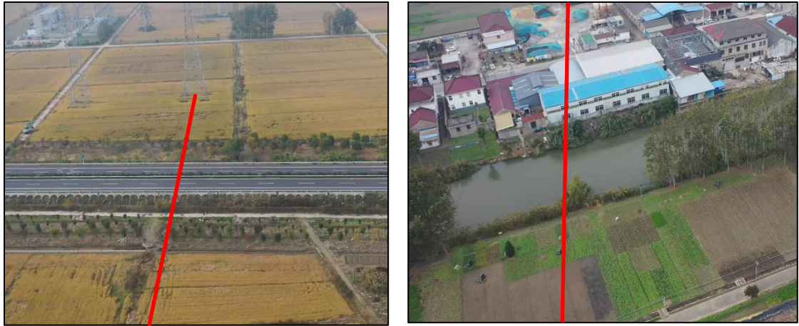
图 1.1.3 跨越处现场照片
